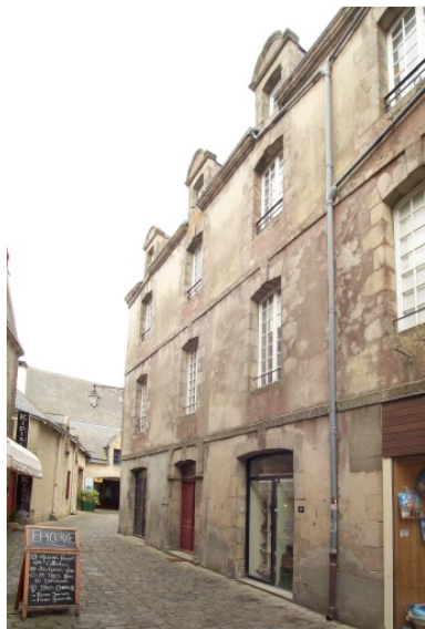
Vue du mur gouttereau bordant la rue de la Juiverie. Phot. Denis Pillet IVR52_20074400886NUCA
