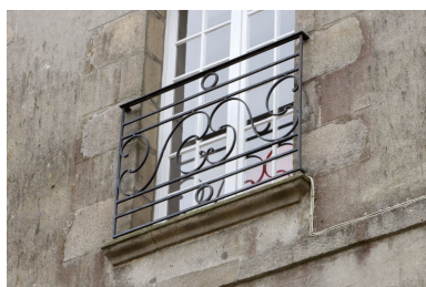
Porte fenêtre avec garde corps en fer forgé. Phot. Denis Pillet IVR52_20074401098NUCA
