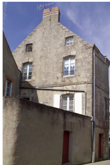
Vue du pignon sud. Phot. Denis Pillet IVR52_20074400754NUCA
