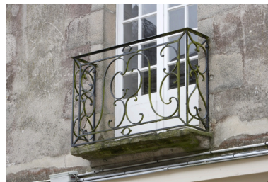
Balconnet avec garde corps en fer forgé. Phot. Denis Pillet IVR52_20074401097NUCA
