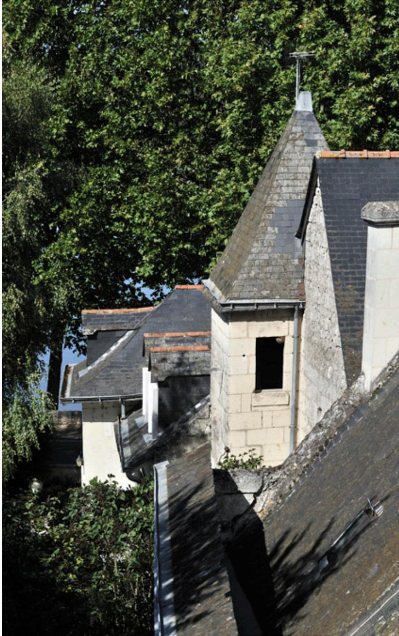
Toitures, avec notamment détail du chéneau entre égout du toit et attique traité en entablement.
