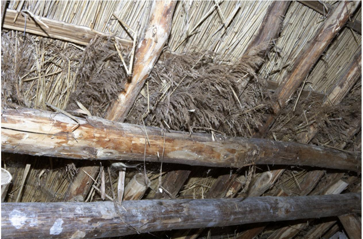
Étable sud. Détail de la fixation des bouchon de roseau.
