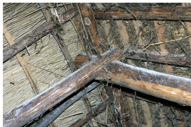
Étable sud. Détail d'un assemblage à mi-bois boulonné.
