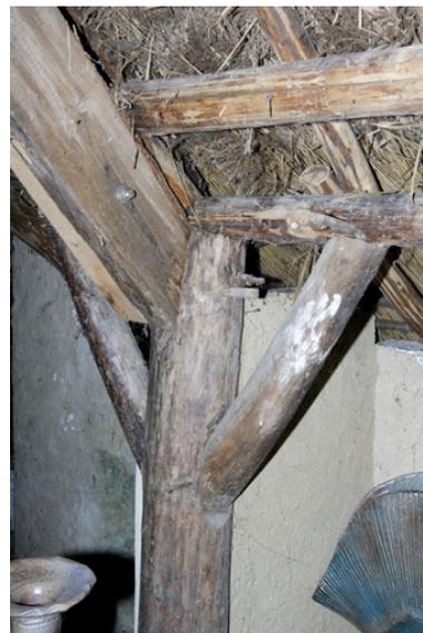
Étable sud. Détail d'un poteau de soutient de la charpente.
