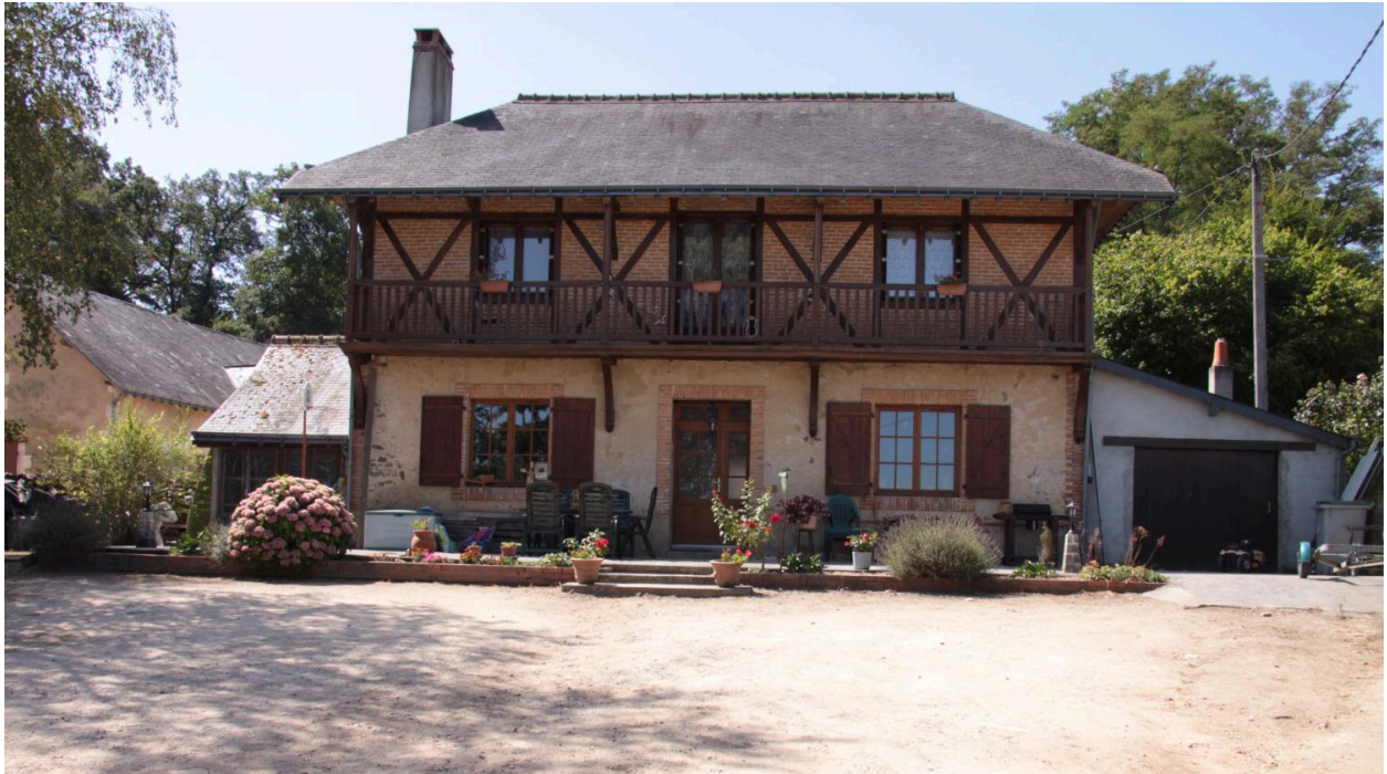
Vue générale du châtelet.
