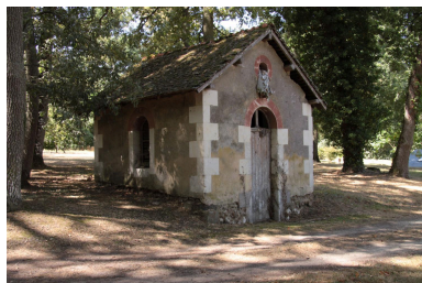
Faisanderie, vue en volume Phot. Jean-Baptiste Darrasse IVR52_20097200440NUCA
