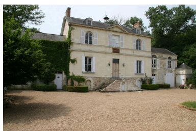
Le logis principal : vue d'ensemble.
