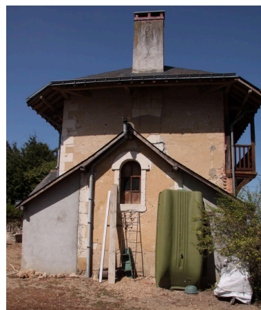
Châtelet, vue du pignon Phot. Jean-Baptiste Darrasse IVR52_20097200435NUCA
