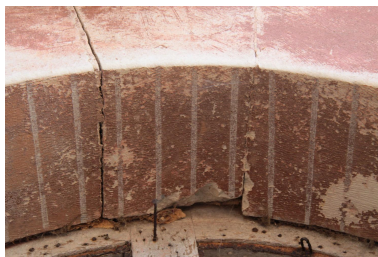
Faux appareillage de briques sur les baies de la faisanderie Phot. Jean-Baptiste Darrasse IVR52_20097200444NUCA
