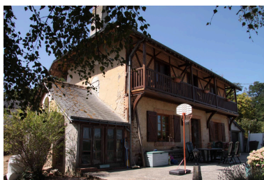
Vue de volume du châtelet. Phot. Jean-Baptiste Darrasse IVR52_20097200434NUCA
