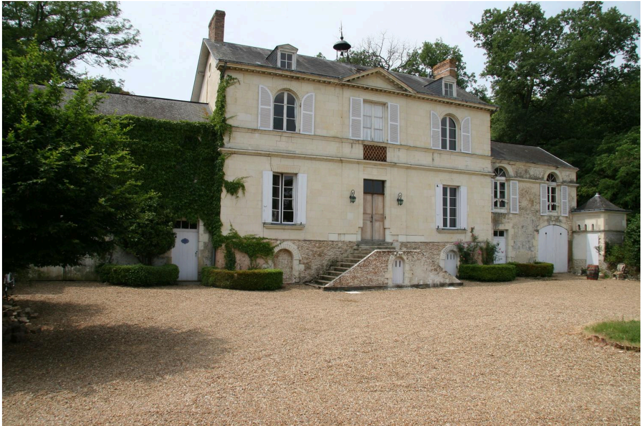
Le logis principal : vue d'ensemble.
