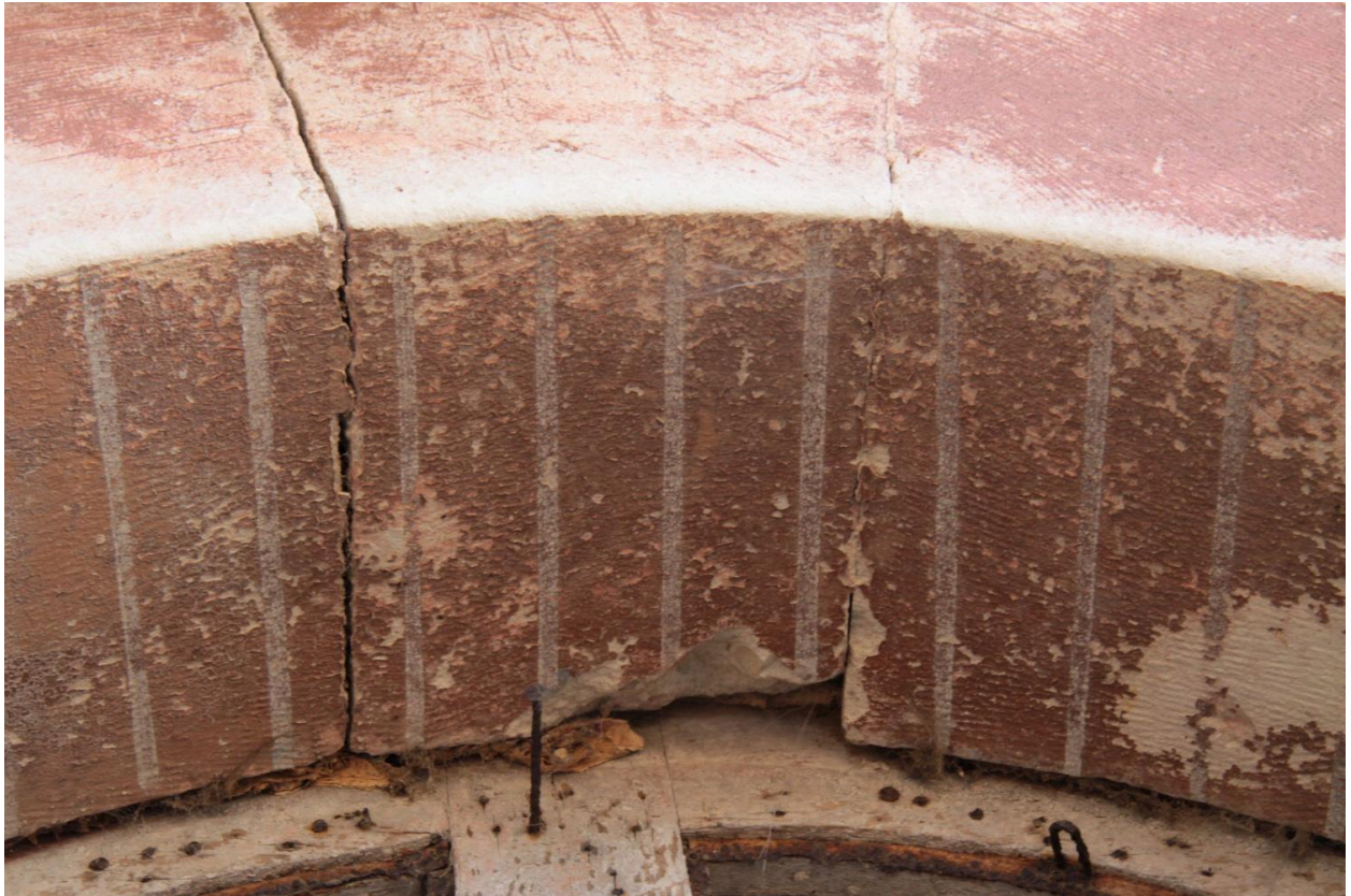
Faux appareillage de briques sur les baies de la faisanderie
