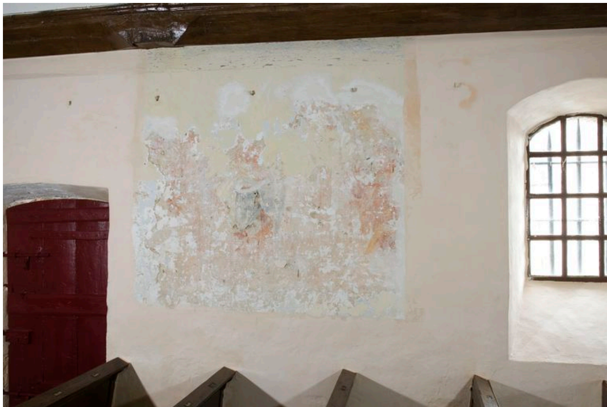
Nef, mur sud. Situation de la zone de découverte.
