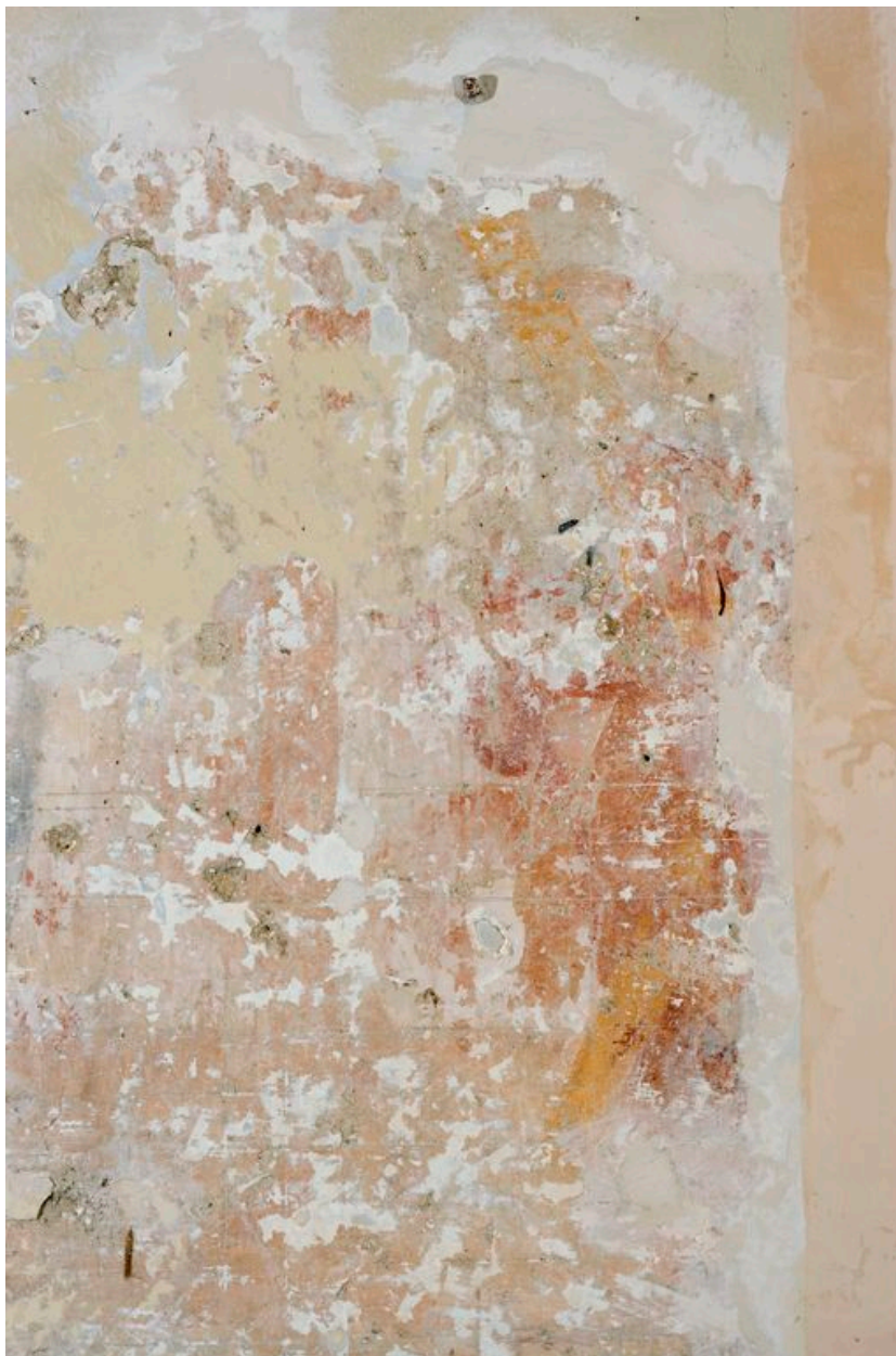
Nef, mur sud. La zone de découverte, partie droite : saint André partiellement dégagé.
