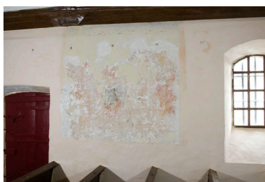
Nef, mur sud. Situation de la zone de découverte.
