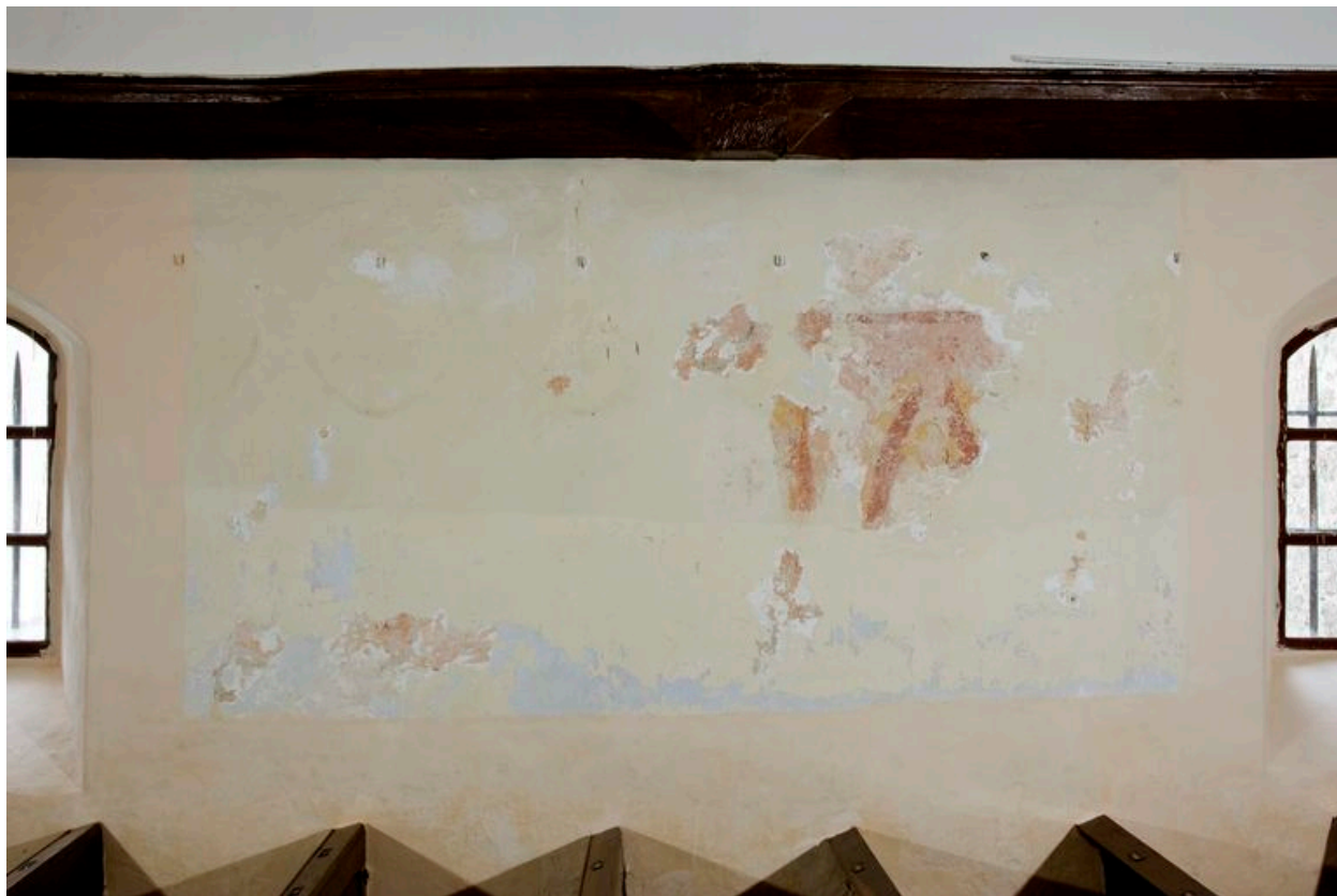
Nef, mur nord. Situation de la zone de découverte.
