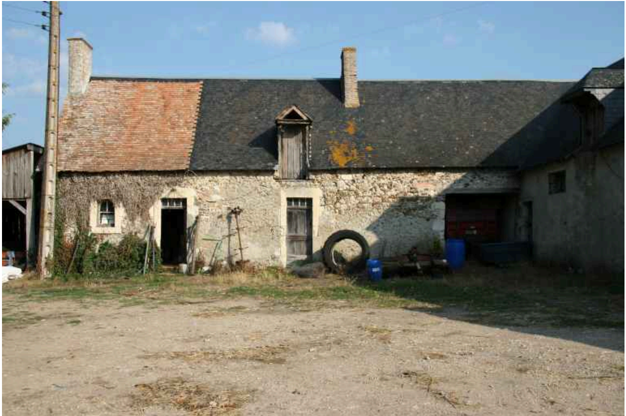
La maison : façade sur cour.
