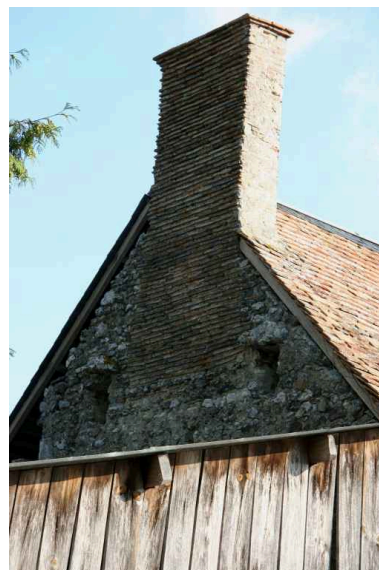
La maison, salle gauche : souche de cheminée de briques minces. Phot. Jean-Baptiste Darrasse IVR52_20067206480NUCA
