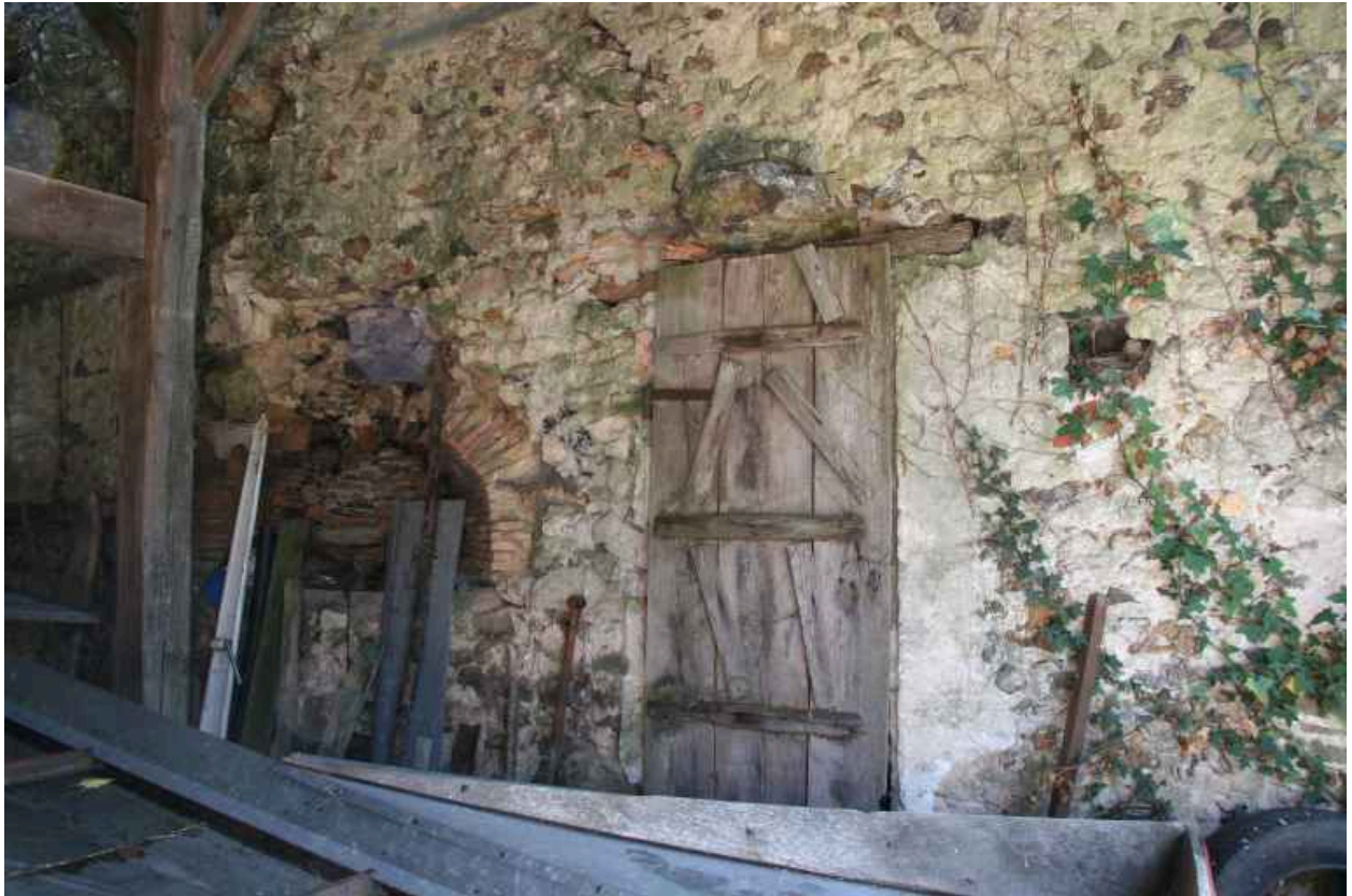
Le pignon de la maison sous l'appenti : vestiges d'un four.
