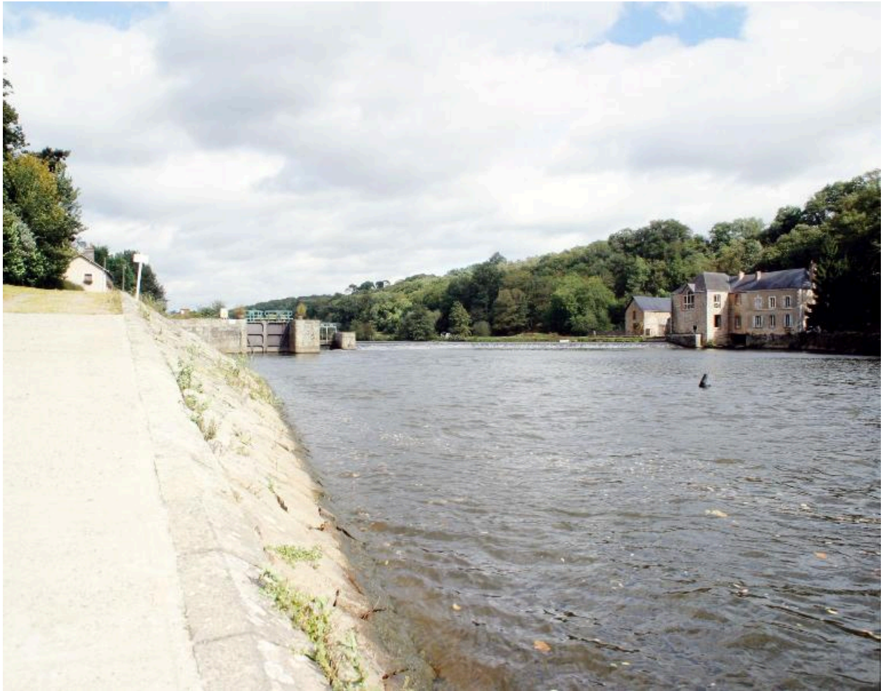
Vue d'ensemble du site depuis la rive droite en aval : maison, éclusière, écluse, pertuis, barrage, moulin.
