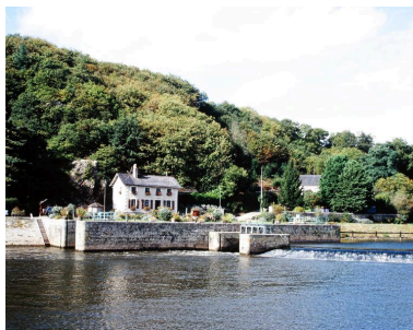
La maison éclusière, l'écluse et le pertuis vus depuis la rive gauche. Phot. François Lasa IVR52_20015300499XA
