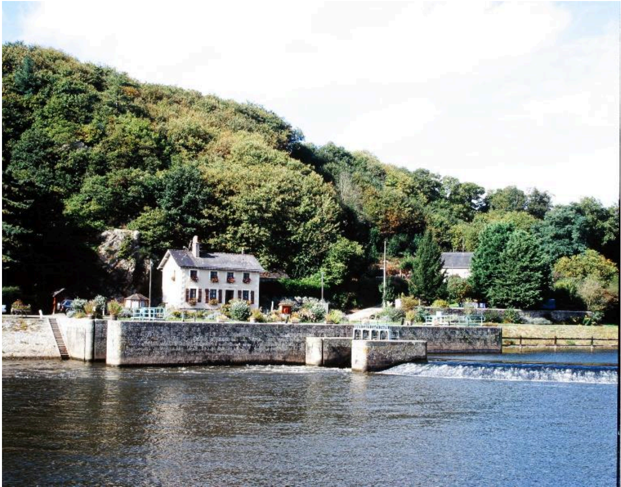
La maison éclusière, l'écluse et le pertuis vus depuis la rive gauche.
