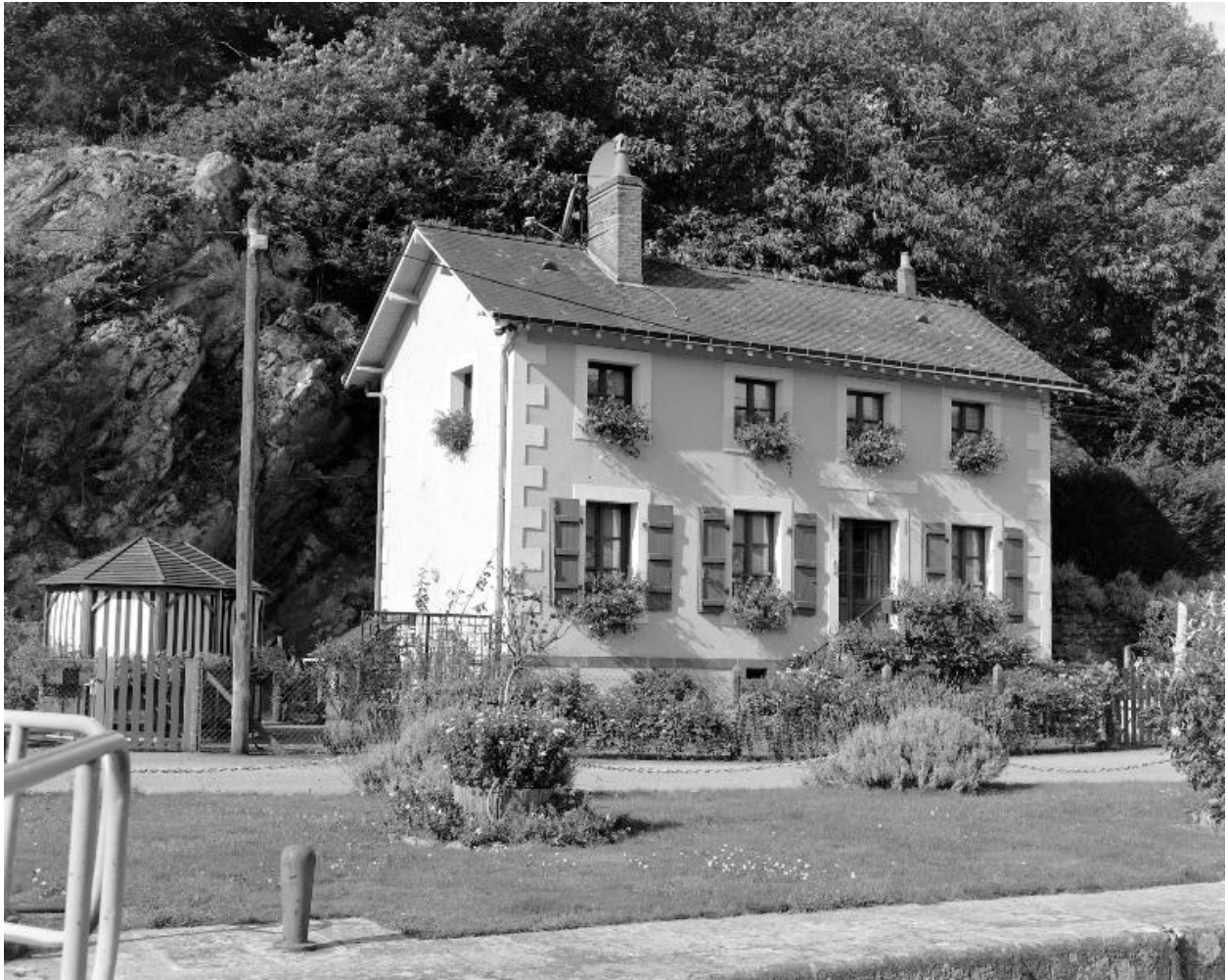
La maison éclusière.
