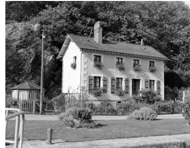
La maison éclusière. Phot. François Lasa IVR52_20015300497X
