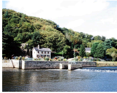
La maison éclusière, l'écluse et le pertuis vus depuis la rive gauche. Phot. François Lasa IVR52_20015300499XA
