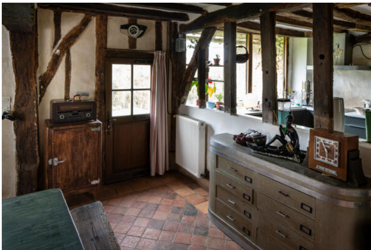
Logis : intérieur avec mur et cloison en pan de bois.
