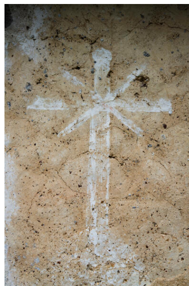
Logis : croix peinte sur le mur est. Phot. Thierry Seldubuisson IVR52_20247200397NUCA
