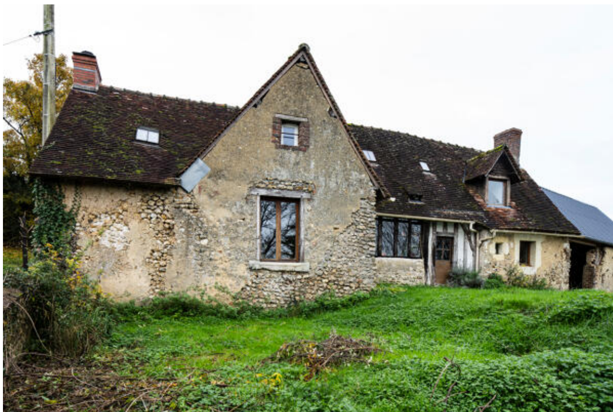
Logis : élévation ouest.
