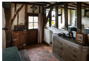
Logis : intérieur avec mur et cloison en pan de bois. Phot. Thierry Seldubuisson IVR52_20247200403NUCA
