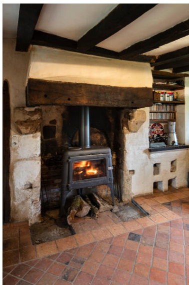
Logis : cheminée sud. Phot. Thierry Seldubuisson IVR52_20247200400NUCA
