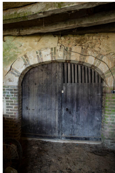
Cellier : porte. Phot. Thierry Seldubuisson IVR52_20247200393NUCA
