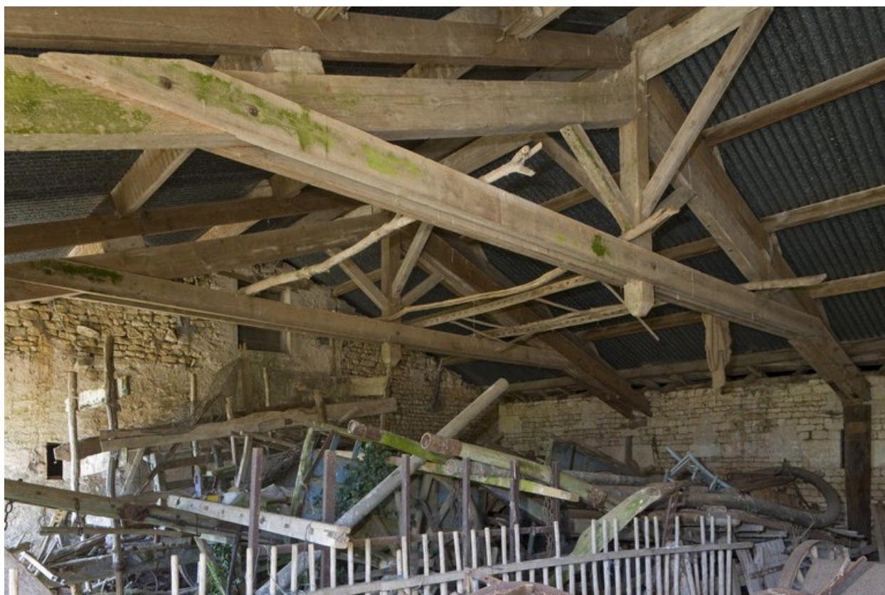
Intérieur du hangar, au sud de l'étable à chevaux.
