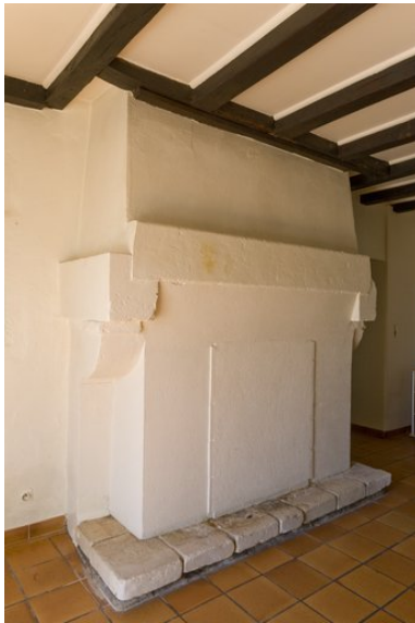
Cheminée de la maison. Phot. Patrice Giraud IVR52_20098500327NUCA
