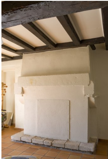
Cheminée de la maison. Phot. Patrice Giraud IVR52_20098500326NUCA
