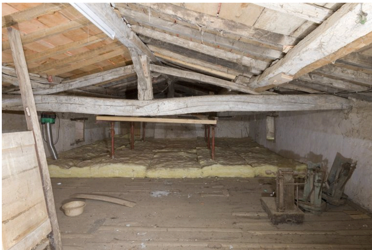
Charpente de la maison.
