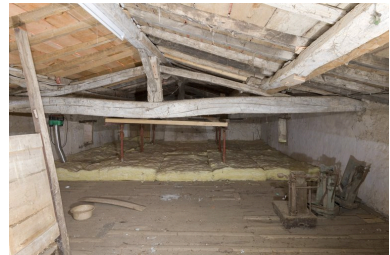
Charpente de la maison. Phot. Patrice Giraud IVR52_20098500333NUCA
