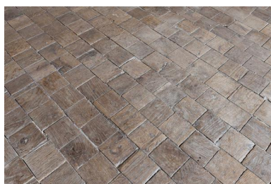
Plancher en carreaux de bois. Chambre du premier étage, corps de logis arrière. Phot. Yves Guillotin IVR52_20215300573NUCA
