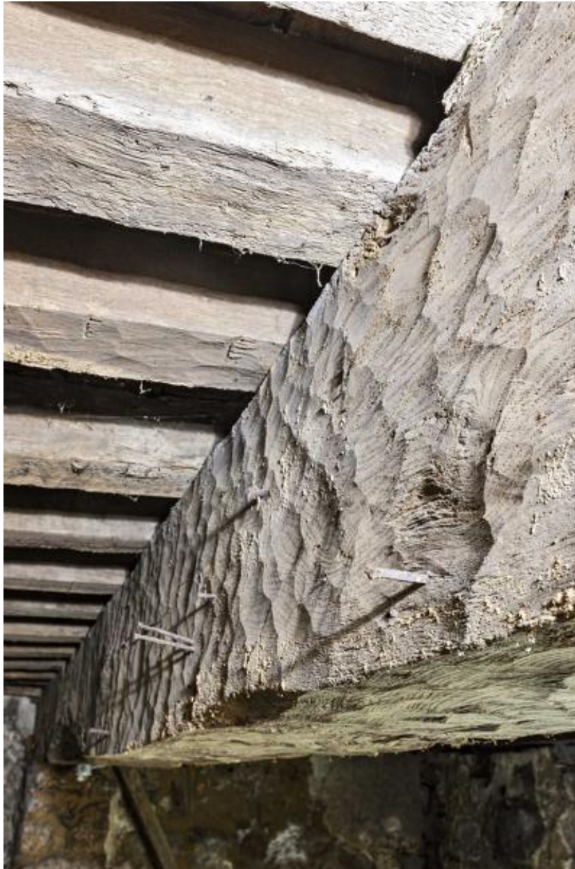
Poutre du plancher de la salle du corps de logis arrière, dans le sous-sol. Traces d'herminette.
