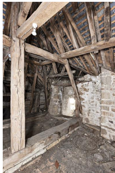
Charpente du corps de logis arrière, ferme sud. Phot. Yves Guillotin IVR52_20215300579NUCA
