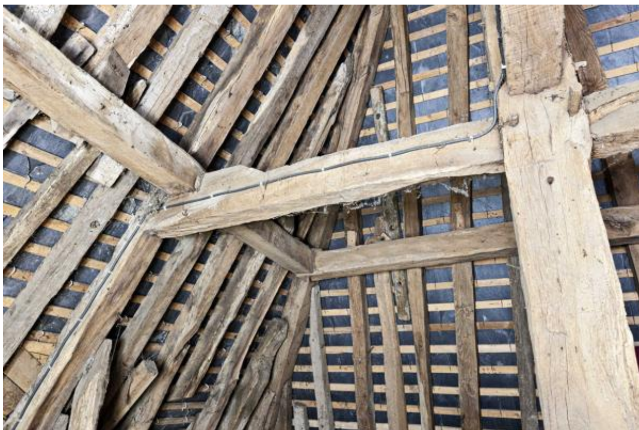
Charpente du corps de logis arrière, détail.
