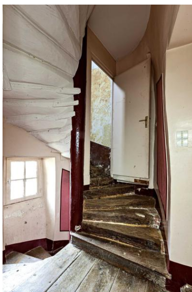
Escalier en vis hors-oeuvre, corps de logis arrière. Phot. Yves Guillotin IVR52_20215300572NUCA
