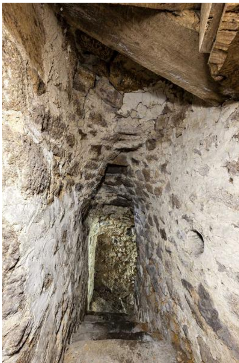
Escalier droit, corps de logis arrière, entre le rez-de-chaussée et la cave.
