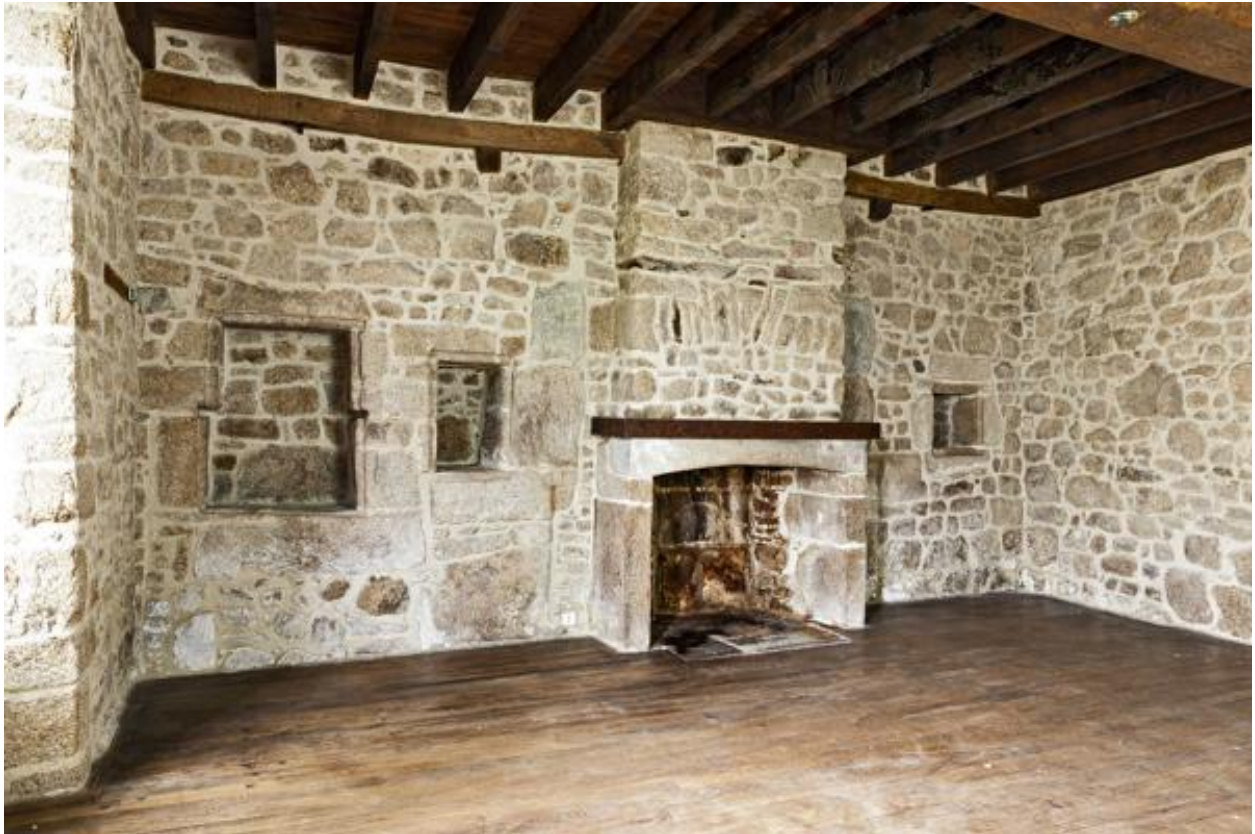
Corps de logis avant, pièce ouest, cheminée du mur-pignon (18e siècle), vestiges de l'ancienne cheminée (corbeaux buchés).
