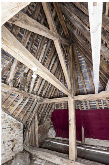
Charpente du corps de logis arrière, ferme nord. Phot. Yves Guillotin IVR52_20215300576NUCA
