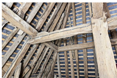
Charpente du corps de logis arrière, détail. Phot. Yves Guillotin IVR52_20215300578NUCA
