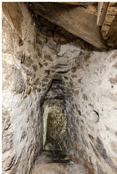
Escalier droit, corps de logis arrière, entre le rez-de-chaussée et la cave. Phot. Yves Guillotin IVR52_20215300568NUCA
