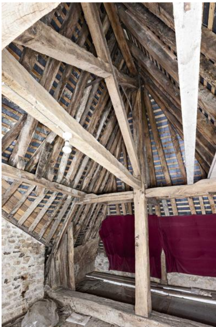
Charpente du corps de logis arrière, ferme nord.
