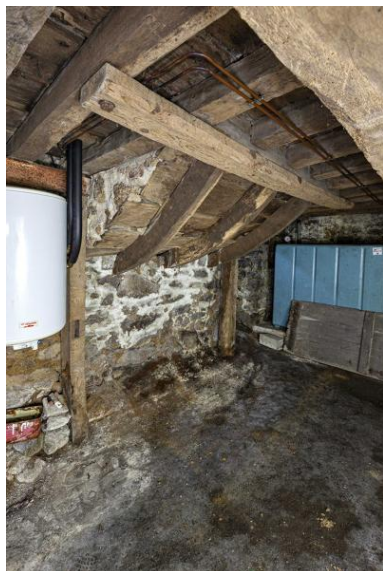
Support de la cheminée de la salle du rez-de-chaussée, corps de logis arrière, sous-sol. Phot. Yves Guillotin IVR52_20215300571NUCA
