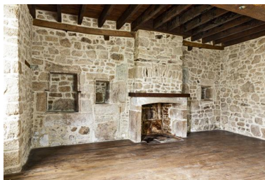
Corps de logis avant, pièce ouest, cheminée du mur-pignon (18e siècle), vestiges de l'ancienne cheminée (corbeaux buchés). Phot. Yves Guillotin IVR52_20215300567NUCA
