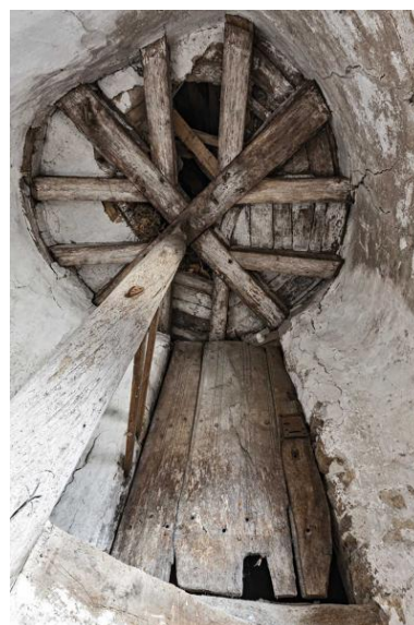
Enrayure basse de la charpente de la tour d'escalier. Phot. Yves Guillotin IVR52_20215300575NUCA
