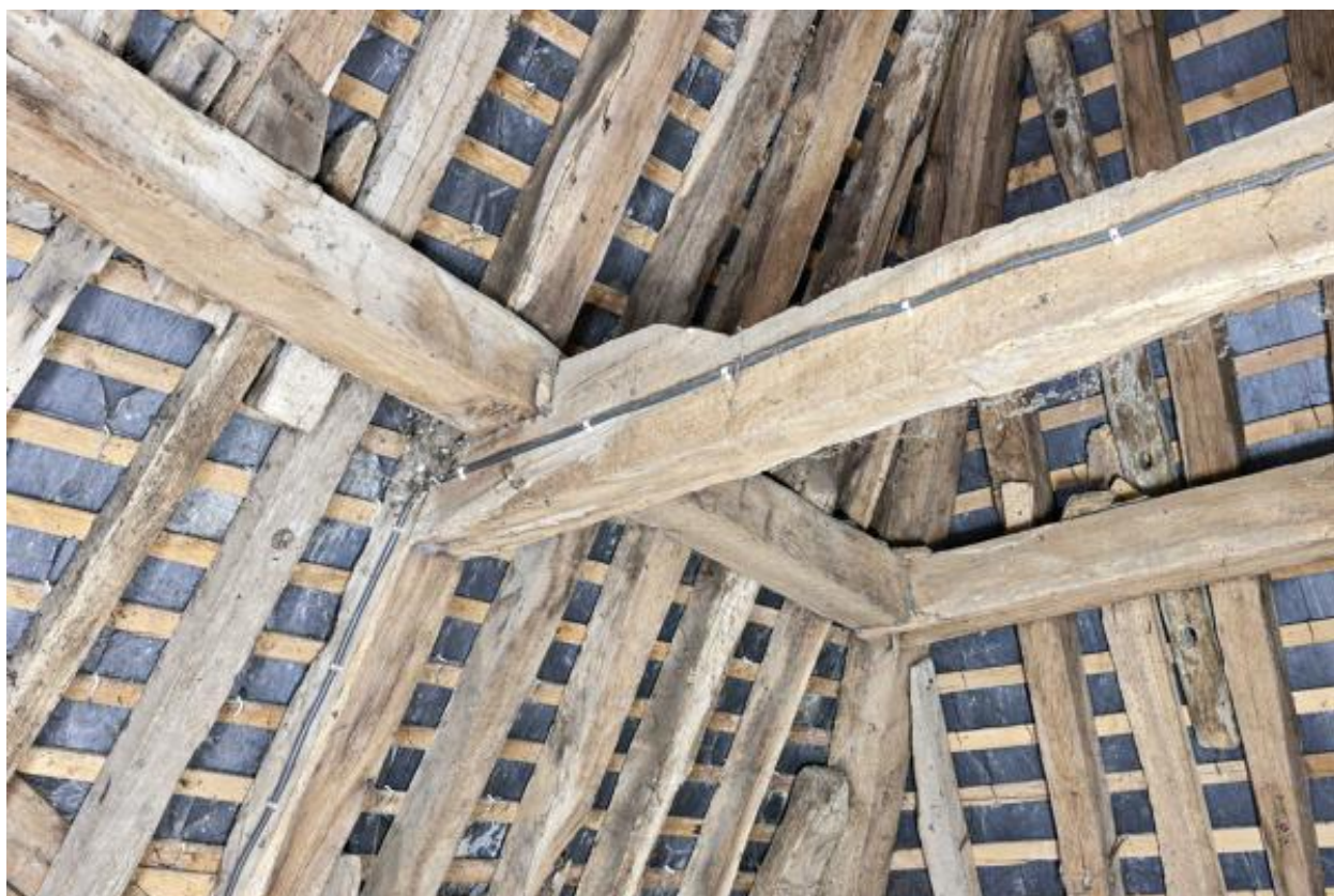
Charpente du corps de logis arrière, détail.
