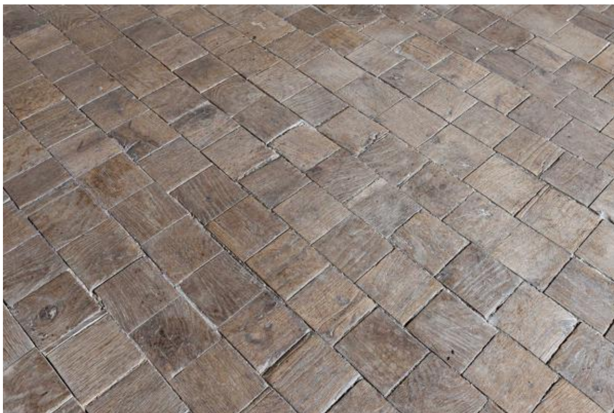
Plancher en carreaux de bois. Chambre du premier étage, corps de logis arrière.
