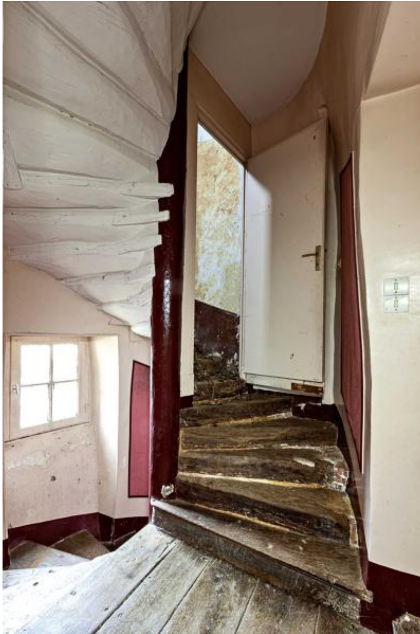
Escalier en vis hors-oeuvre, corps de logis arrière.
