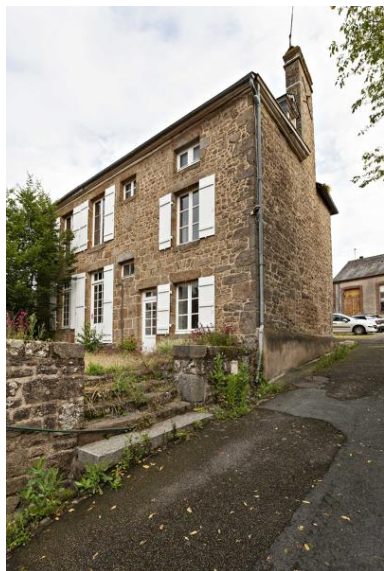
Corps de logis avant, vu depuis le sud-est. Phot. Yves Guillotin IVR52_20195301159NUCA
