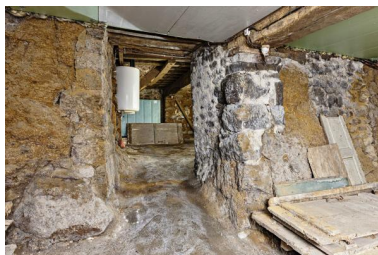
Vue sur la cave du corps de logis arrière depuis celle du corps de logis avant. Phot. Yves Guillotin IVR52_20215300569NUCA
