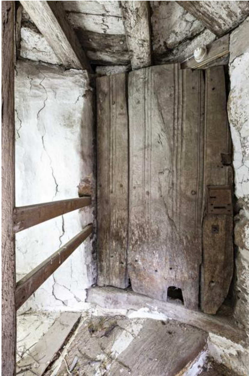
Porte du grenier, corps de logis arrière, vue depuis la tour d'escalier.
