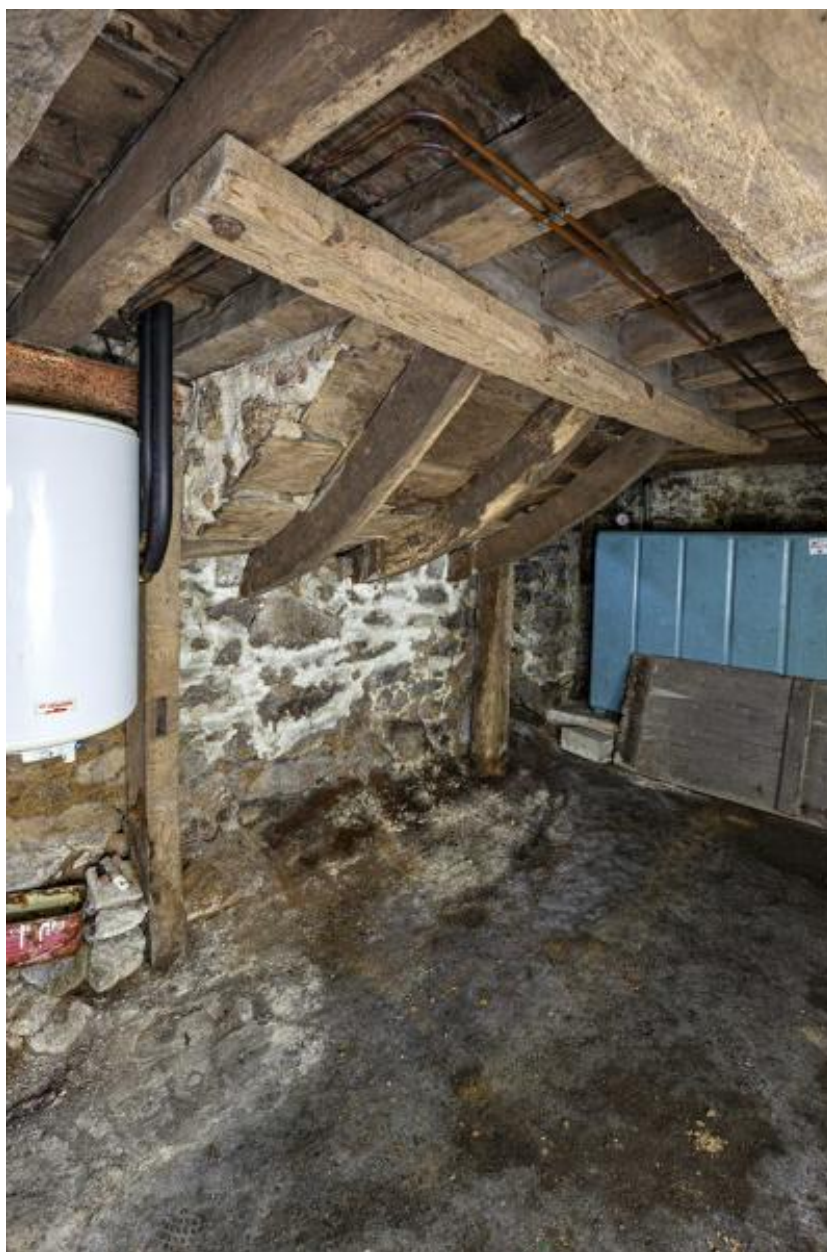
Support de la cheminée de la salle du rez-de-chaussée, corps de logis arrière, sous-sol.
