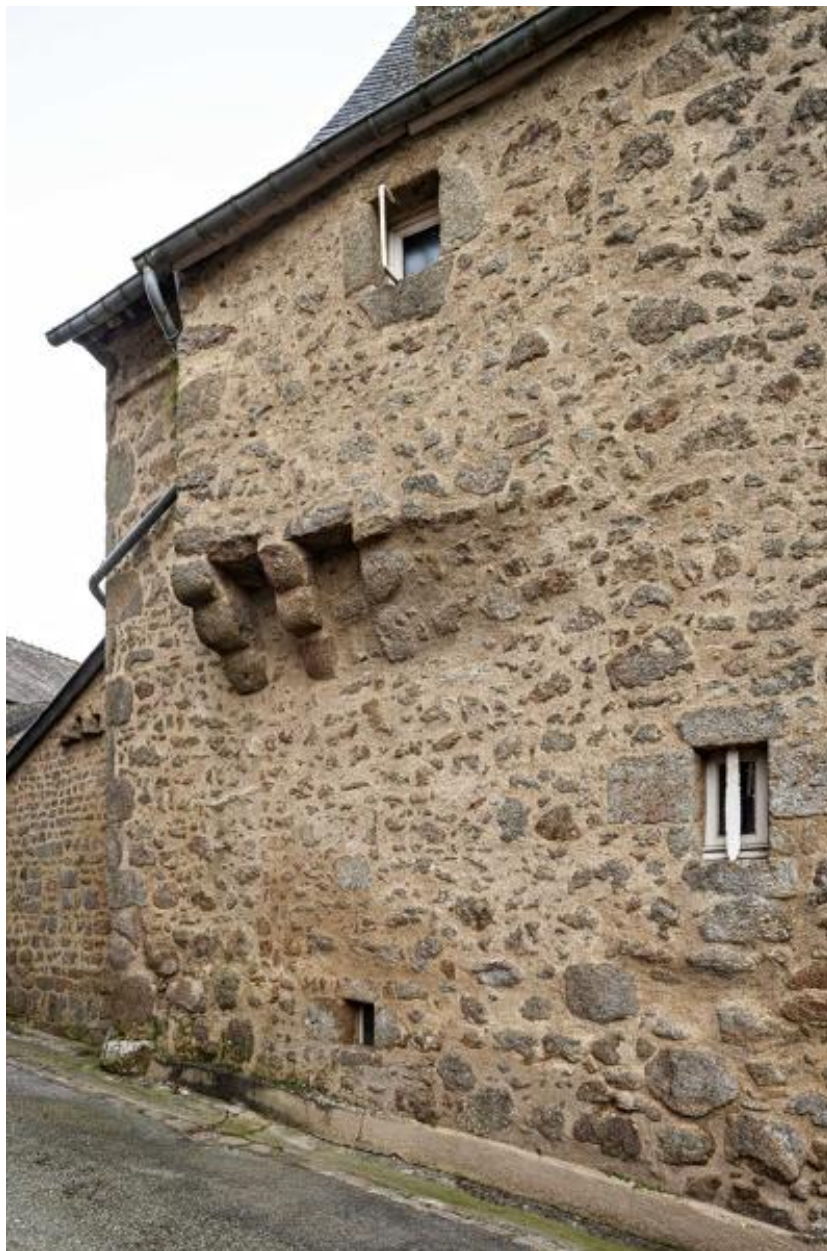
Pièce en encorbellement du corps de logis arrière.
