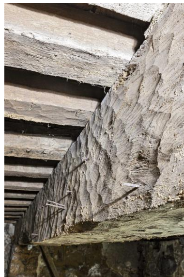
Poutre du plancher de la salle du corps de logis arrière, dans le sous-sol. Traces d'herminette. Phot. Yves Guillotin IVR52_20215300570NUCA
