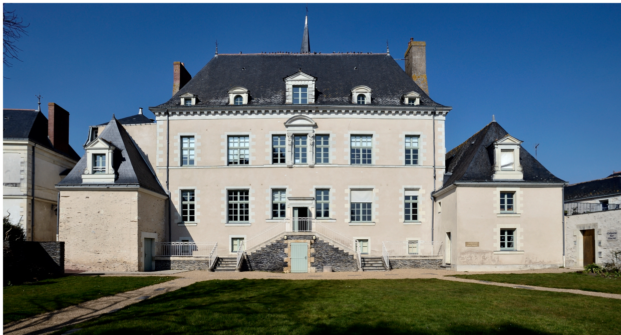
Vue de la façade est.
