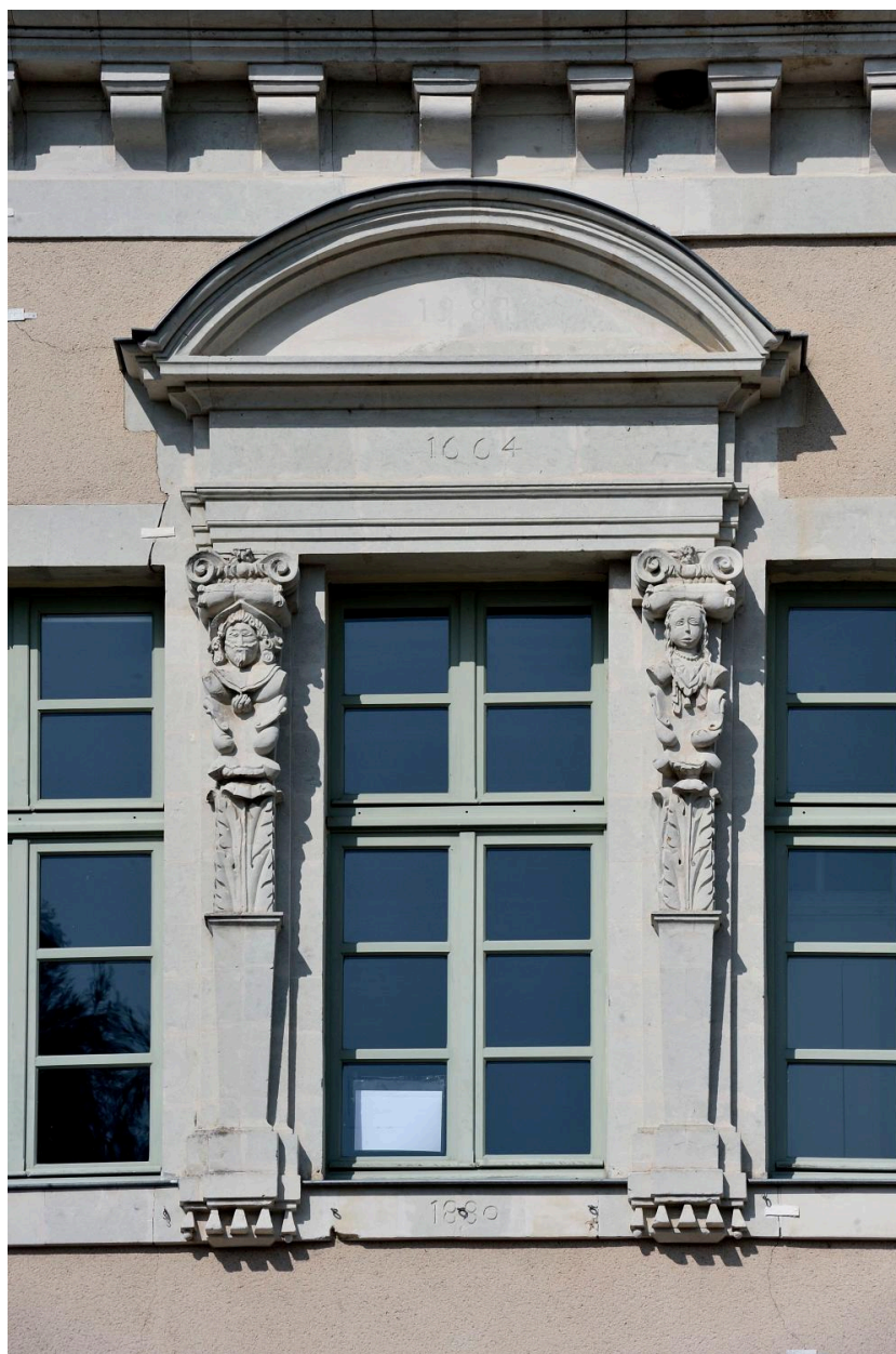
Détail de la fenêtre centrale du 1er étage de la façade est.
