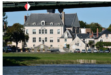
Vue depuis l'est. Phot. Bruno Rousseau IVR52_20154900355NUCA
