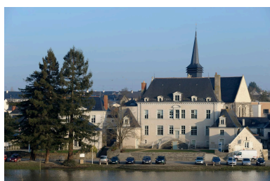
Vue d'ensemble depuis la rive est. Phot. Bruno Rousseau IVR52_20134901314NUCA
