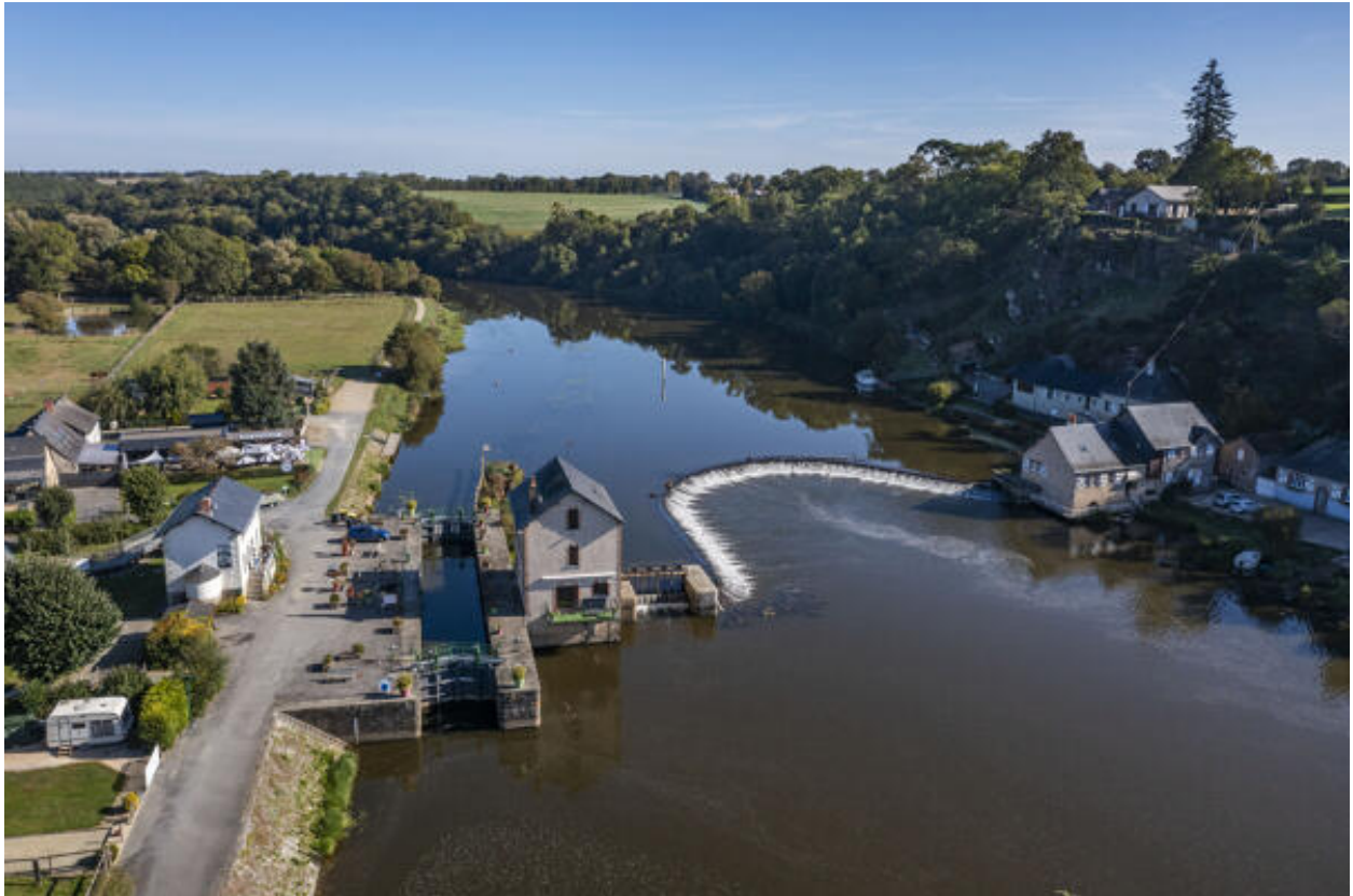
Le barrage et l'écluse de Neuville.
