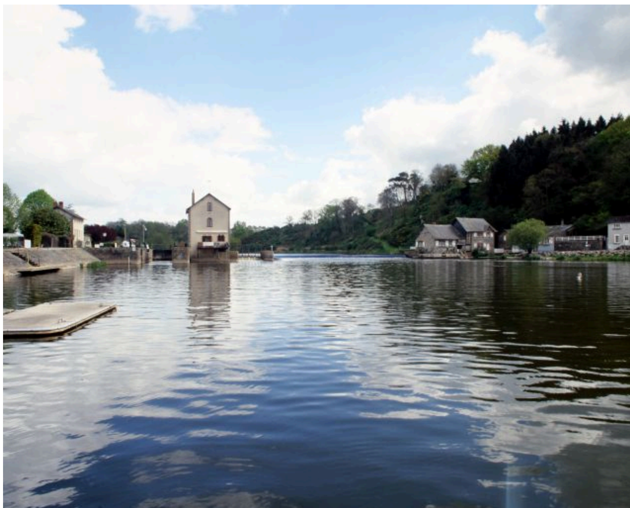
Vue d'ensemble du site depuis la rive droite en aval : maison éclusière, écluse, ancien moulin à farine de la rive droite, pertuis, barrage, anciens moulins à farine et à tan de la rive gauche.
