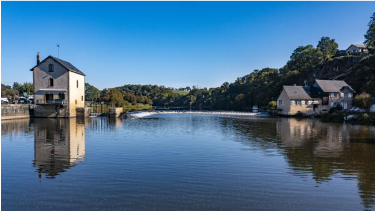
L'écluse, le barrage et les moulins.
