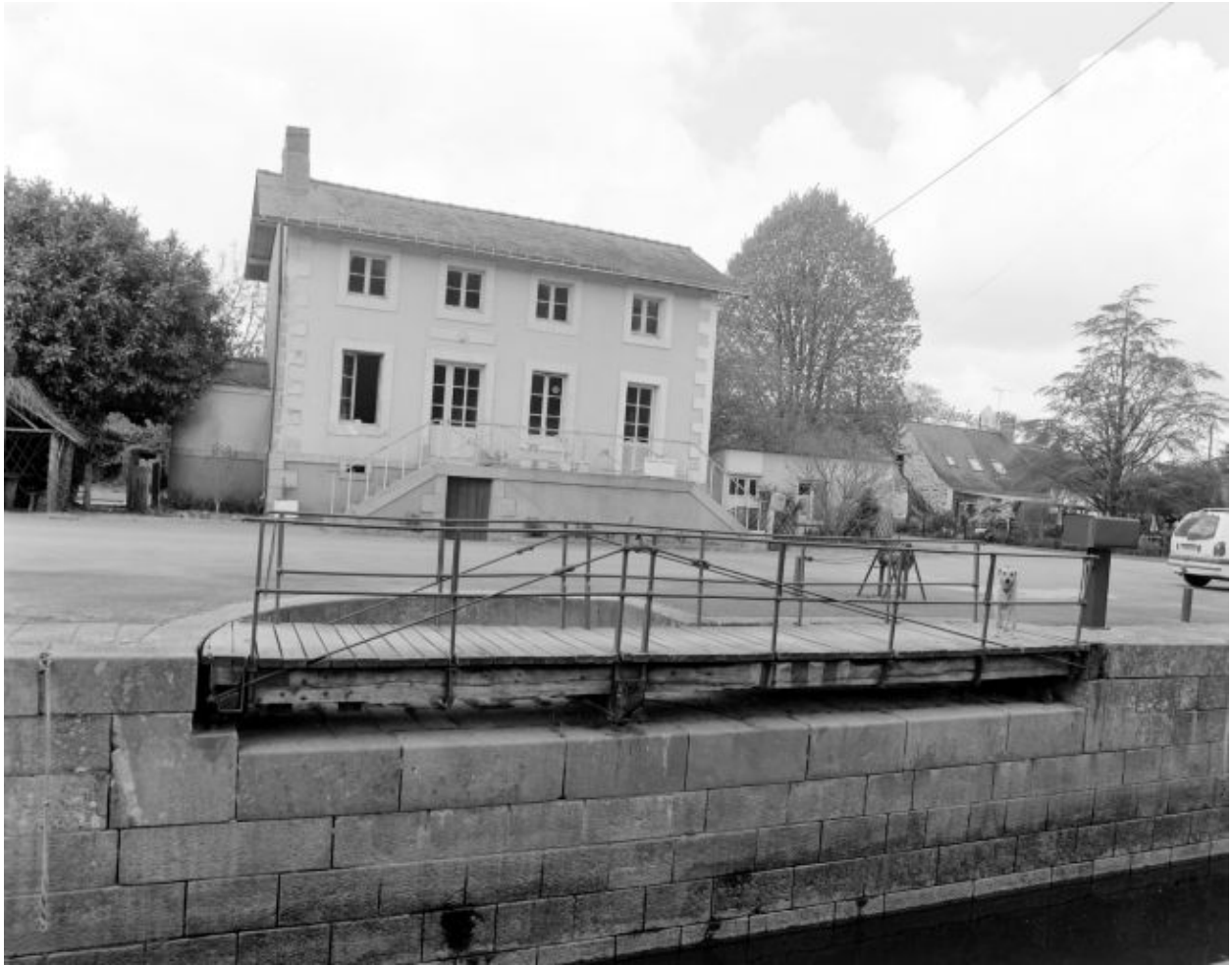
La maison éclusière. Au premier plan, le pont tournant.
