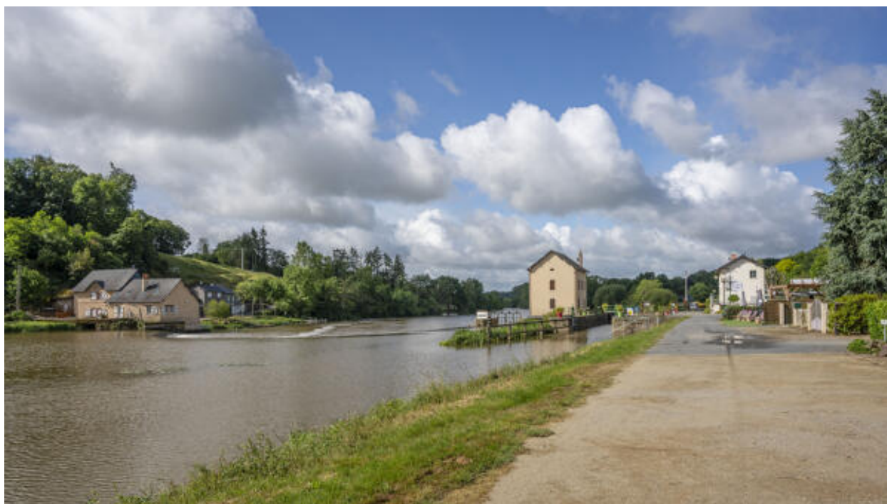
L'écluse et le barrage de Neuville.
