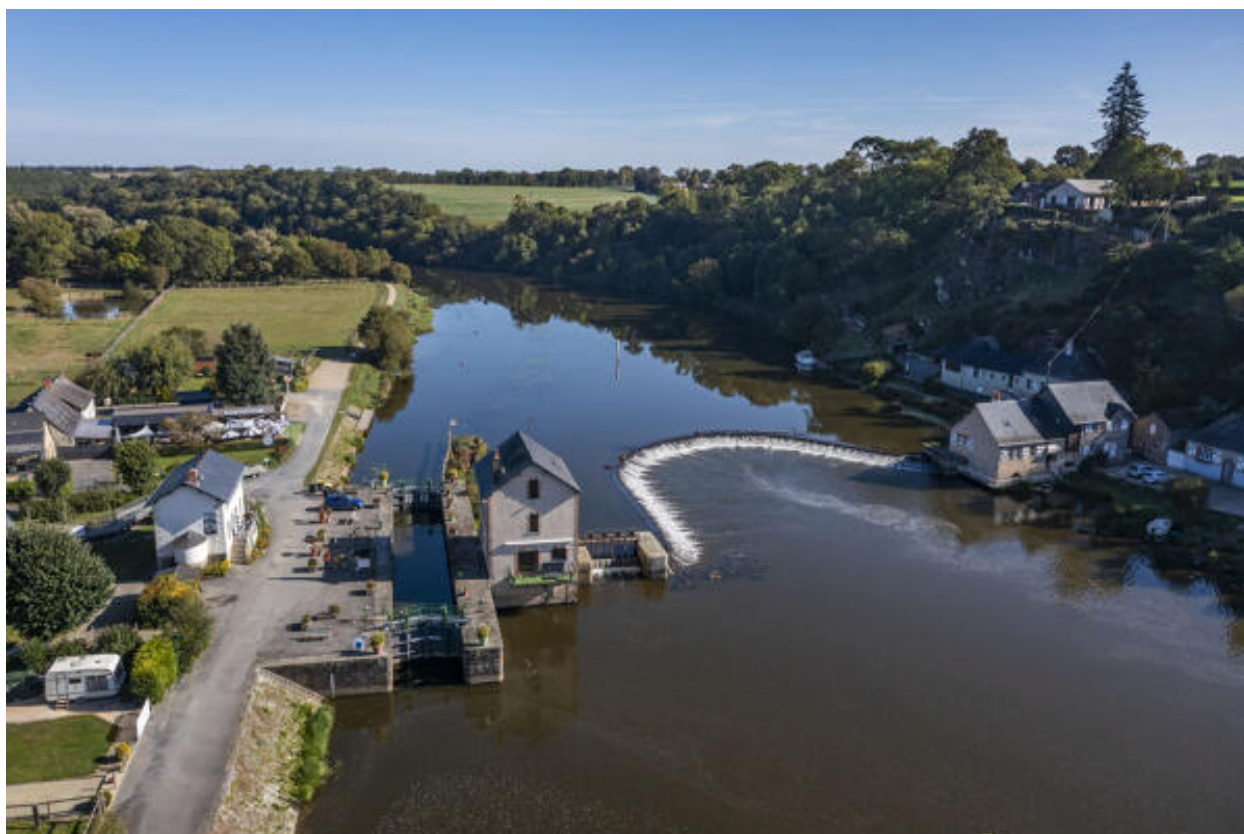
Le barrage et l'écluse de Neuville.
