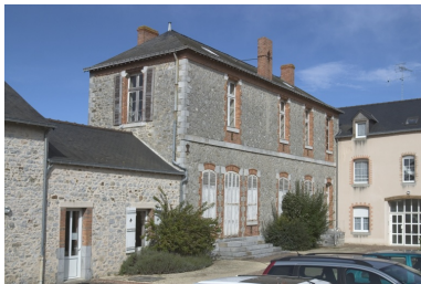
L'aile ouest sur la cour. Phot. François Lasa IVR52_20045303126NUCA
