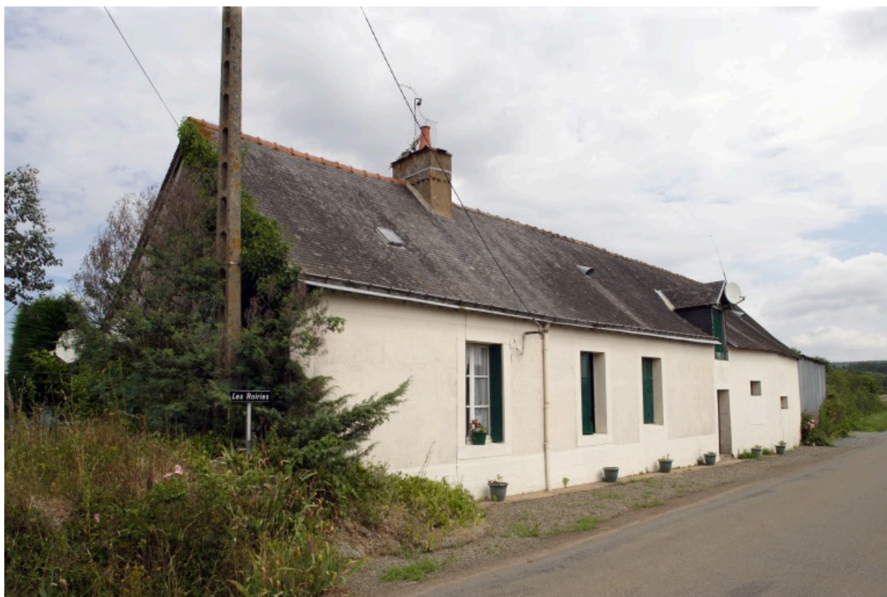
Vue d'ensemble depuis la route au sud.
