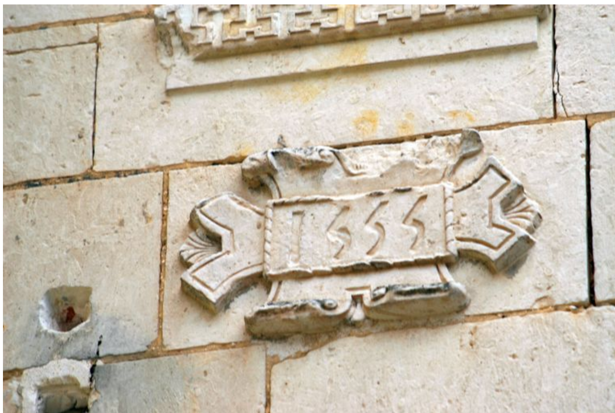
Tourelle d'escalier, détail : cartouche sculpté.
