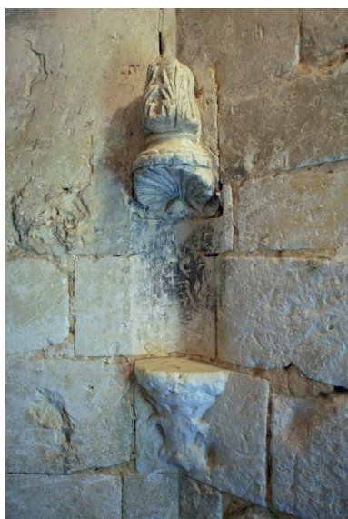
Tourelle d'escalier : niche pour une lampe. Phot. Jean-Baptiste Darrasse IVR52_20087201589NUCA
