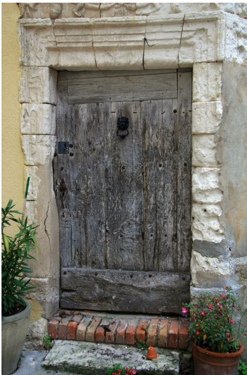
Tourelle d'escalier : menuiserie de la porte d'entrée.
