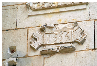
Tourelle d'escalier, détail : cartouche sculpté. Phot. Jean-Baptiste Darrasse IVR52_20087201600NUCA
