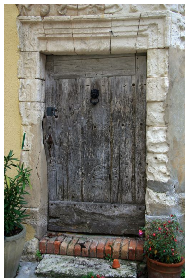
Tourelle d'escalier : menuiserie de la porte d'entrée. Phot. Jean-Baptiste Darrasse IVR52_20087201595NUCA
