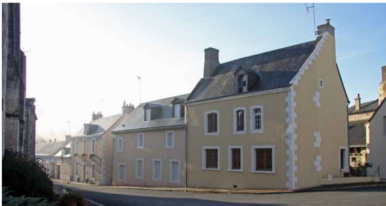
Vue d'ensemble de la façade sur rue.
