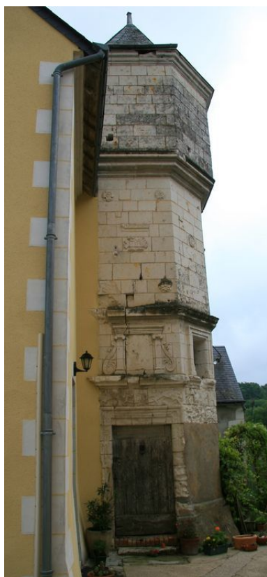
Tourelle d'escalier sur la cour. Phot. Jean-Baptiste Darrasse IVR52_20087201596NUCA
