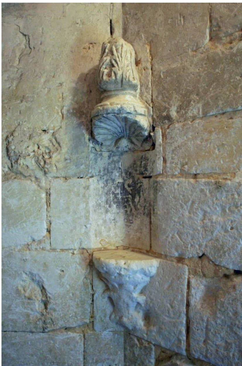
Tourelle d'escalier : niche pour une lampe.
