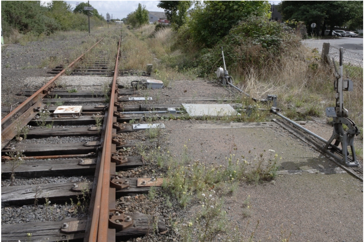
Vue d'ensemble : leviers de manœuvre, aiguilles.
