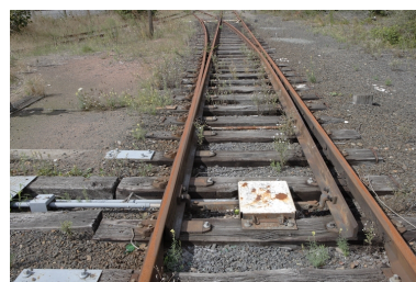
Tringle de manœuvre et tringle d'écartement. Phot. Denis Pillet IVR52_20104402072NUCA
