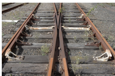
Coeur de croisement avec entretoises. Phot. Denis Pillet IVR52_20104402073NUCA
