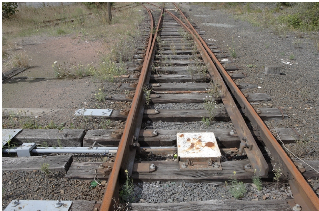
Tringle de manoeuvre et tringle d'écartement.
