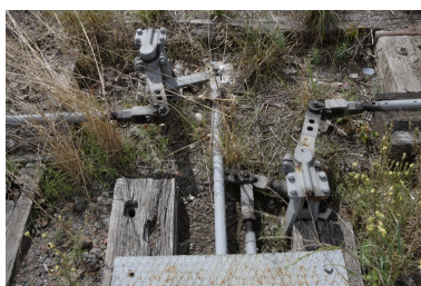
Mécanisme du levier de manœuvre. Phot. Denis Pillet IVR52_20104402069NUCA
