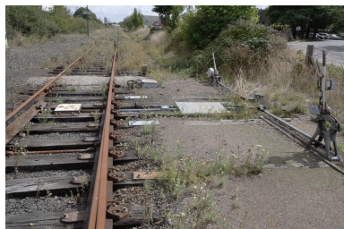
Vue d'ensemble : leviers de manœuvre, aiguilles. Phot. Denis Pillet IVR52_20104402066NUCA
