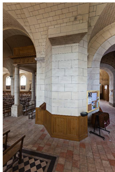
Pilier postérieur gauche de la tour-clocher, renforcé vers 1878. Phot. Yves Guillotin IVR52_20147202090NUCA
