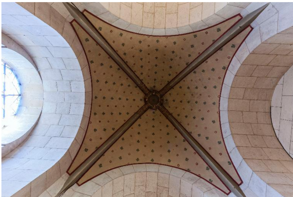
Voûte d'ogives médiévale (?) couvrant le rez-de-chaussée de la tour-clocher.
