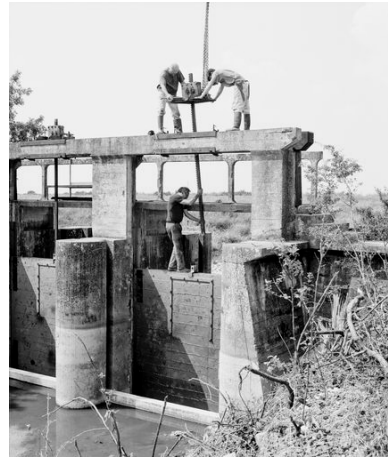
Remise en place de la crémaillère d'une porte-vanne, en 1999. Phot. Christophe Yvernogeu IVR52_19998500824X
