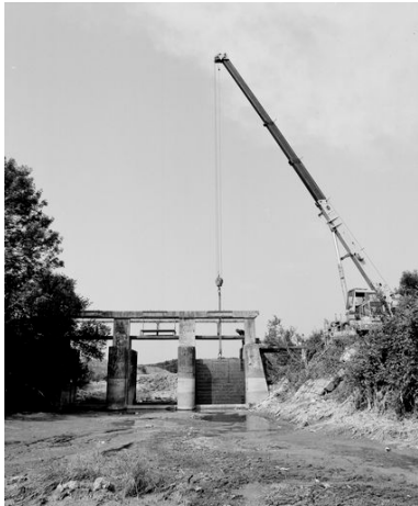
Remise en place d'une porte-vanne, en 1999. Phot. Christophe Yvernogeu IVR52_19998500821X
