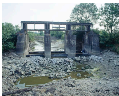
Vue, prise en 1999, de l'ouvrage moderne sans ses vannes et des fondations de l'ancien barrage à poutrelles. Phot. Christophe Yvernoiseau IVR52_19998500784XA
