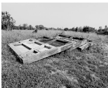
Vue des portes-vannes déposées, en 1999. Phot. Christophe Yvernoiseau IVR52_19998500820X
