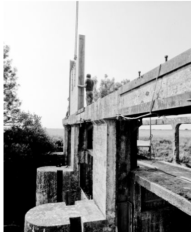
Remise en place d'une porte-vanne, en 1999. Phot. Christophe Yvernogeu IVR52_19998500823X
