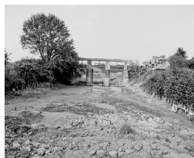
Remise en place d'une porte-vanne, en 1999. Phot. Christophe Yvernoiseau IVR52_19998500818X
