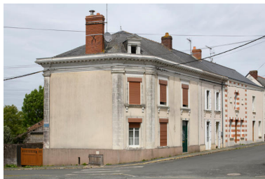
Ancien hôtel de voyageurs et café du Lion d'Or, actuellement maison, 26 rue de la Mairie à Beausse. Phot. Xaël Despré, Phot. Armelle Maugin IVR52_20214900322NUCA
