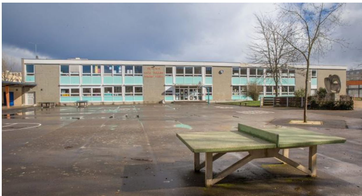
Vue de la façade principale de l'école Gérard-Philippe.
