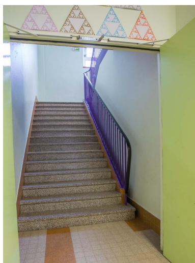
Vue du départ d'escalier en rez-de-chaussée de l'école Gérard-Philipe. Phot. Pierre-Bernard Fourny IVR52_20197200380NUCA
