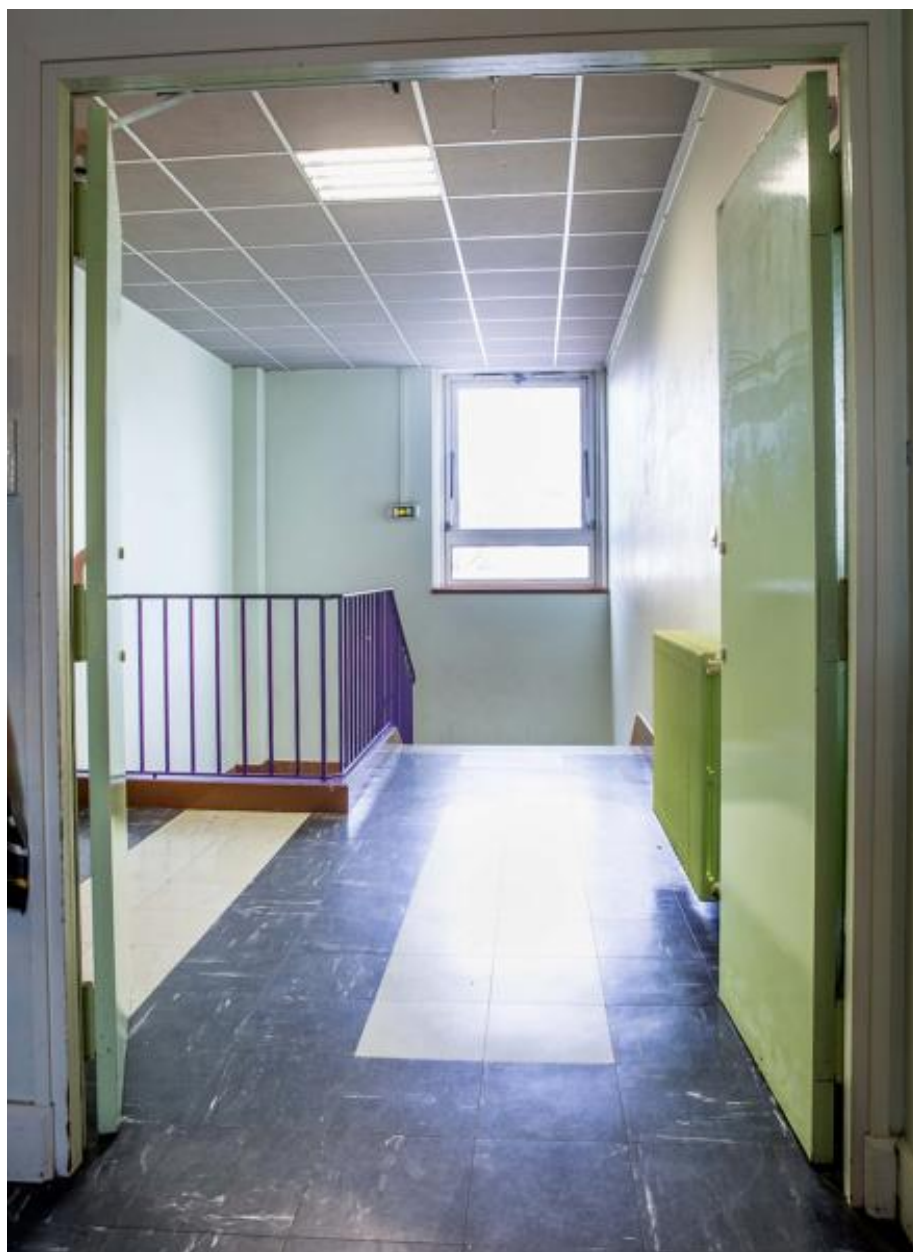
Vue du palier nord de l'école Gérard Philippe depuis l'étage.
