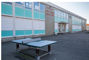
Vue de la façade principale de l'école Gérard-Philipe depuis le préau. Phot. Pierre-Bernard Fourny IVR52_20197200309NUCA
