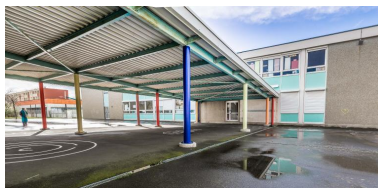
Vue du préau arrière de l'école Gérard-Philippe. Phot. Pierre-Bernard Fourny IVR52_20197200387NUCA
