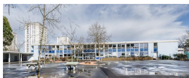
Vue de la façade principale de l'école Gaston-Bachelard. Phot. Pierre-Bernard Fourny IVR52_20197200391NUCA
