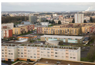
Vue de l'école Gérard-Philipe depuis le toit d'une tour des Sablons. Phot. Pierre-Bernard Fourny IVR52_20197200044NUCA
