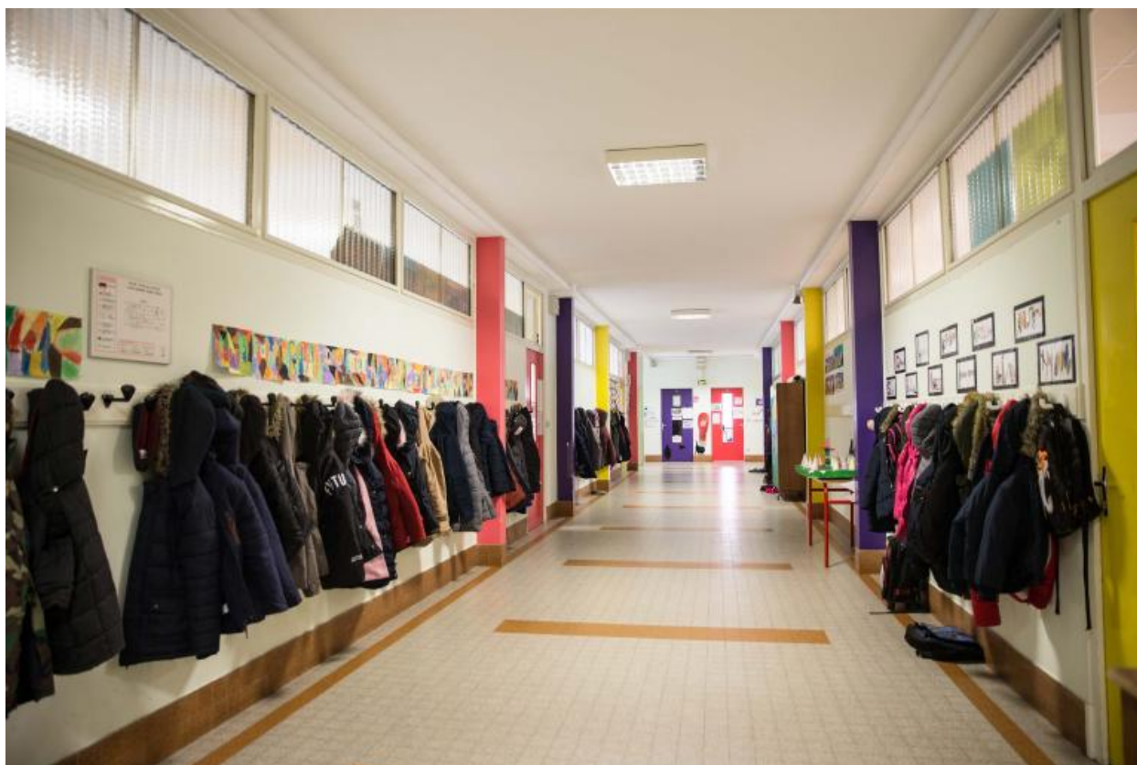
Vue d'un couloir central du rez-de-chaussée de l'école Gérard Philipe.
