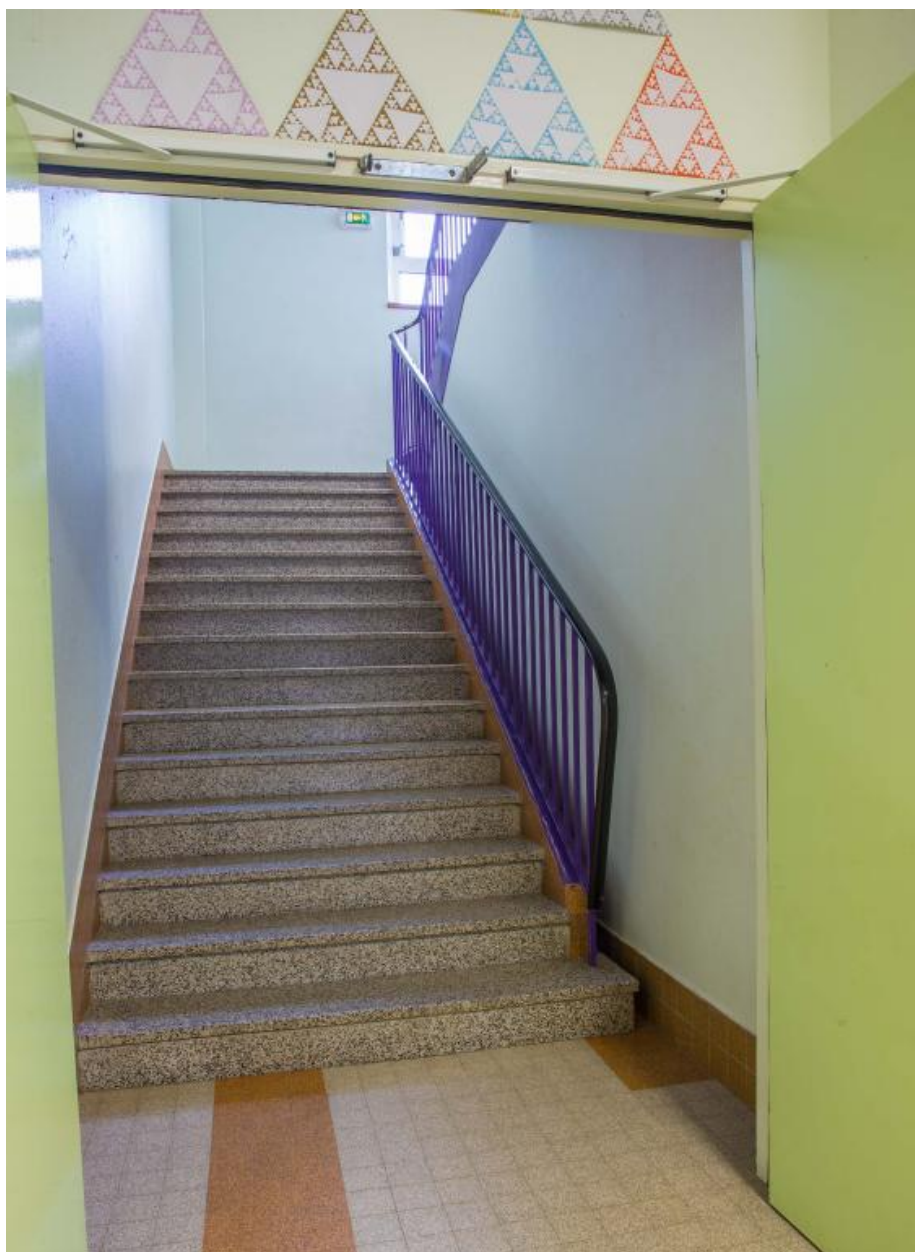
Vue du départ d'escalier en rez-de-chaussée de l'école Gérard Philipe.
