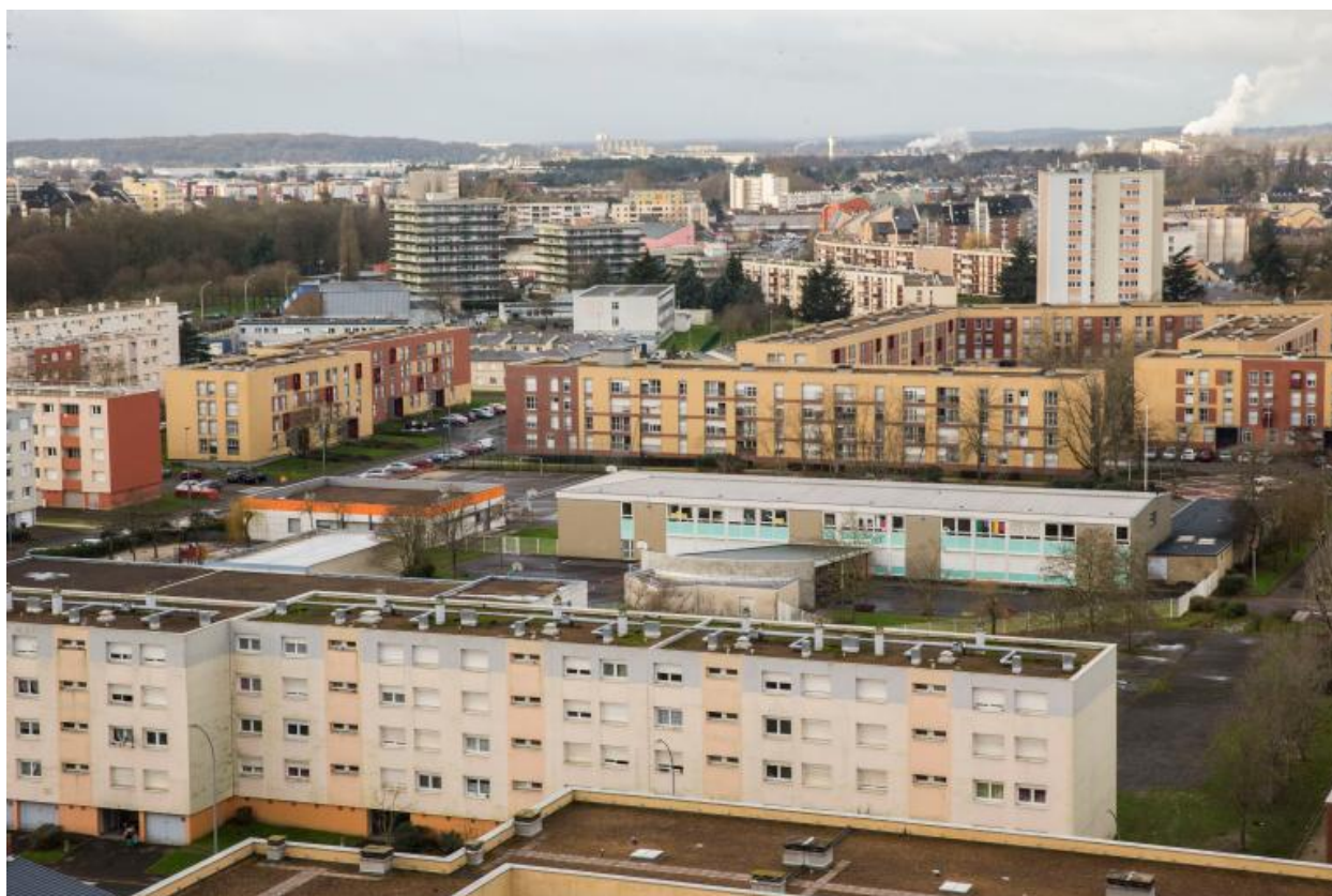
Vue de l'école Gérard-Philipe depuis le toit d'une tour des Sablons.
