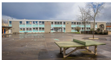
Vue de la façade principale de l'école Gérard-Philipe. Phot. Pierre-Bernard Fourny IVR52_20197200389NUCA
