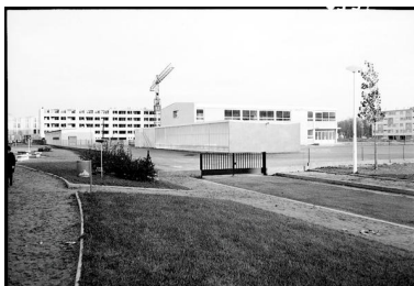
Vue de l'école Gaston Bachelard depuis l'ouest avec les immeubles en construction en arrière plan. IVR52_20197200414NUCA
