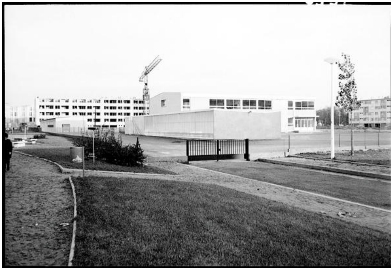
Vue de l'école Gaston Bachelard depuis l'ouest avec les immeubles en construction en arrière plan.
