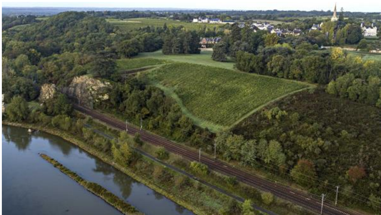
Vue aérienne du château de la Petite-Rivière.
