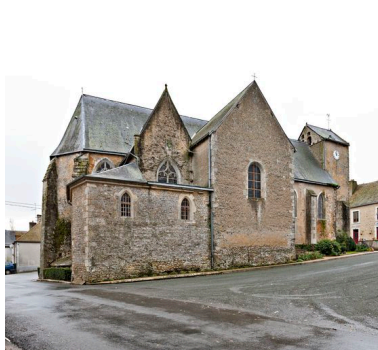
Vue d'ensemble de l'église depuis le nord-est. Phot. Yves Guillotin IVR52_20137200343NUCA
