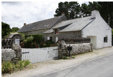
Vue d'ensemble depuis le nord-ouest. Phot. Denis Pillet IVR52_20084402045NUCA
