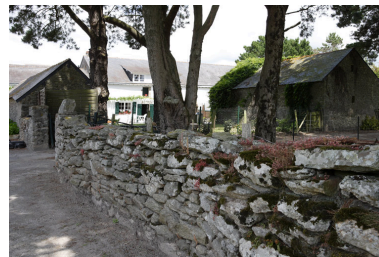
Vue d'ensemble depuis le sud-ouest. Phot. Denis Pillet IVR52_20084402046NUCA
