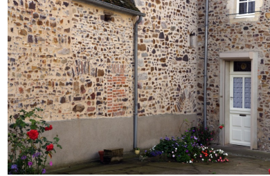
Vue de détail depuis la cour du 9, place Adam-Becker au nord : à droite, porte bouchée. Phot. François Lasa IVR52_20055302039NUCA
