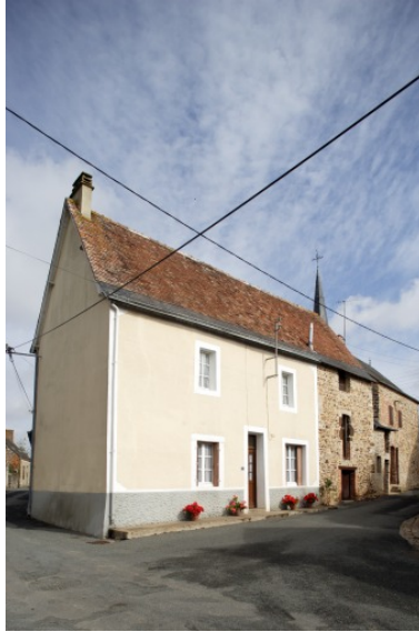
Vue depuis la rue du bourrelier. L'ancien logis est à droite. Phot. François Lasa IVR52_20055302053NUCA
