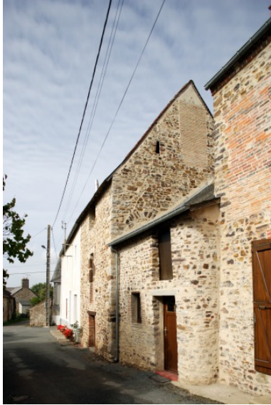
Vue depuis la rue du plan d'eau à l'est. L'ancien logis, dont se détache le pignon, est au second plan. Phot. François Lasa IVR52_20055302054NUCA
