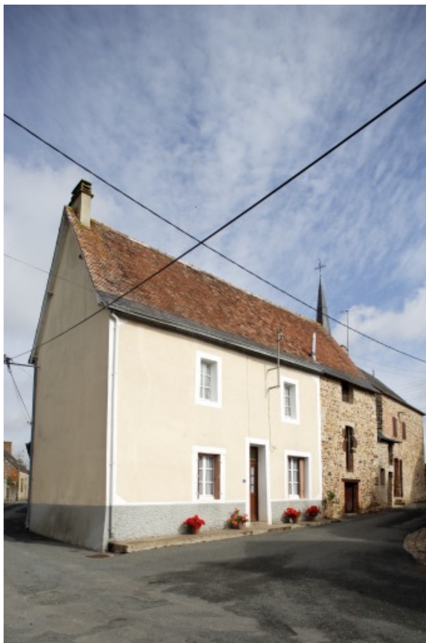
Vue depuis la rue du bourrelier. L'ancien logis est à droite.
