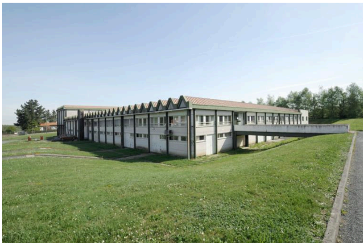
Vue générale de l'usine FPM, anciennement SACAIR.
