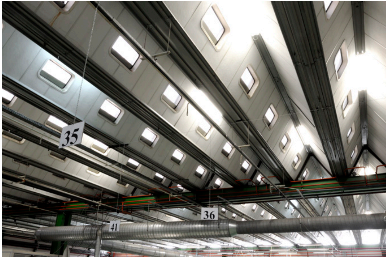
Usine SACAIR : détail des sheds.
