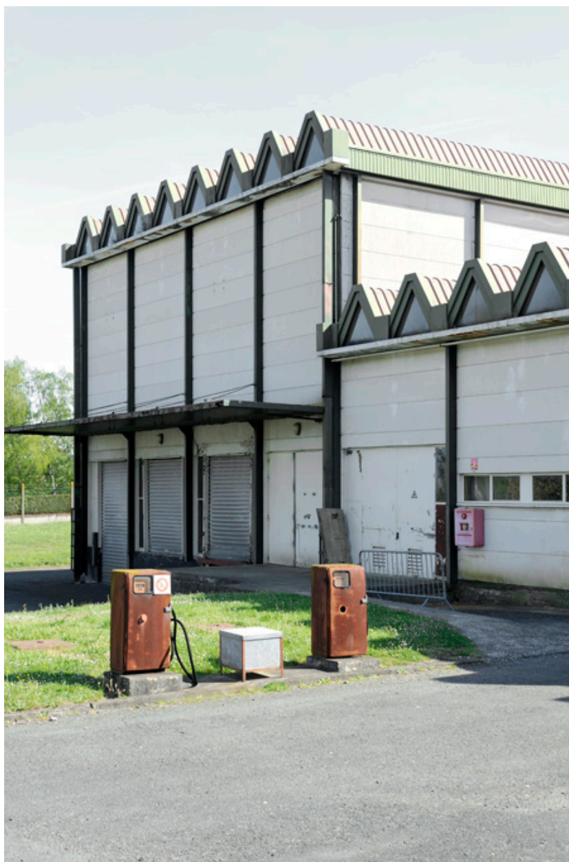
Usine SACAIR : façade ouest.
