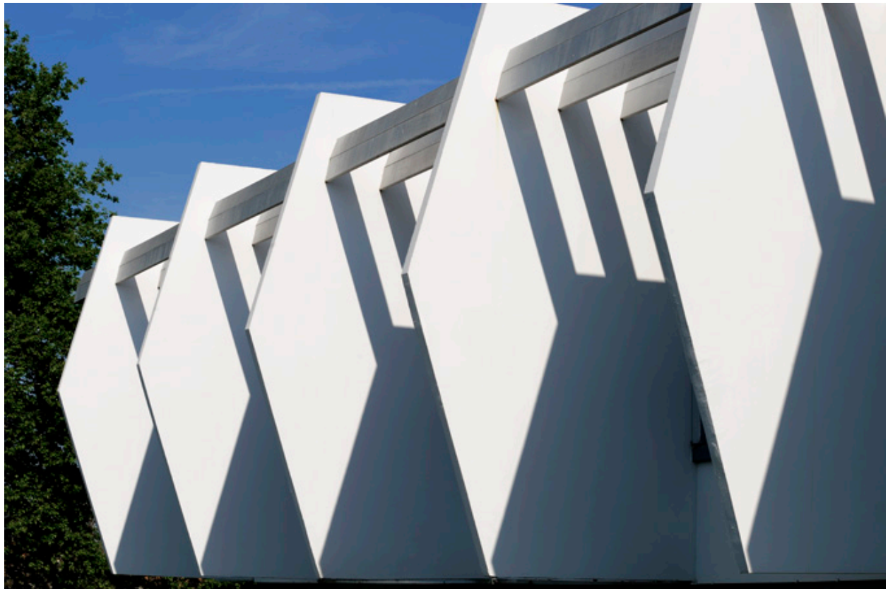
Siège du Groupe SAC : détail de la façade.
