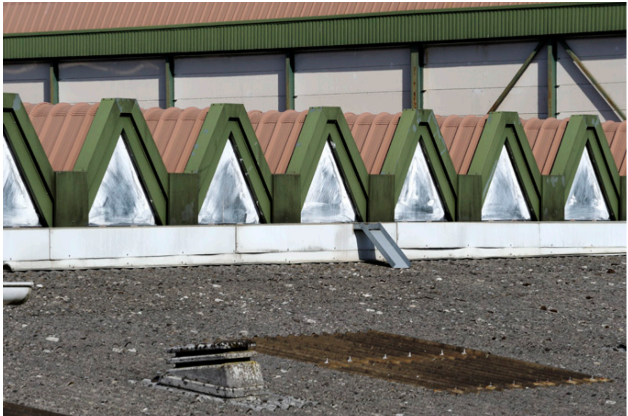
Détail de la toiture de sheds.
