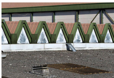
Détail de la toiture de sheds. Phot. Bruno Rousseau, Phot. Youenn Communeau IVR52_20114901108NUCA
