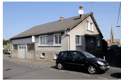
Conciergerie pour le site rue Jeanne d'Arc. Phot. Bruno Rousseau, Phot. Youenn Communeau IVR52_20114901321NUCA
