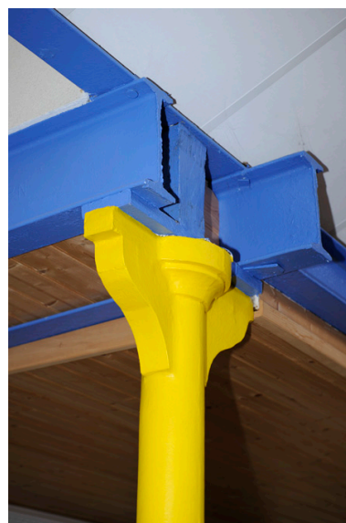
Usine 11 rue Jeanne d'Arc : détail d'un pilier en fonte. Phot. Bruno Rousseau, Phot. Youenn Communeau IVR52_20114901498NUCA
