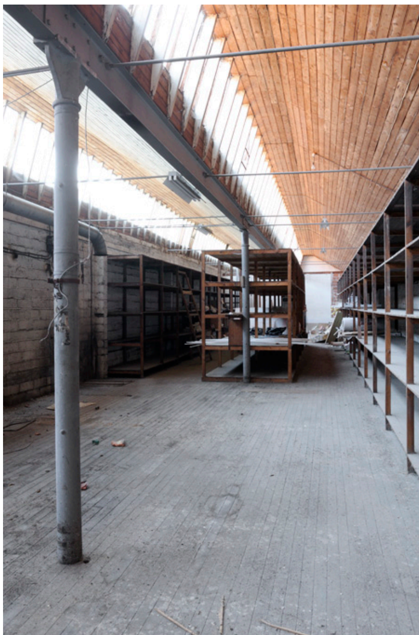
Usine 11 rue Jeanne d'Arc : vue d'une salle à l'étage.
