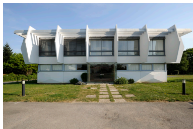
Vue générale du siège du Groupe SAC. Phot. Bruno Rousseau, Phot. Youenn Communeau IVR52_20114900295NUCA
