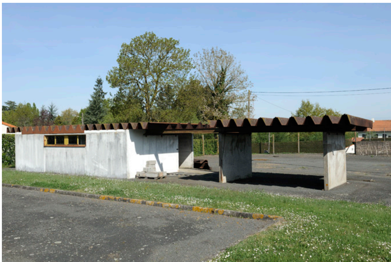
Usine SACAIR : garage à vélo.
