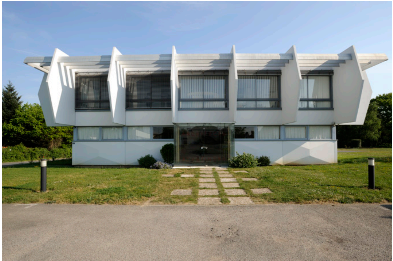
Vue générale du siège du Groupe SAC.
