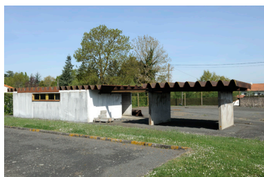
Usine SACAIR : garage à vélo. Phot. Bruno Rousseau, Phot. Youenn Communeau IVR52_20114901115NUCA
