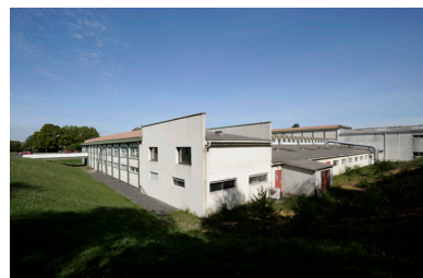
Usine SACAIR : façades sud et est. Phot. Bruno Rousseau, Phot. Youenn Communeau IVR52_20114901105NUCA
