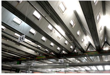
Usine SACAIR : détail des sheds.
