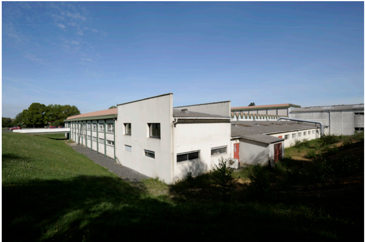
Usine SACAIR : façades sud et est.
