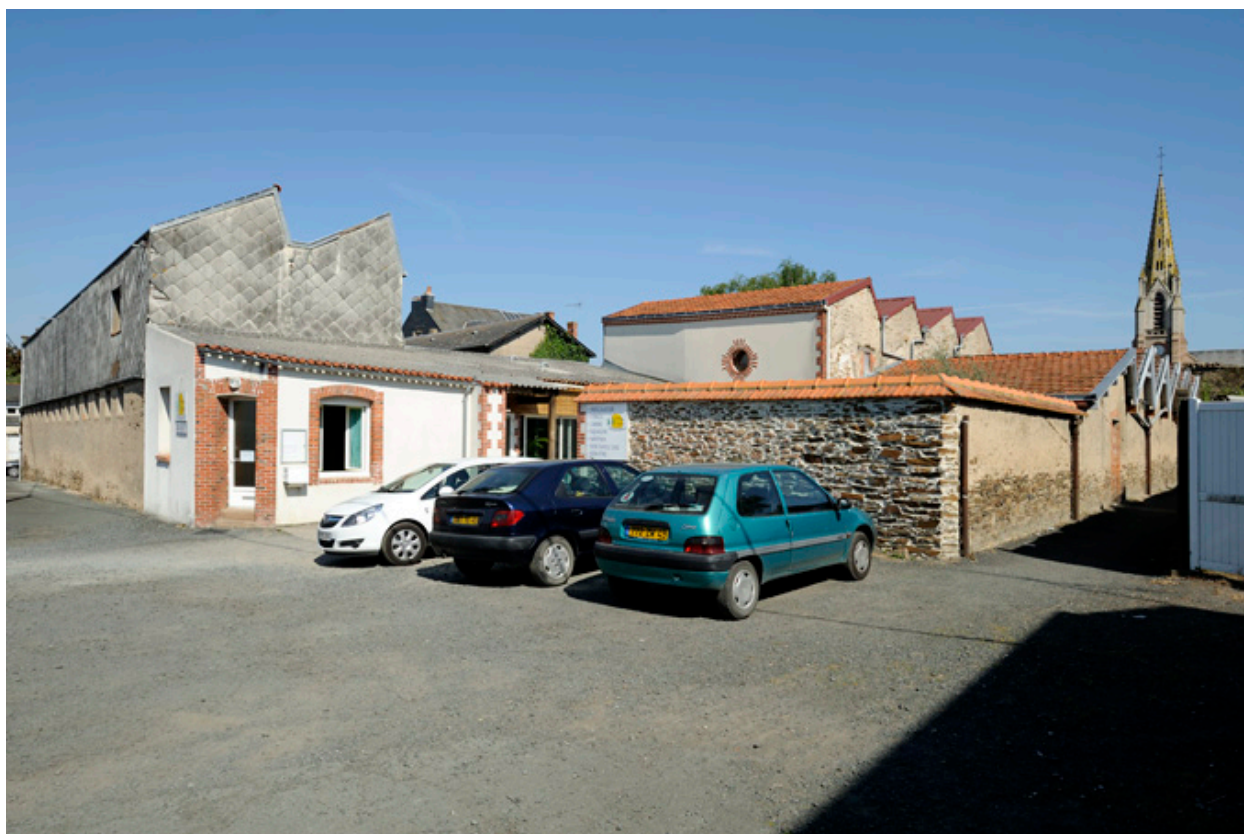
Vue de l'usine située au 11 rue Jeanne d'Arc.
