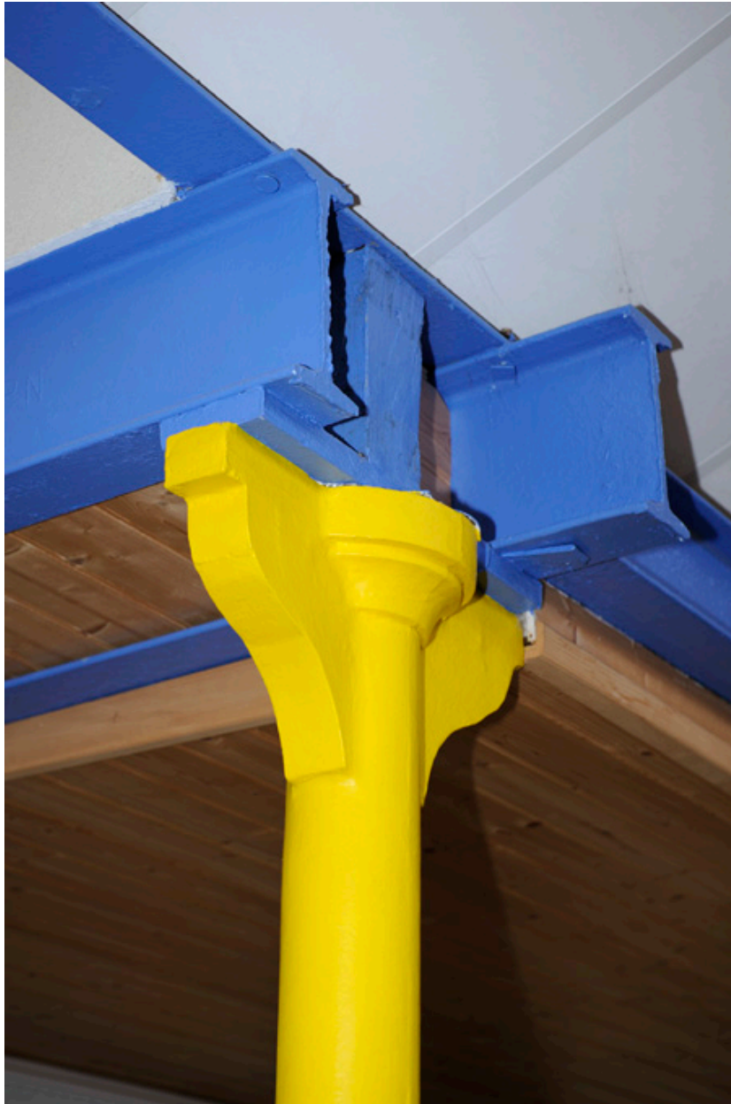
Usine 11 rue Jeanne d'Arc : détail d'un pilier en fonte.
