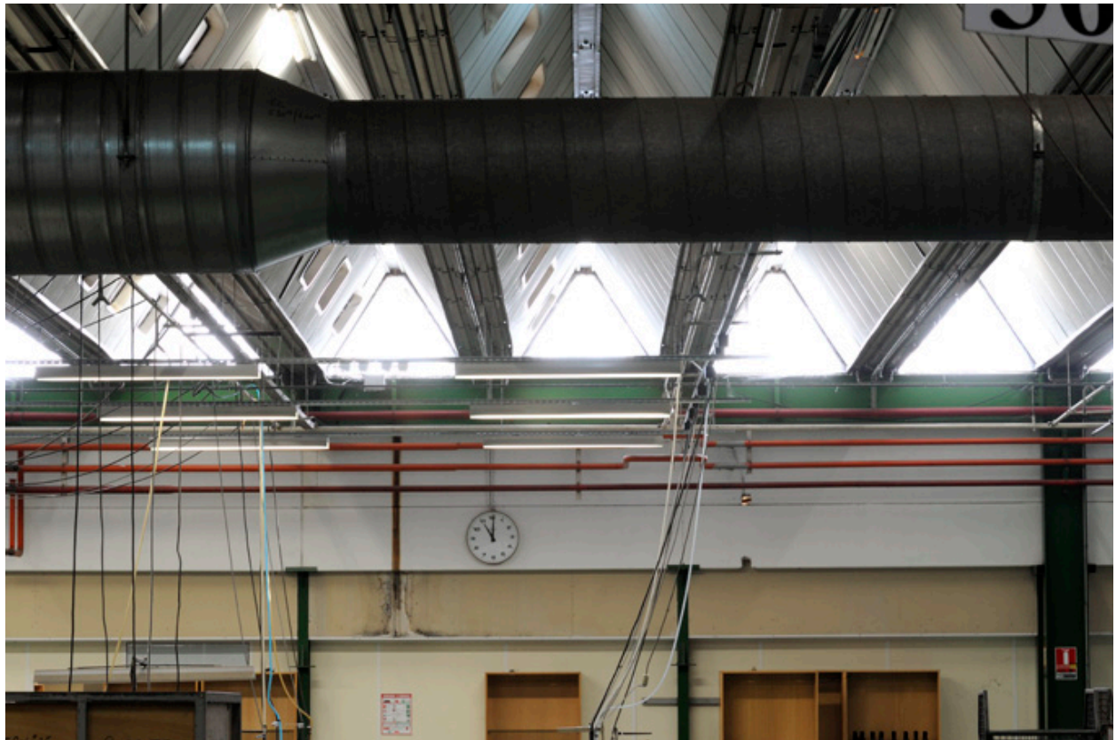
Usine SACAIR : détail des sheds.
