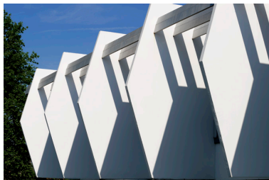
Siège du Groupe SAC : détail de la façade. Phot. Bruno Rousseau, Phot. Youenn Communeau IVR52_20114900298NUCA
