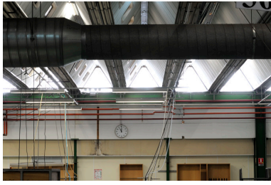
Usine SACAIR : détail des sheds.
