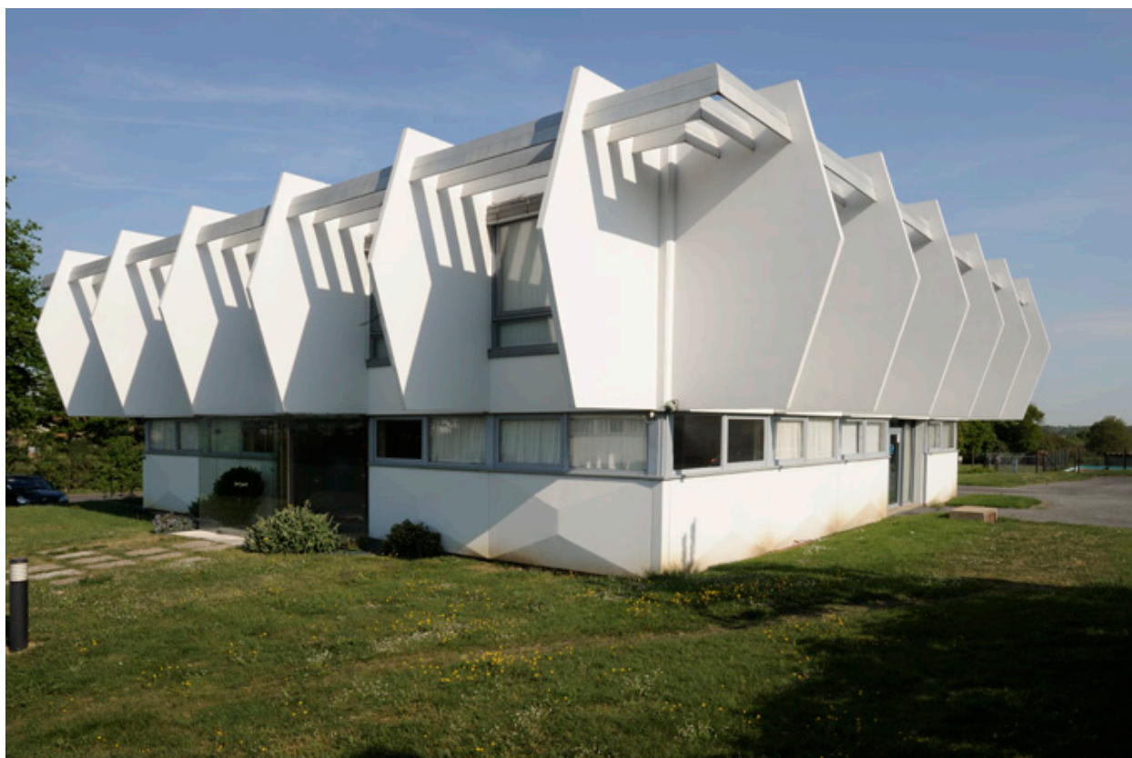
Siège du Groupe SAC : vue depuis le sud-est.
