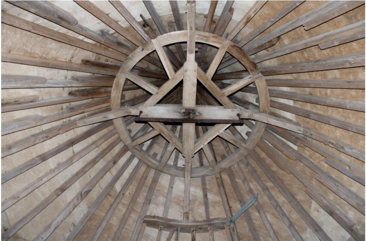
Étage de comble ; charpente de la coiffe.
