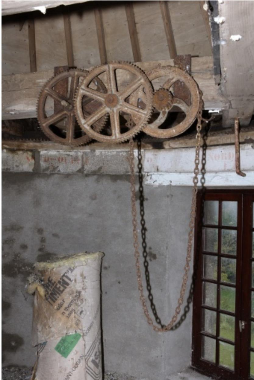
Étage de comble ; détail du treuil de giration de la coiffe.
