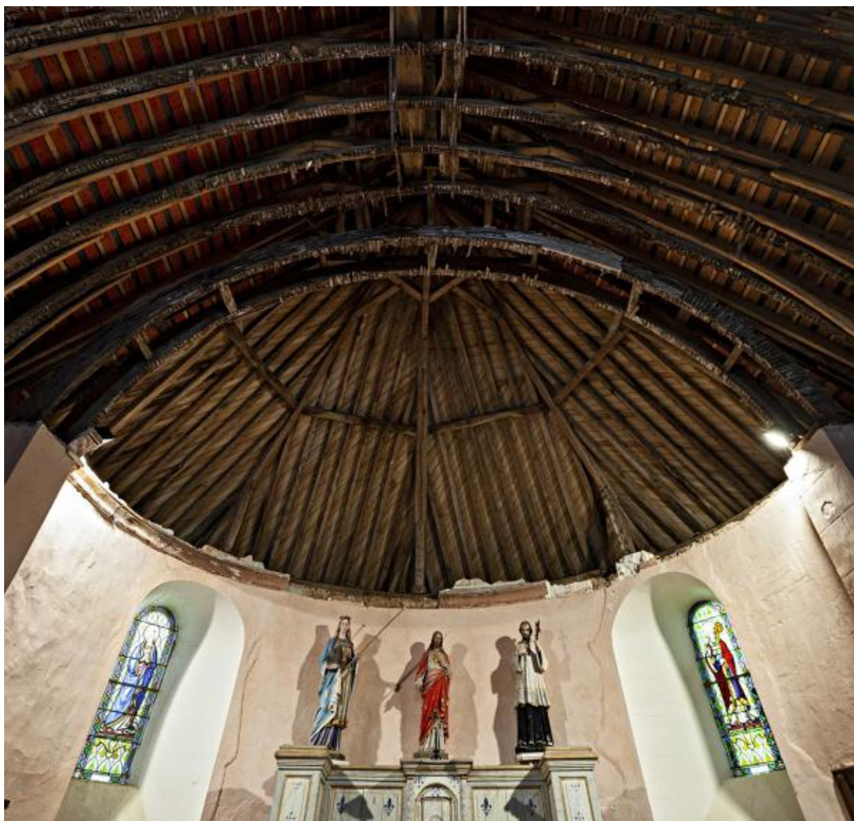
Chapelle Saint-Joseph, charpente de la nef et du chœur.
