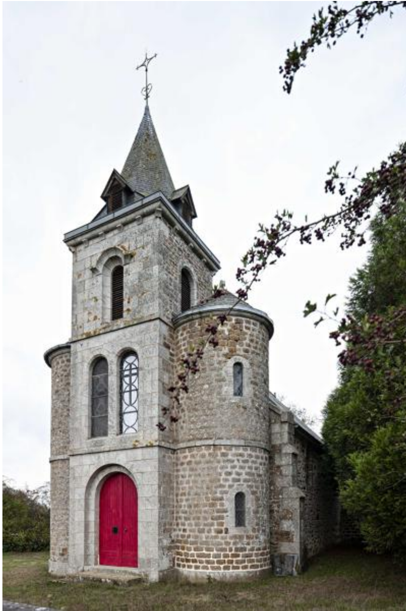
Chapelle Saint-Joseph, façade orientale, vue de trois-quarts.
