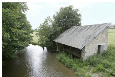
Le lavoir vu depuis le pont de Neuilly, à l'est. Phot. François Lasa IVR52_20075300379NUCA
