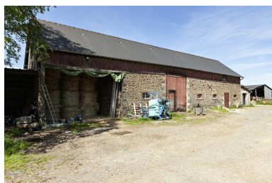
Corps occidental de bâtiment agricole de la ferme de l'Erable. Phot. Yves Guillotin IVR52_20215300665NUCA
