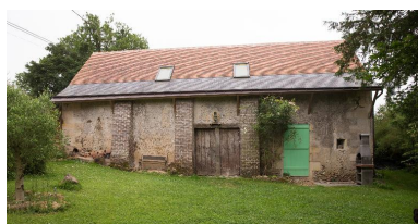
Grange-étable, façade sur cour. Phot. Pierre-Bernard Fourny IVR52_20187200843NUCA
