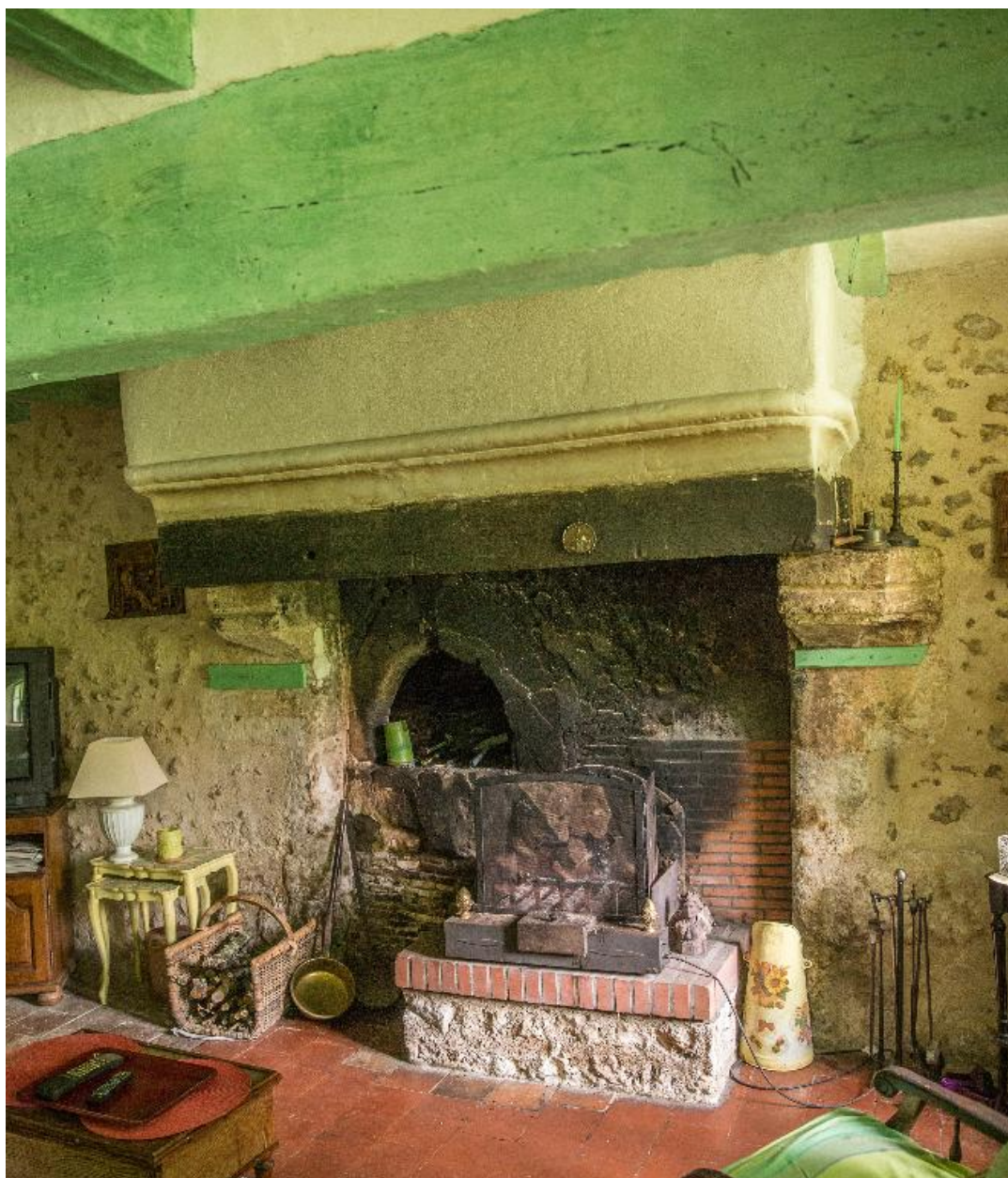
Logis, chambre à feu, détail : cheminée.
