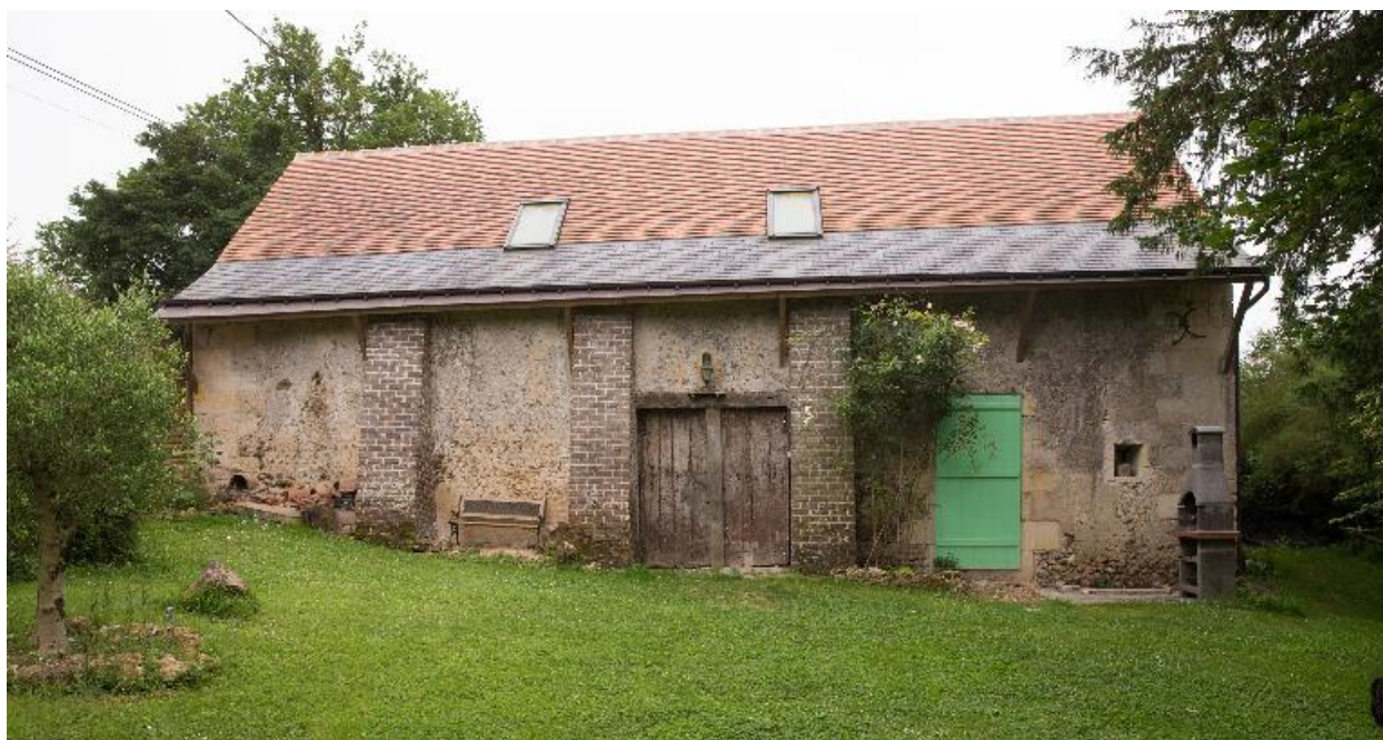
Grange-étable, façade sur cour.
