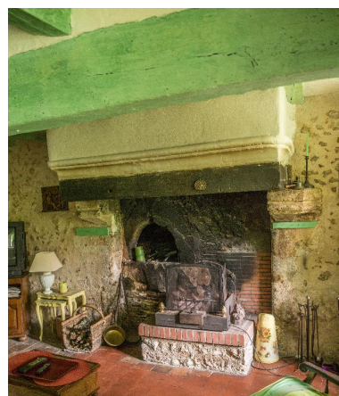
Logis, chambre à feu, détail : cheminée. Phot. Pierre-Bernard Fourny IVR52_20187200845NUCA
