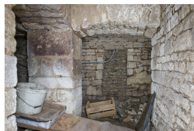
Premier niveau de sous-sol : caveau. Phot. Patrice Giraud IVR52_20098500208NUCA
