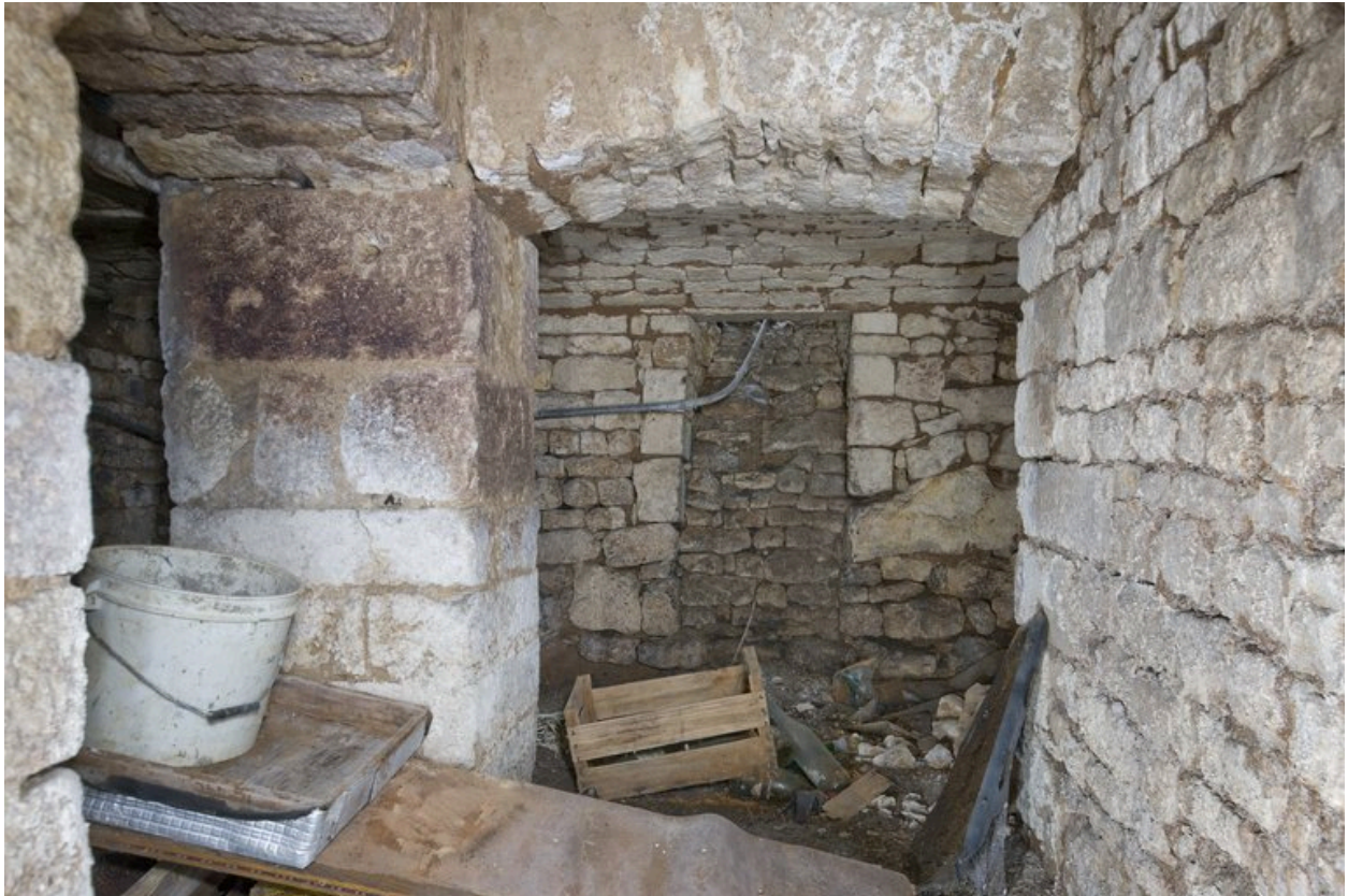
Premier niveau de sous-sol : caveau.
