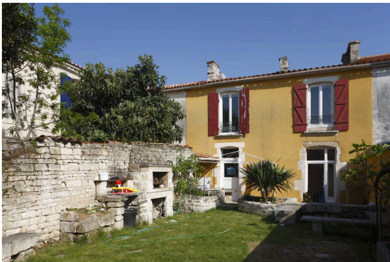
Vue des façades sur cour de la maison, prise de la cour du n°10.
