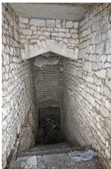
Escalier de descente au deuxième niveau de sous-sol. Phot. Patrice Giraud IVR52_20098500206NUCA
