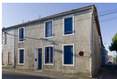
Façade du n° 8, rue Julien-David. Phot. Patrice Giraud IVR52_20098500389NUCA
