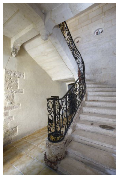
Vue de l'escalier prise du rez-de-chaussée (photo retouchée). Phot. Patrice Giraud IVR52_20098500212NUCA
