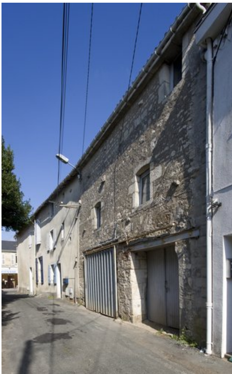
Vue de la façade latérale, rue du Bourg-Paillé, montrant les communs.
