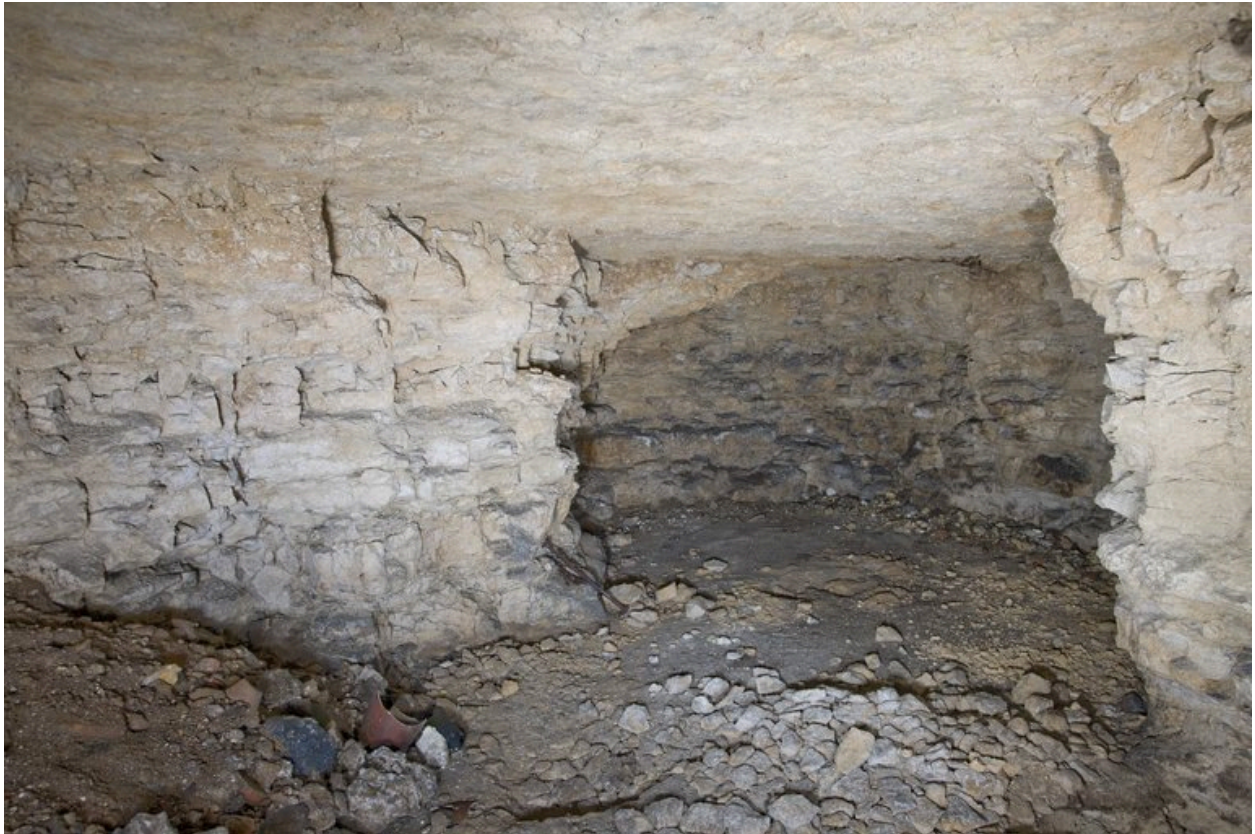
Deuxième niveau de sous-sol : ancienne carrière domestique.
