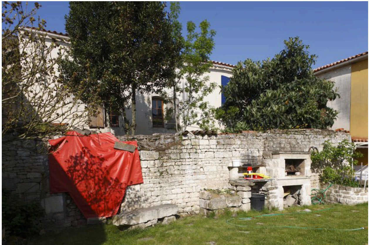
Vue des façades sur cour du n°8, prise de la cour du n°10.
