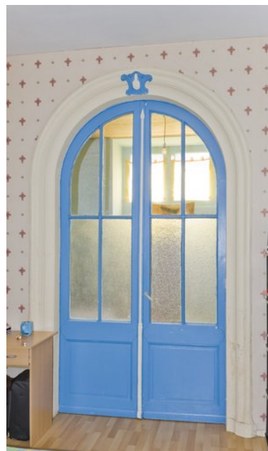
Porte au rez-de-chaussée du n° 8. Phot. Patrice Giraud IVR52_20098500205NUCA
