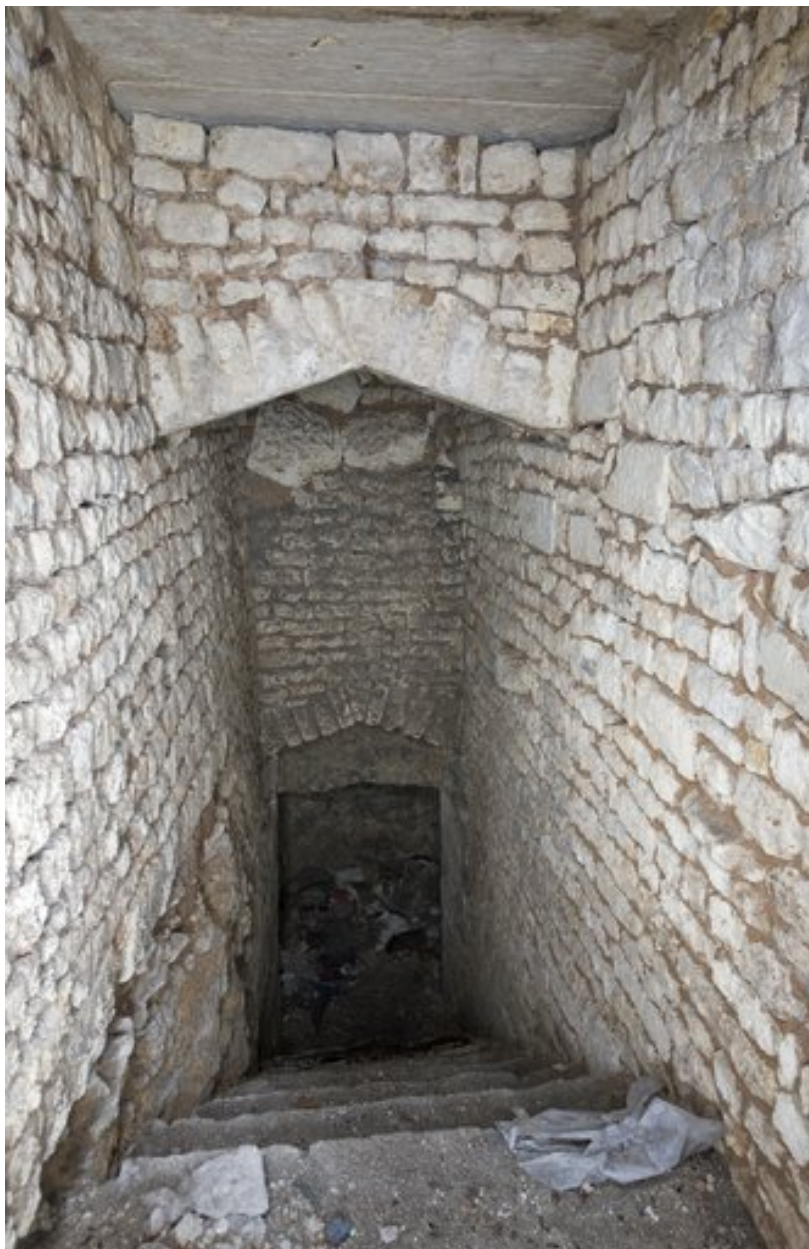
Escalier de descente au deuxième niveau de sous-sol.
