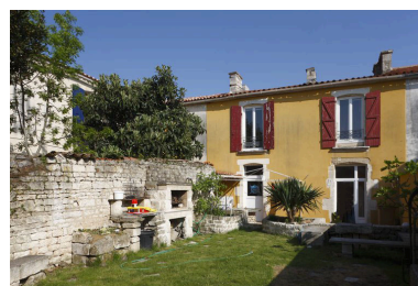
Vue des façades sur cour de la maison, prise de la cour du n°10. Phot. Patrice Giraud IVR52_20098500190NUCA
