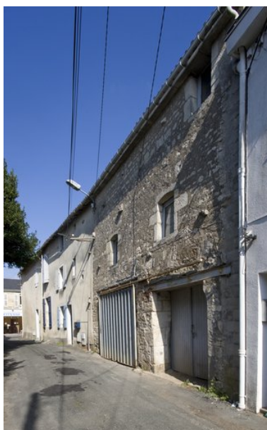
Vue de la façade latérale, rue du Bourg-Paillé, montrant les communs. Phot. Patrice Giraud IVR52_20098500512NUCA
