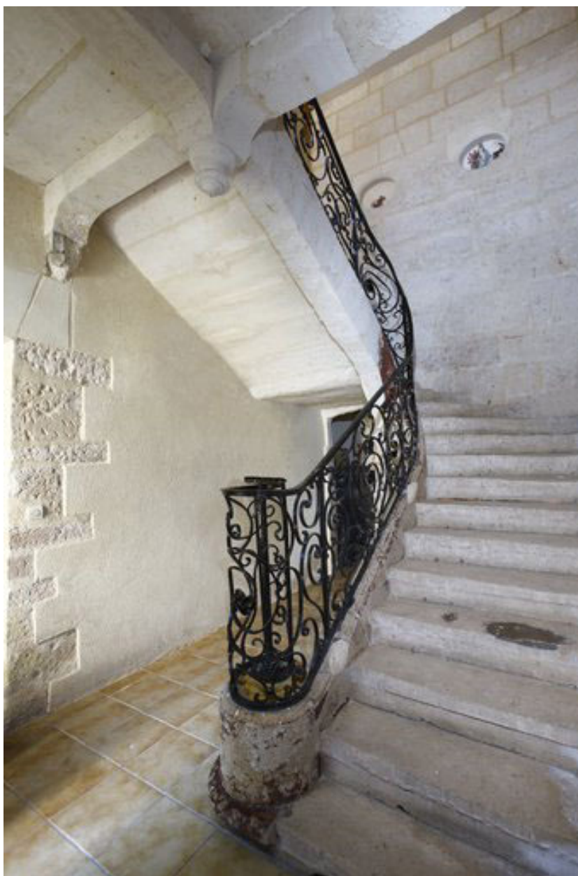
Vue de l'escalier prise du rez-de-chaussée (photo retouchée).
