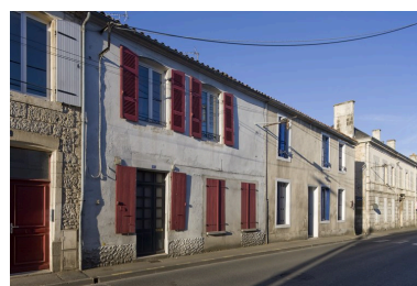
Vue d'ensemble de la façade sur rue, 8 et 10 rue Julien-David. Phot. Patrice Giraud IVR52_20098500386NUCA
