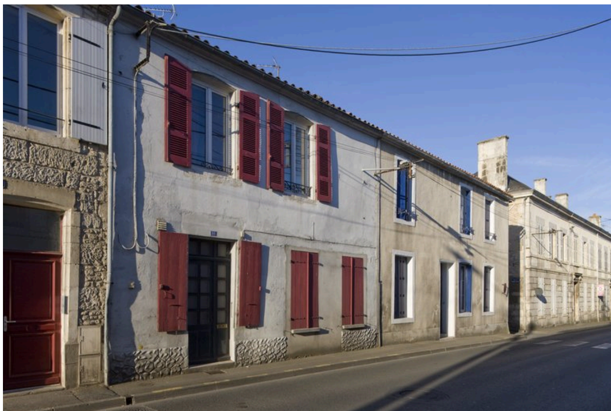
Vue d'ensemble de la façade sur rue, 8 et 10 rue Julien-David.
