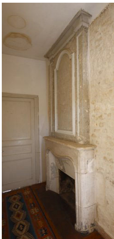
Cheminée à l'étage du n° 10. Phot. Patrice Giraud IVR52_20098500196NUCA
