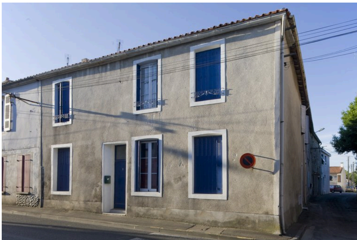
Façade du n° 8, rue Julien-David.
