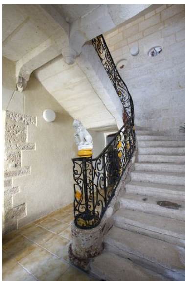
Vue de l'escalier prise du rez-de-chaussée. Phot. Patrice Giraud IVR52_20098500211NUCA
