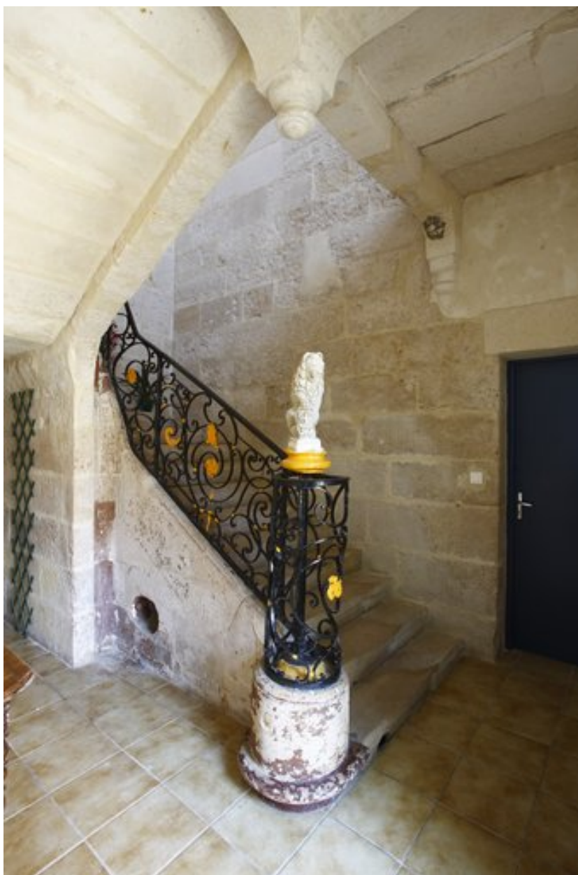
Vue de l'escalier prise du rez-de-chaussée.
