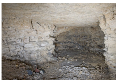
Deuxième niveau de sous-sol : ancienne carrière domestique. Phot. Patrice Giraud IVR52_20098500207NUCA
