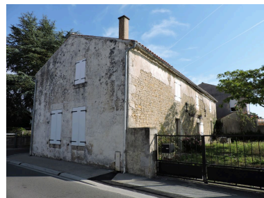
L'ancien logement de fermier, reconstruit en 1842, vu depuis le sud. Phot. Yannis Suire IVR52_20198502312NUCA
