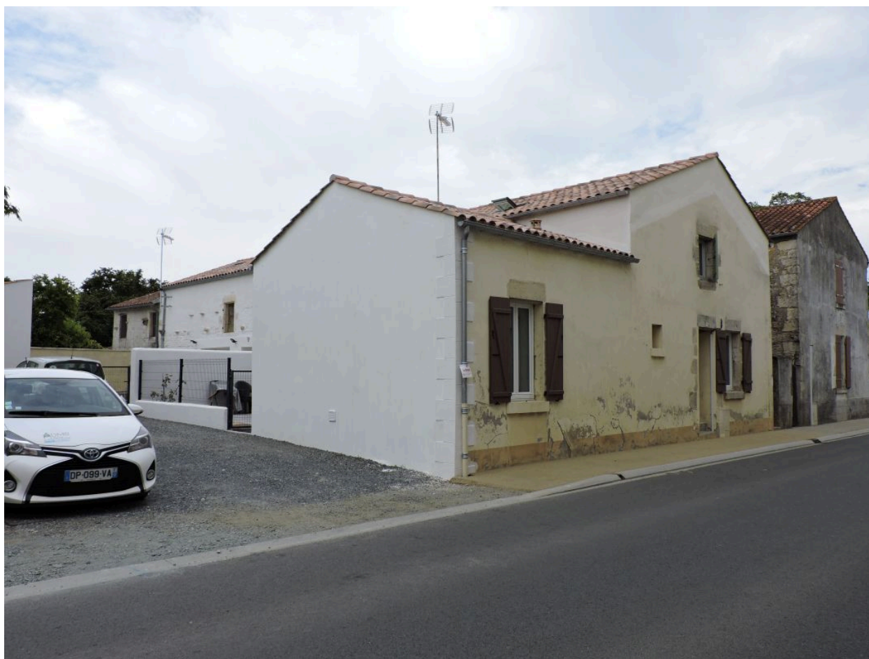
Les anciennes dépendances à l'est de la cour vues depuis l'ouest.
