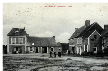
Carte postale, début du XXe siècle. Vue depuis la place au nord-est. La maison est la première à droite. Autr. Pavy-Legeard, Phot. François Lasa IVR52_20055302008NUCA
