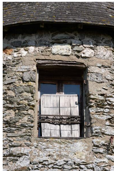
Moulin à farine dit moulin des Buttes (n° 1) ou moulin de l'Ouche-Neuve. Détail de la fenêtre ouest et de la date portée 1735. Phot. Armelle Maugin IVR52_20254900390NUCA
