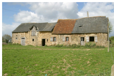
Vue d'ensemble depuis le sud-ouest : façade principale. Phot. François Lasa IVR52_20035301436NUCA
