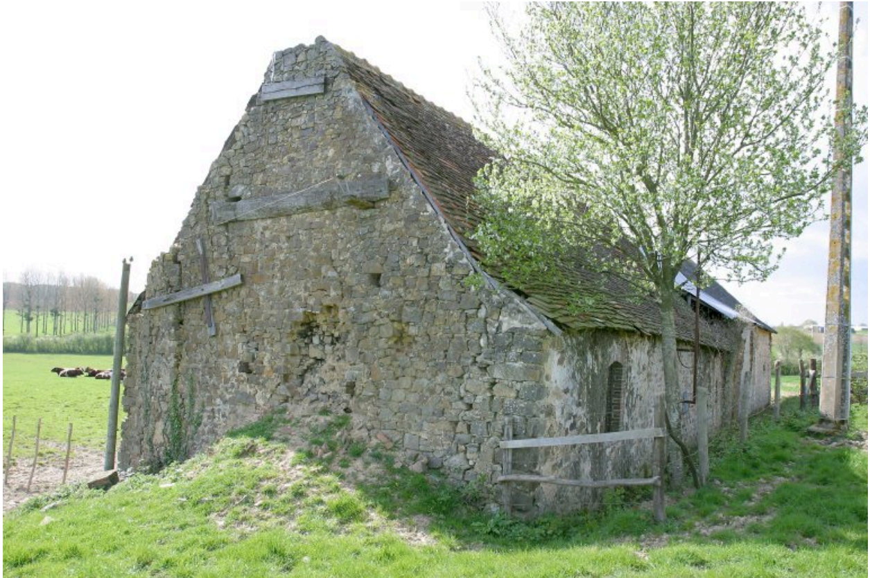
Le pignon sud-ouest et la façade arrière.
