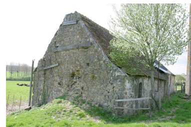
Le pignon sud-ouest et la façade arrière. Phot. François Lasa IVR52_20035301437NUCA
