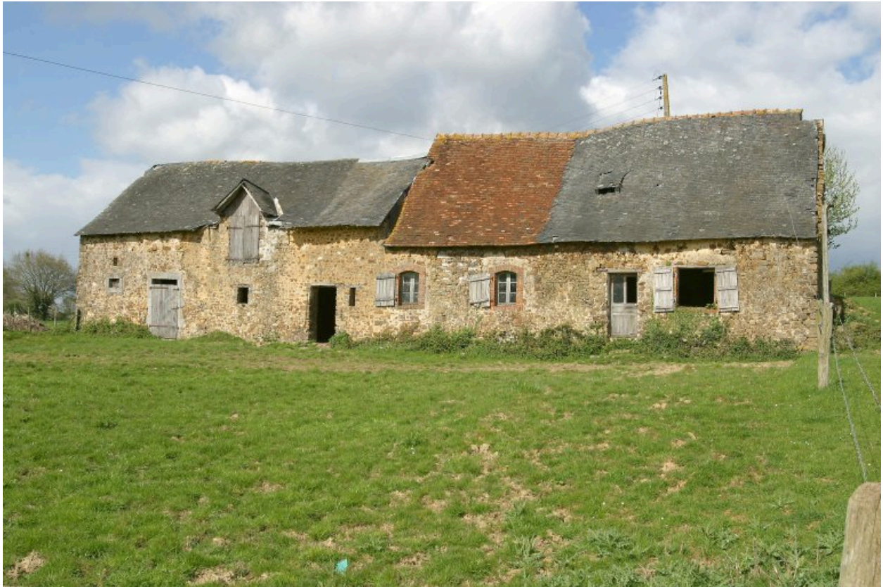
Vue d'ensemble depuis le sud-ouest : façade principale.
