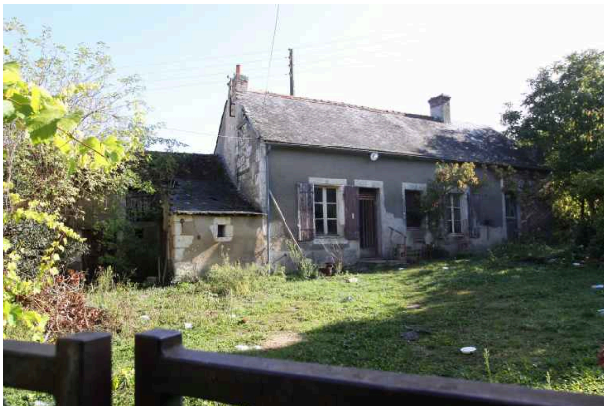
La maison n° 3 : façade antérieure sur cour.
