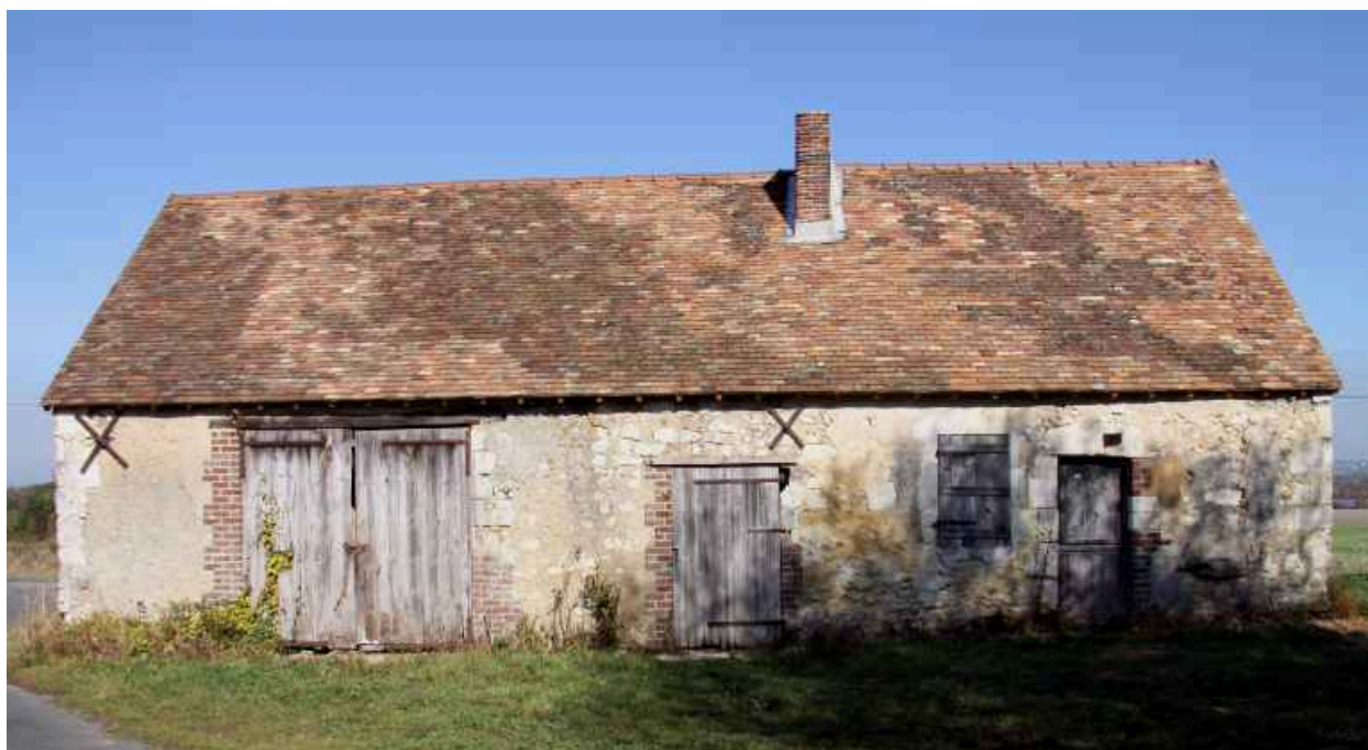
La maison n° 1 : façade sur cour.
