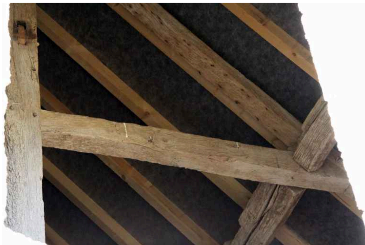
La maison n° 1 : charpente à pannes à encoche dans le faux entrain.
