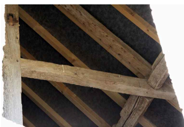
La maison n° 1 : charpente à pannes à encoche dans le faux entrail. Phot. Jean-Baptiste Darrasse IVR52_20087202382NUCA
