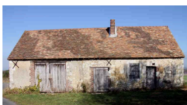
La maison n° 1 : façade sur cour. Phot. Jean-Baptiste Darrasse IVR52_20087202380NUCA
