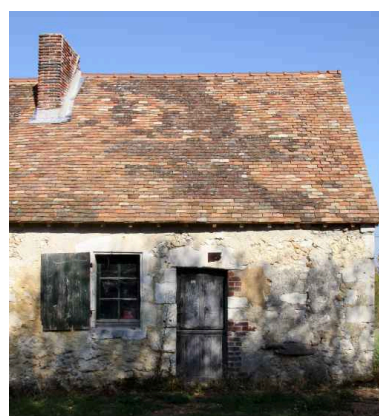
La maison n° 1 : chambre à feu. Phot. Jean-Baptiste Darrasse IVR52_20087202381NUCA
