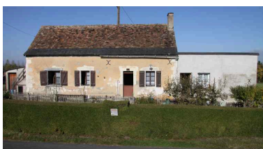
La maison n° 2, vue d'ensemble : adjonction navrante ! Phot. Jean-Baptiste Darrasse IVR52_20087202375NUCA
