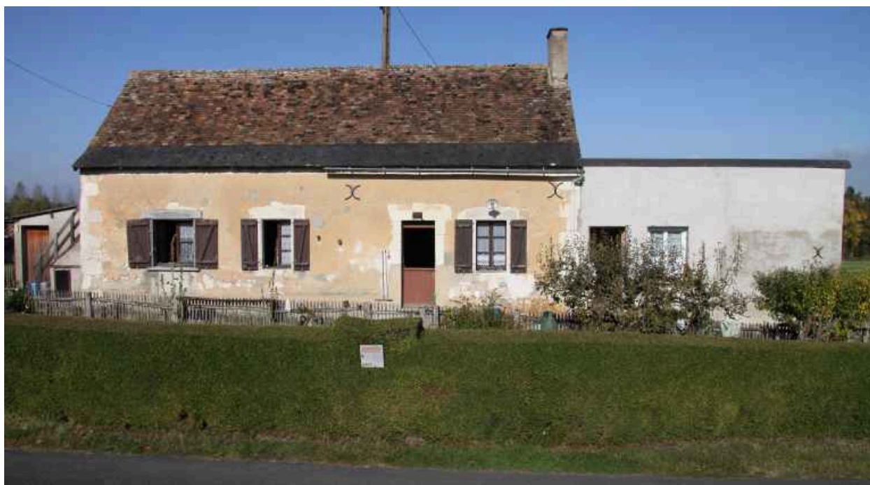
La maison n° 2, vue d'ensemble : adjonction navrante !
