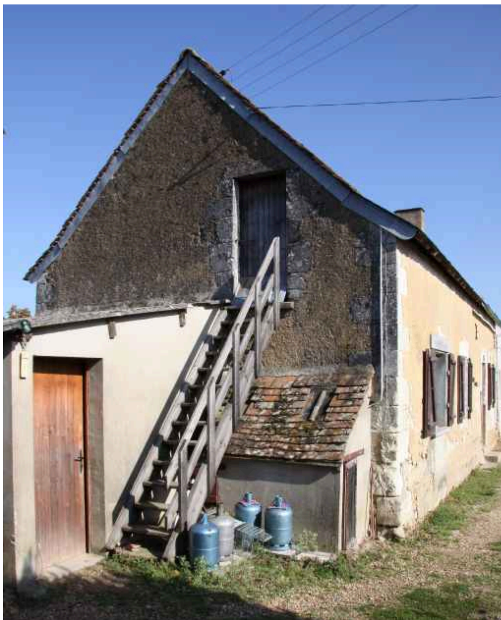
La maison n° 2 : pignon.
