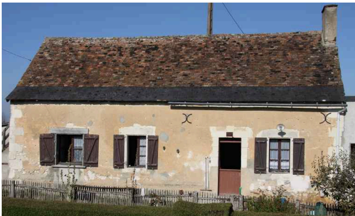
La maison n° 2, façade antérieure : l'ancienne étable est devenue chambre.
