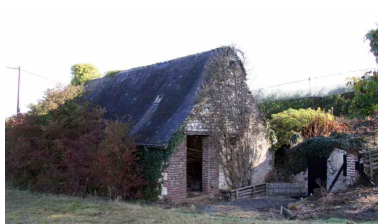
Pignon sud : entrée de la remise. Phot. Jean-Baptiste Darrasse IVR52_20087202359NUCA
