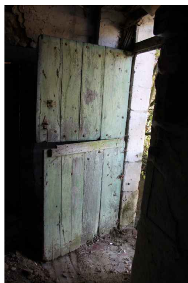
La maison : menuiserie de la porte d'entrée, avers. Phot. Jean-Baptiste Darrasse IVR52_20087202369NUCA
