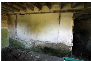
Espace du four à pain limité par une cloison en pan de bois sur solin (vue extérieure). Phot. Jean-Baptiste Darrasse
