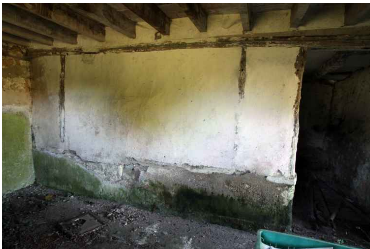
Espace du four à pain limité par une cloison en pan de bois sur solin (vue extérieure).
