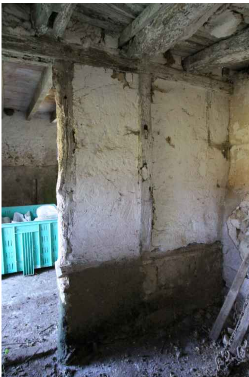
Espace du four à pain limité par une cloison en pan de bois sur solin (vue intérieure).
