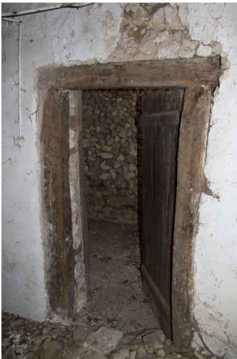
La maison : porte entre la salle et la chambre froide.
