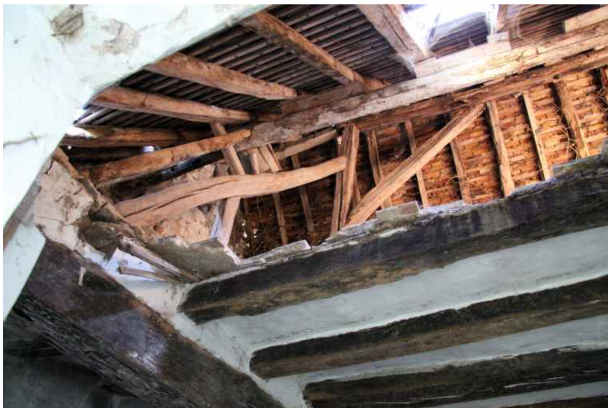
La maison : charpente à pannes.
