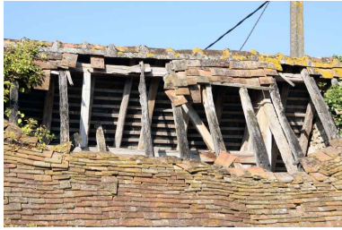
Couverture de l'extension en tuile plate. Phot. Jean-Baptiste Darrasse IVR52_20087202361NUCA
