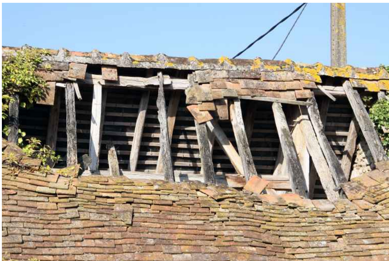
Couverture de l'extension en tuile plate.
