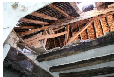
La maison : charpente à pannes. Phot. Jean-Baptiste Darrasse IVR52_20087202353NUCA
