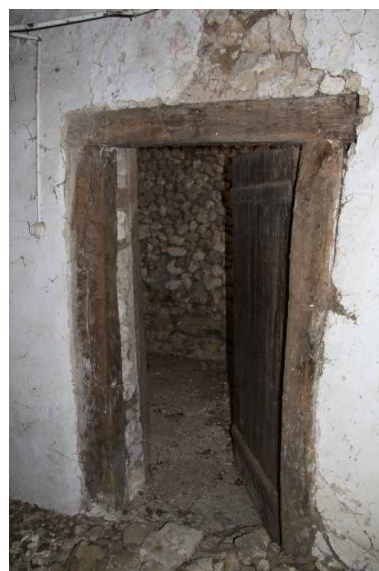
La maison : porte entre la salle et la chambre froide. Phot. Jean-Baptiste Darrasse IVR52_20087202368NUCA
