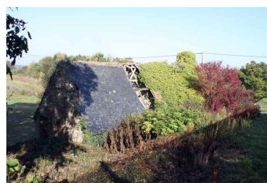
Vue de volume de la maison et de ses dépendances (prise de l'est). Phot. Jean-Baptiste Darrasse IVR52_20087202360NUCA
