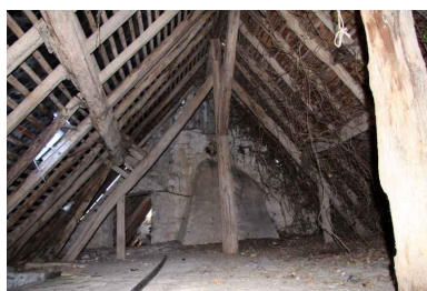
La maison : grenier carrelé et forme de la charpente. Phot. Jean-Baptiste Darrasse IVR52_20087202358NUCA
