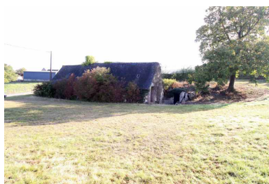
Vue de volume prise du sud-ouest. Phot. Jean-Baptiste Darrasse IVR52_20087202372NUCA
