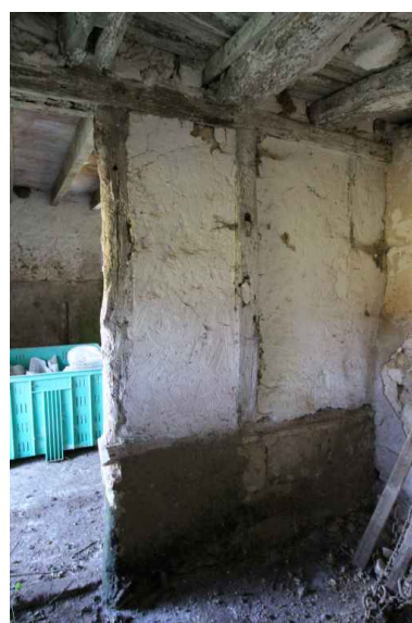
Espace du four à pain limité par une cloison en pan de bois sur solin (vue intérieure). Phot. Jean-Baptiste Darrasse IVR52_20087202364NUCA
