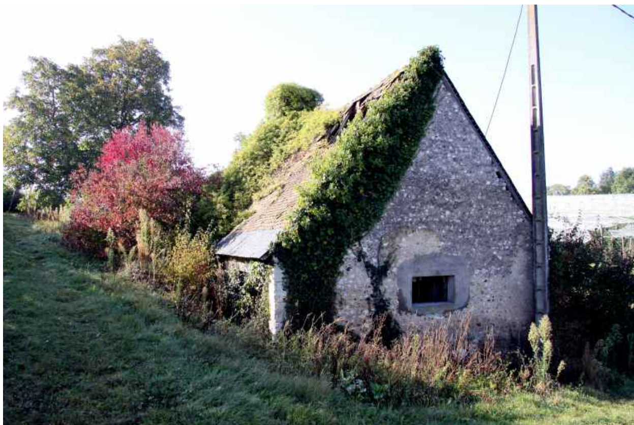
Pignon nord : extension qui englobe le four à pain sous un même toit.
