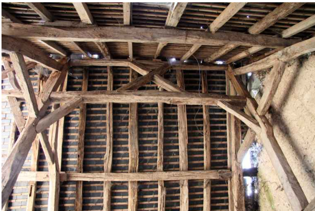
La remise : travée de la charpente avec un sous-faîtage et croix-de-saint-André.
