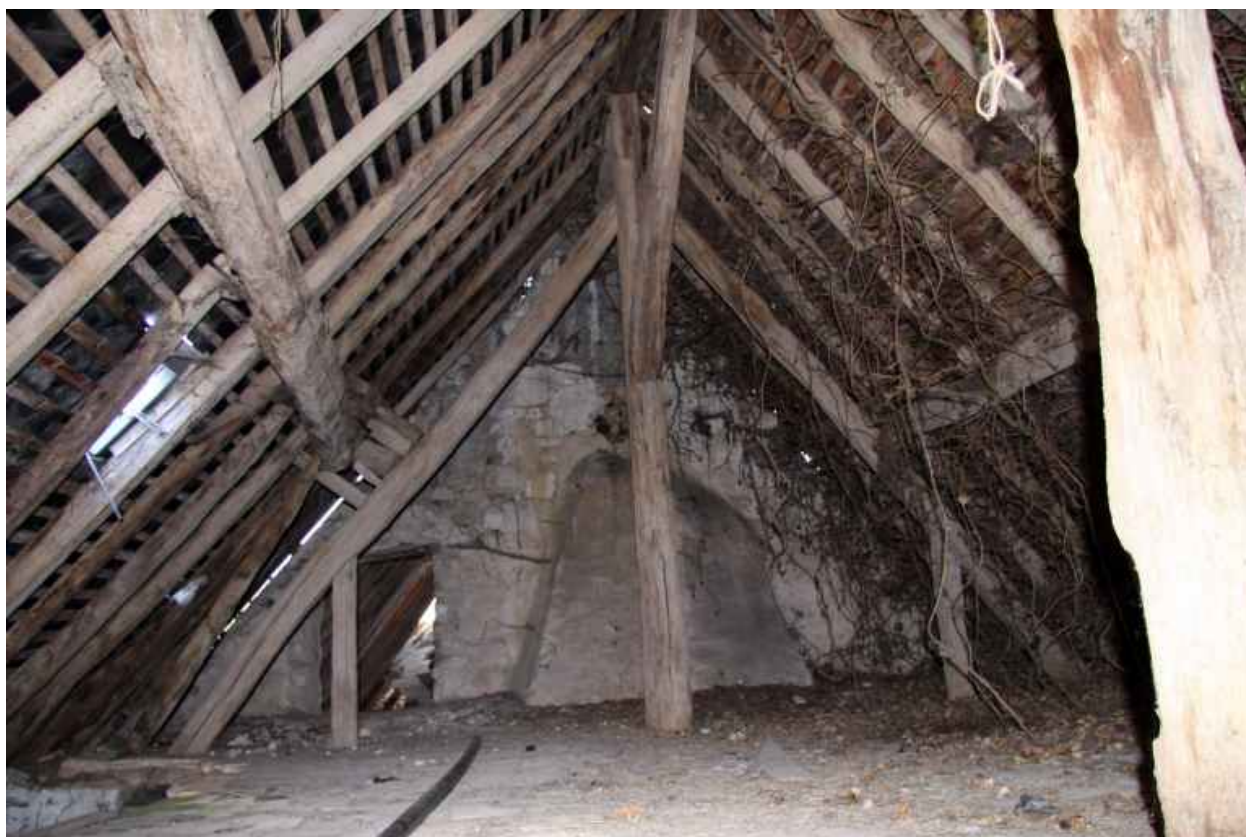
La maison : grenier carrelé et forme de la charpente.
