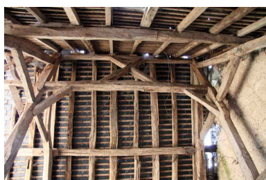
La remise : travée de la charpente avec un sous-faîtage et croix-de-saint-André. Phot. Jean-Baptiste Darrasse IVR52_20087202355NUCA
