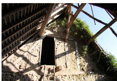
Remise : pignon en pan de bois entre la maison et la remise. Phot. Jean-Baptiste Darrasse IVR52_20087202357NUCA
