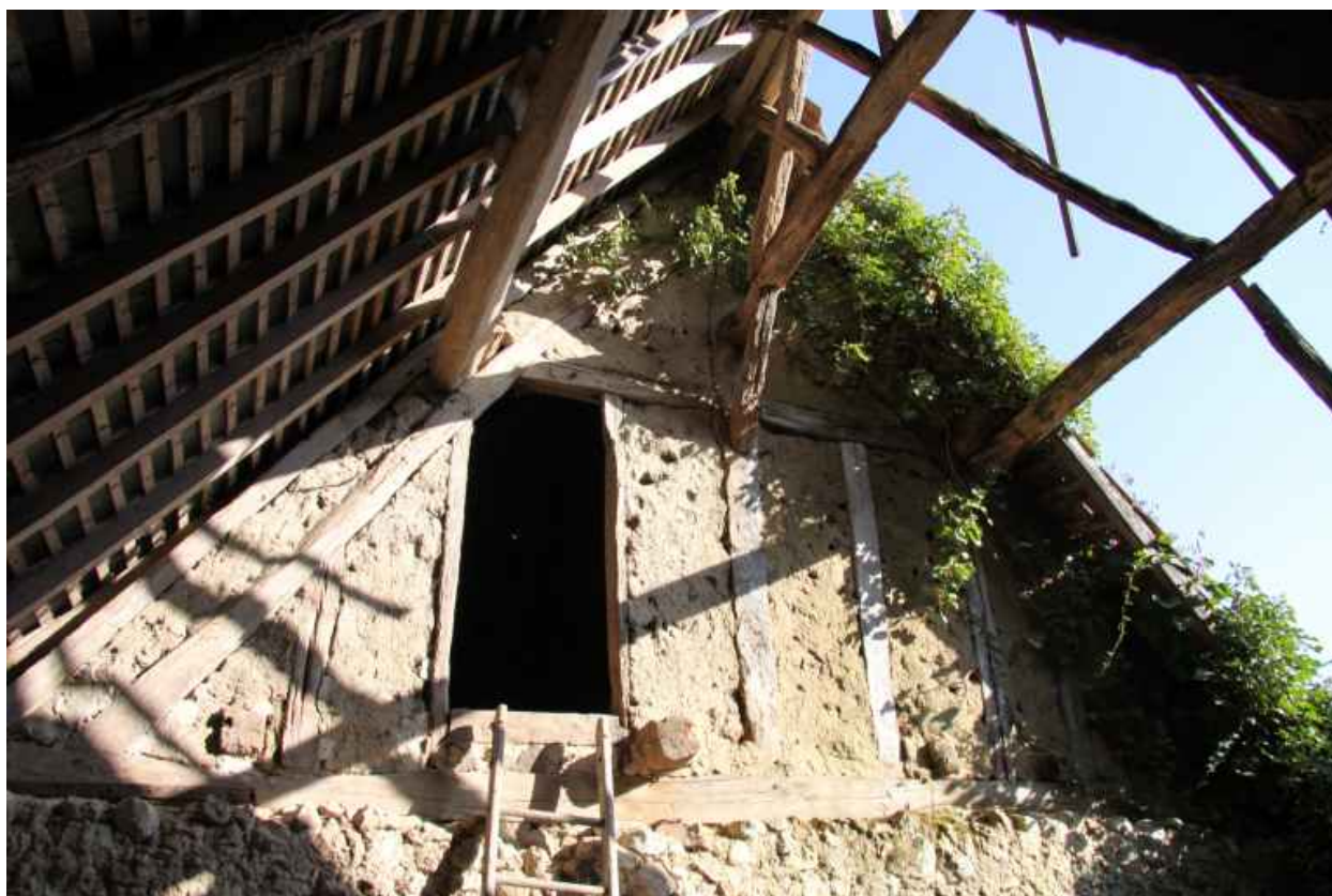
Remise : pignon en pan de bois entre la maison et la remise.
