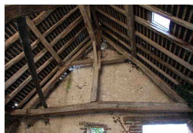
La remise : revers du pignon sud. Phot. Jean-Baptiste Darrasse IVR52_20087202354NUCA
