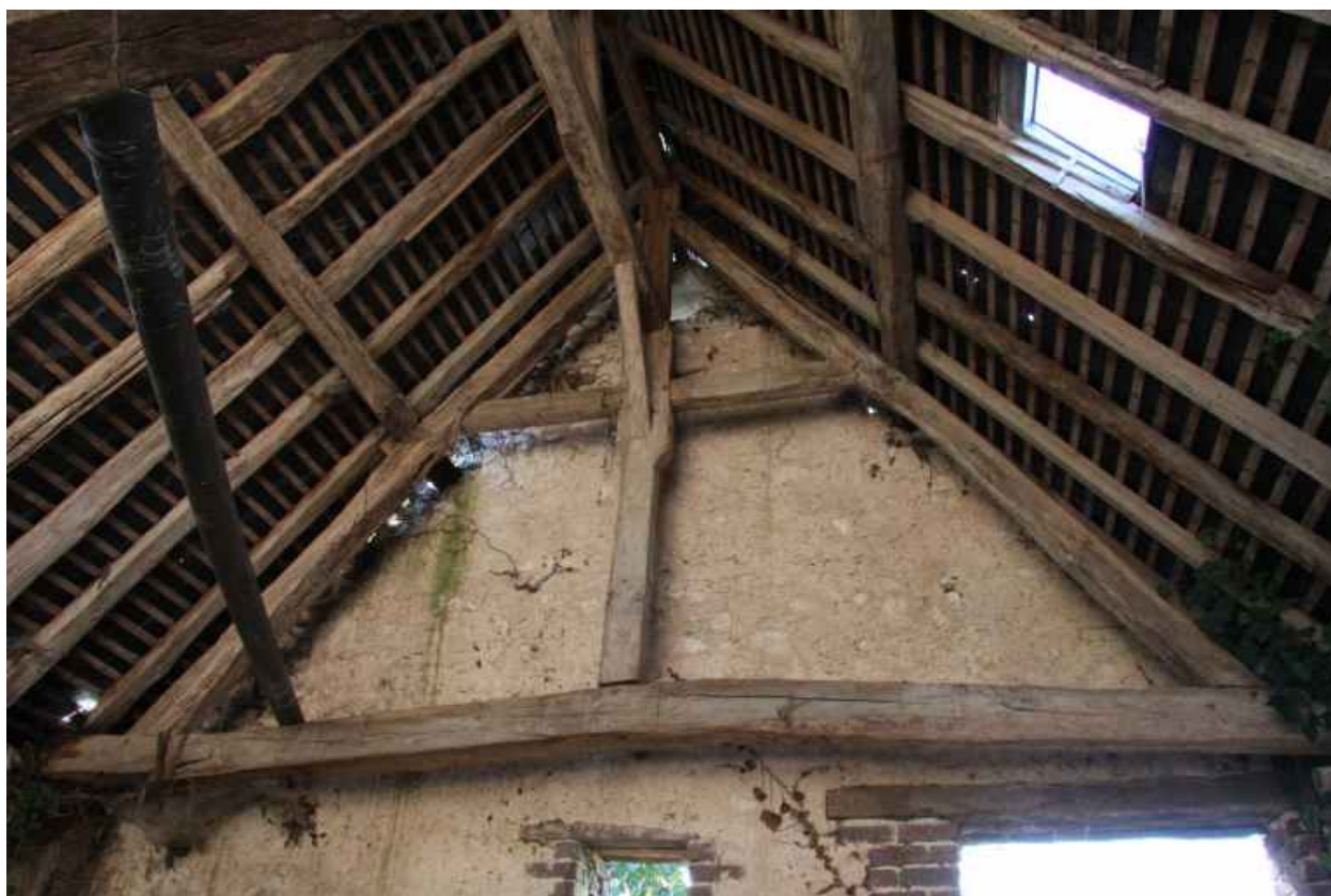
La remise : revers du pignon sud.
