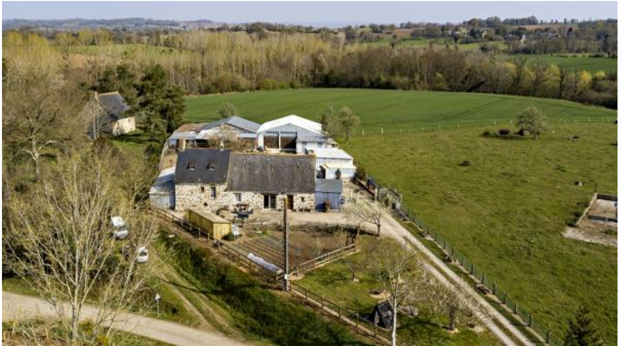
Ferme de la Monnerie.
