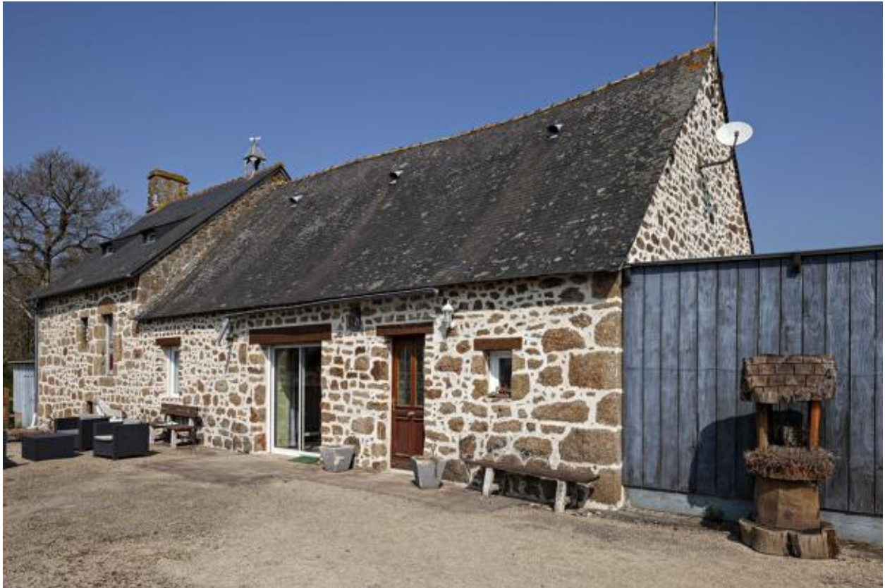
Ferme de la Monnerie.
