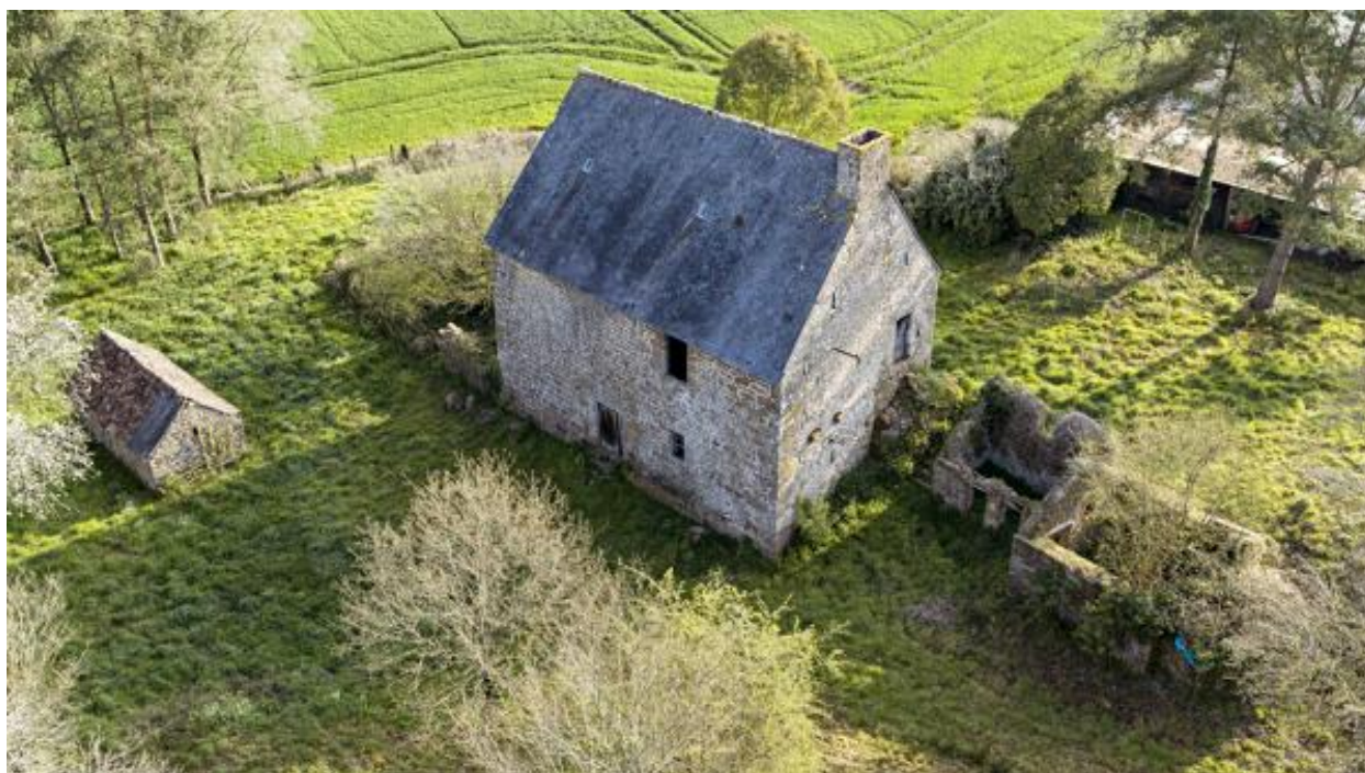
Vue aérienne du manoir.
