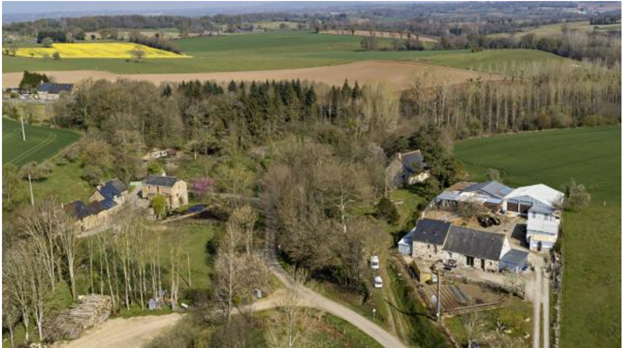
Vue aérienne du manoir, du moulin et de la ferme.
