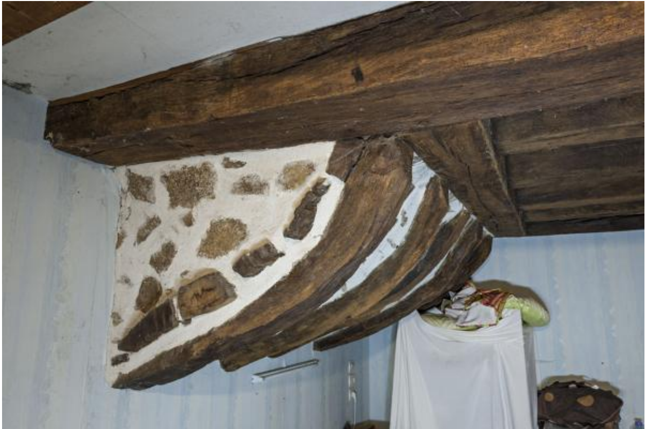
Logis de la ferme, support de la cheminée.
