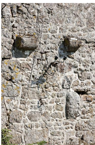
Mur-pignon sud du manoir. Phot. Yves Guillotin IVR52_20215300240NUCA
