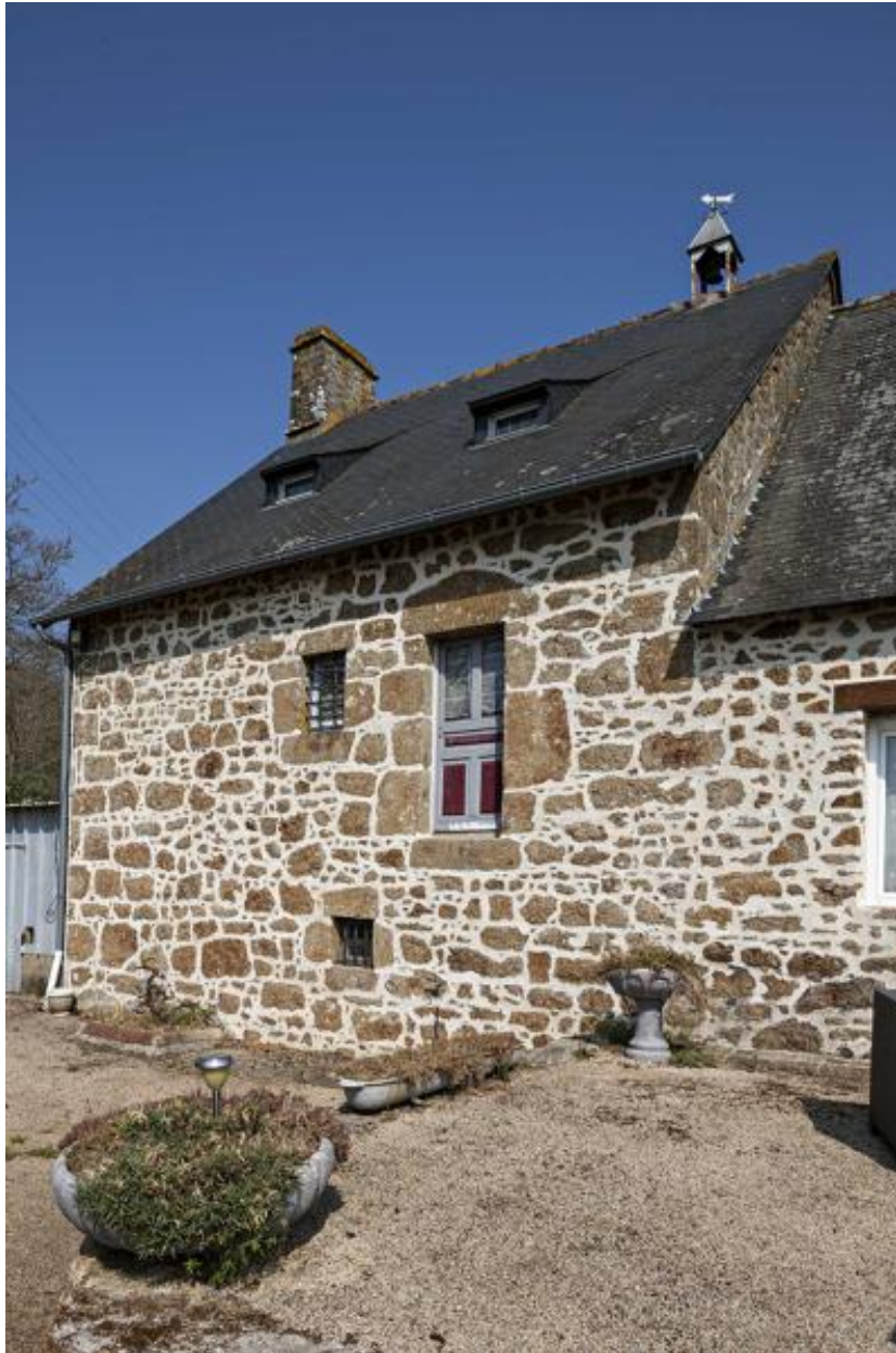
Ferme de la Monnerie, logis ouest, façade sud.
