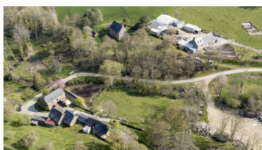
Vue aérienne du manoir, du moulin et de la ferme. Phot. Yves Guillotin IVR52_20215300234NUCA
