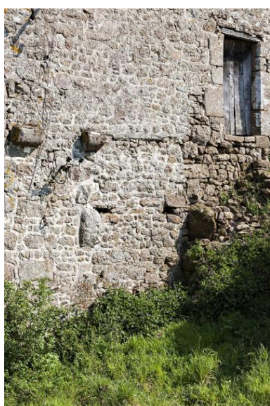
Mur-pignon sud du manoir. Phot. Yves Guillotin IVR52_20215300241NUCA
