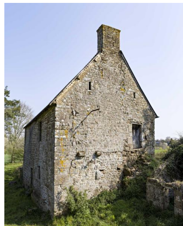
Mur-pignon sud du manoir. Phot. Yves Guillotin IVR52_20215300239NUCA
