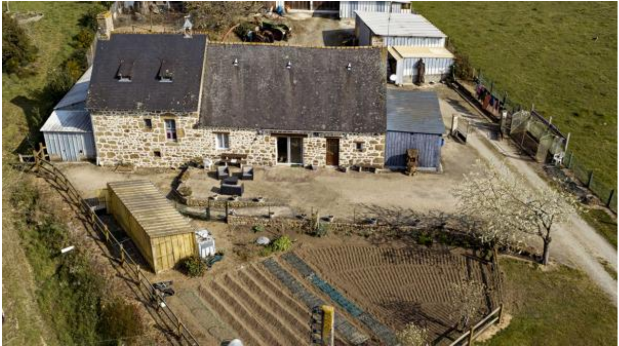
Ferme de la Monnerie.
