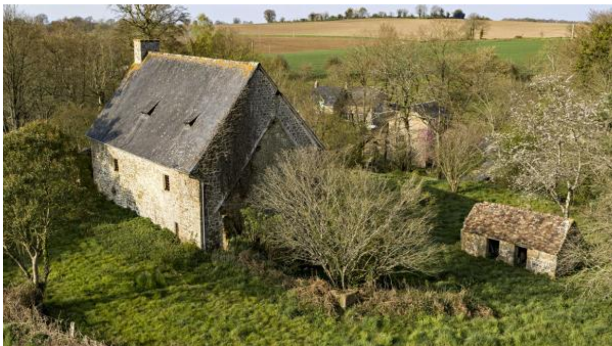
Vue aérienne du manoir.
