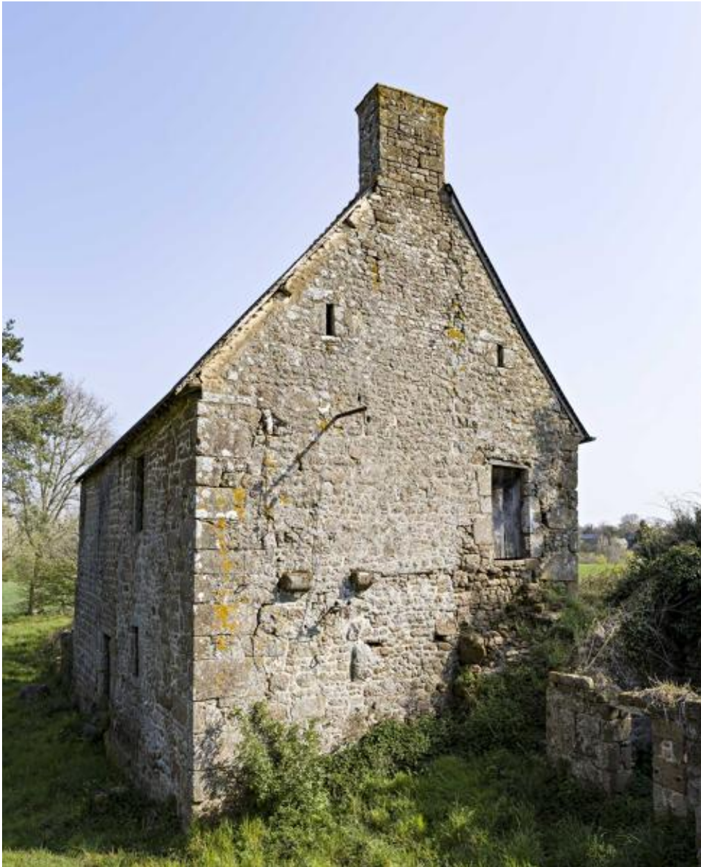
Mur-pignon sud du manoir.
