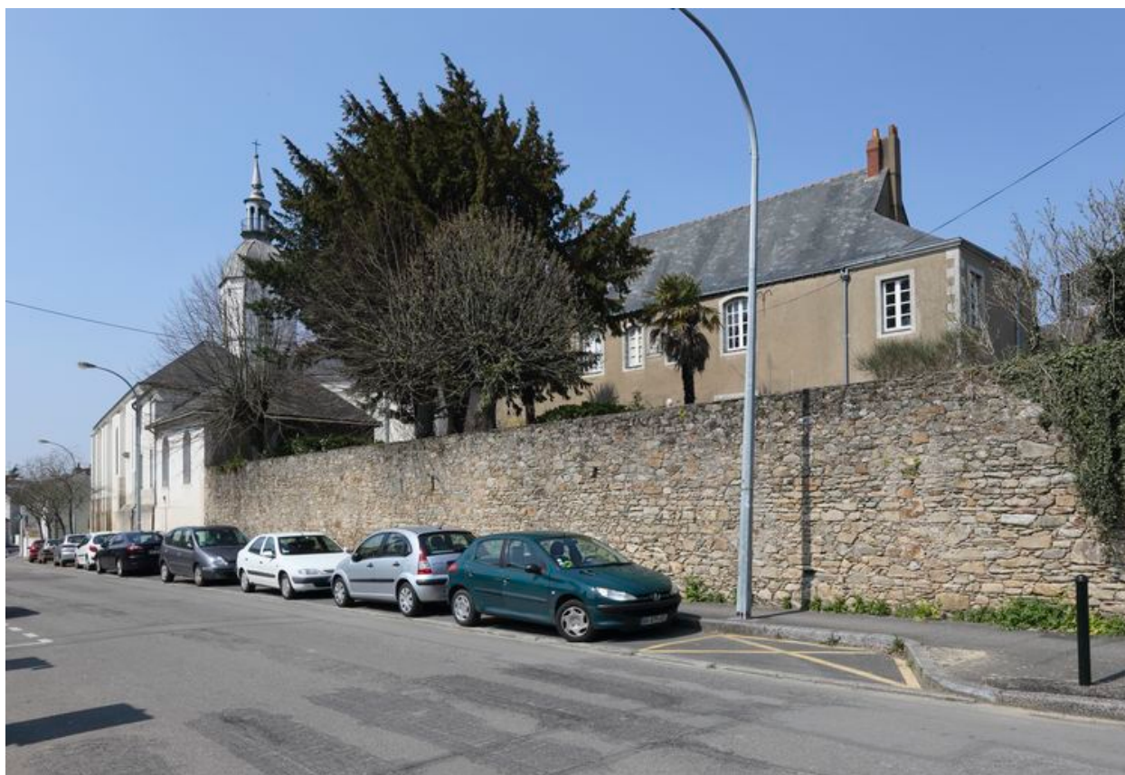
Mur de clôture du presbytère.
