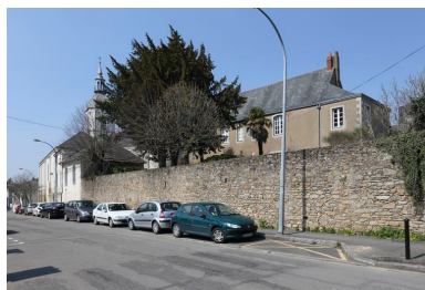
Mur de clôture du presbytère. Phot. Denis Pillet IVR52_20134401384NUCA
