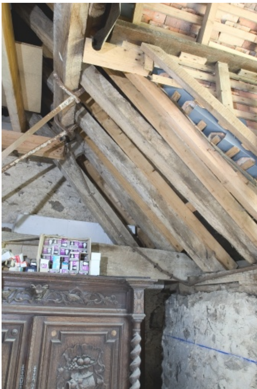
Intérieur de la partie ouest : partie sud de la charpente.
