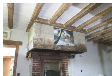
Intérieur de la partie ouest : cheminée de la pièce ouest.
