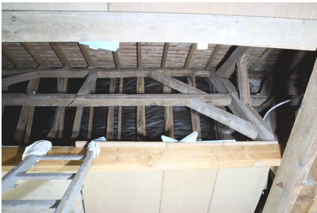
Intérieur de la partie ouest : la panne faîtière et la panne sous-faîtière de la charpente.
