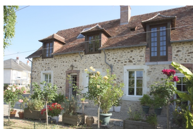
La partie ouest vue depuis le sud : façade principale.
