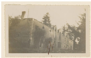
Les communs endommagés après la guerre, photographie vers 1945. Repro. Morgane Acou-Le Noan IVR52_20215300539NUCA
