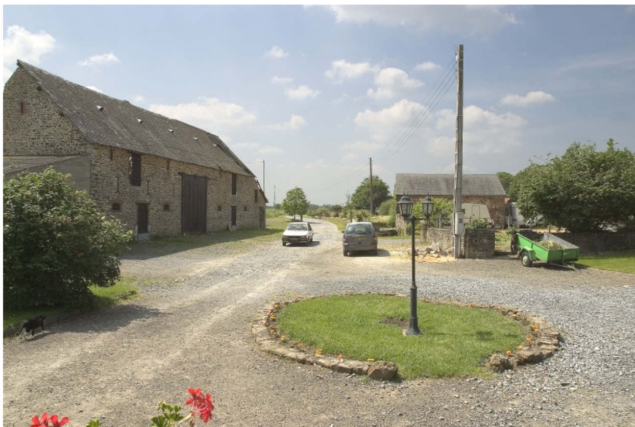
L'étable-grange et la petite dépendance sud vues depuis la cour au nord.
