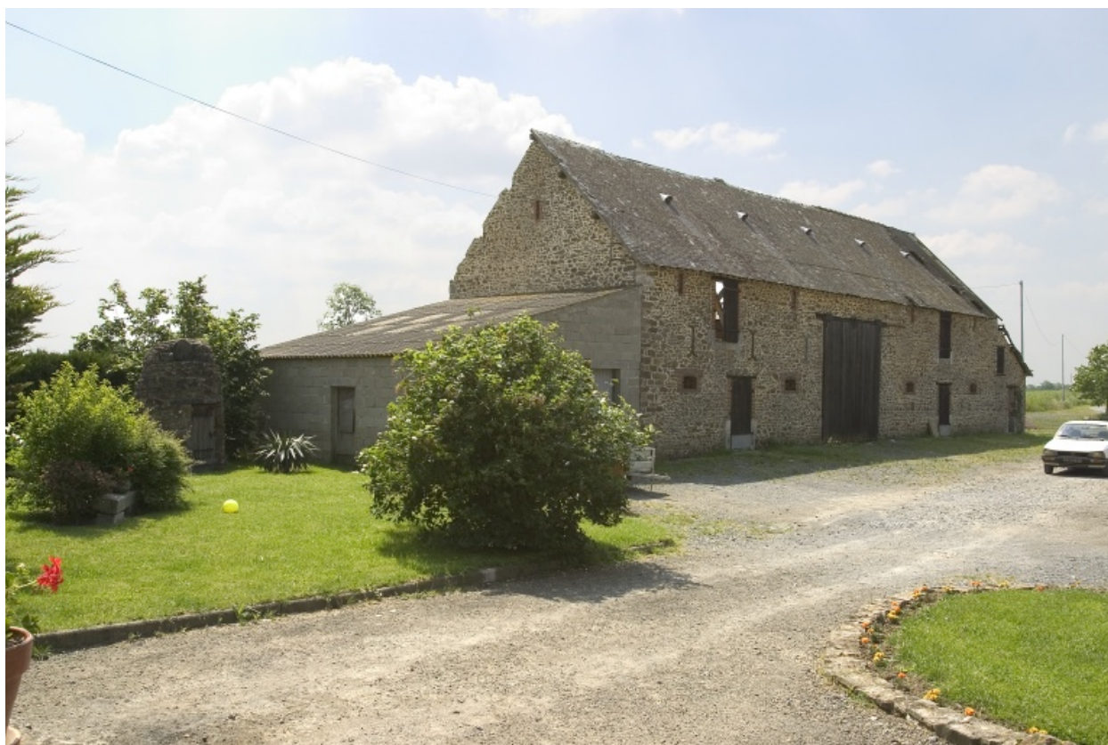
L'étable-grange vue depuis la cour au nord.
