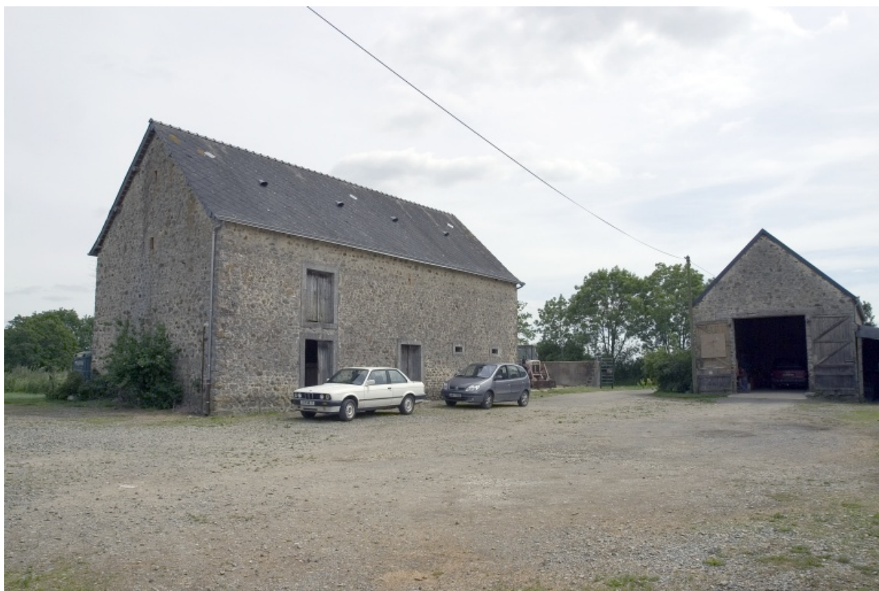
L'étable à vache-grange et la remise vues depuis le nord.
