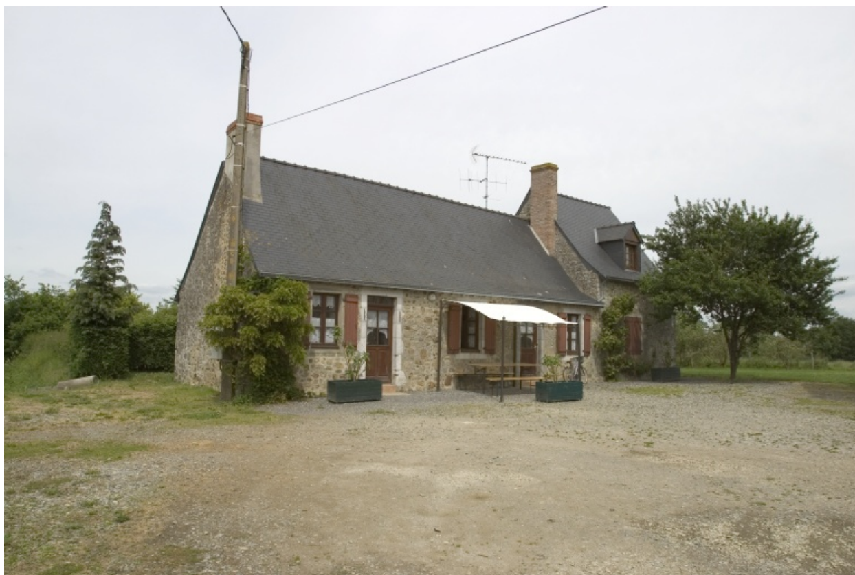
La façade principale du logis.
