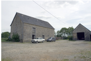
L'étable à vache-grange et la remise vues depuis le nord. Phot. François Lasa IVR52_20045301804NUCA
