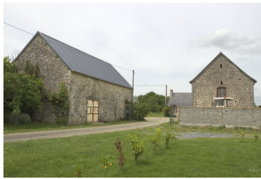
Vue d'ensemble depuis le sud : la remise, le logis, l'étable à vaches-grange. Phot. François Lasa IVR52_20045301807NUCA
