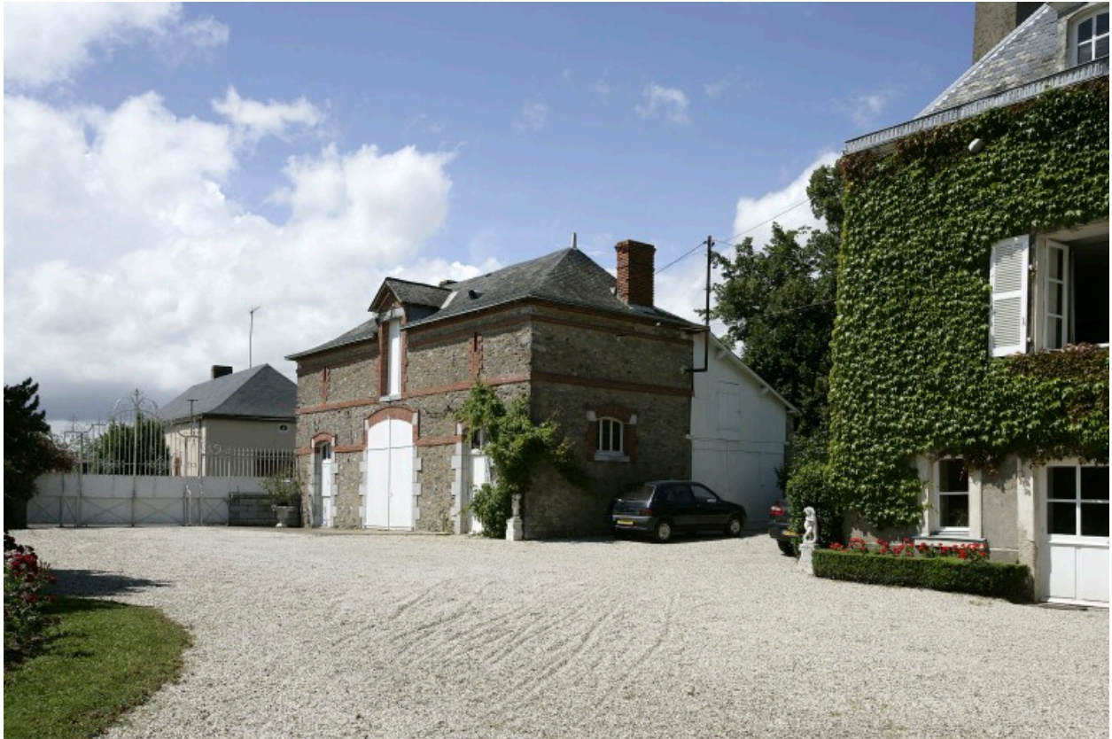
La remise à voitures-écurie vue depuis le sud-est. A gauche, la maison du jardinier, à droite la maison de maître.
