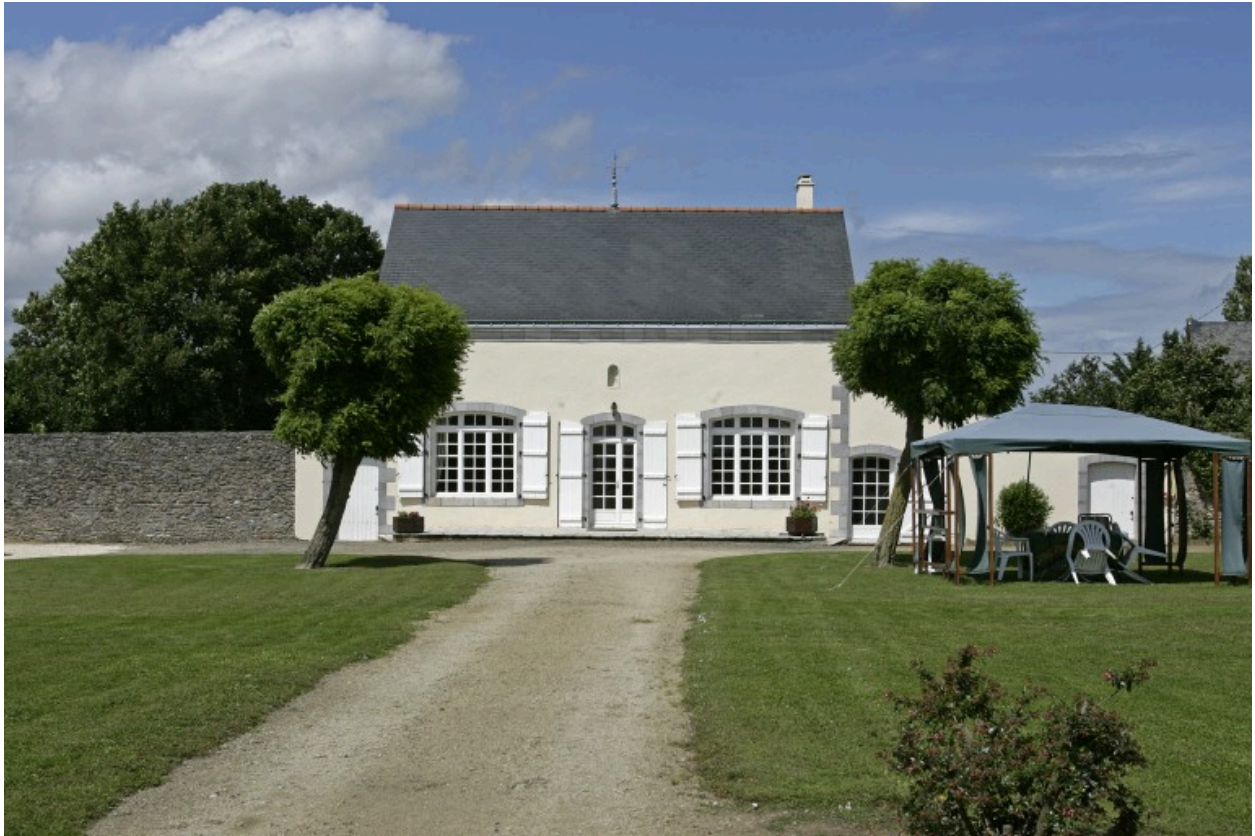
Le logement vu depuis le sud.
