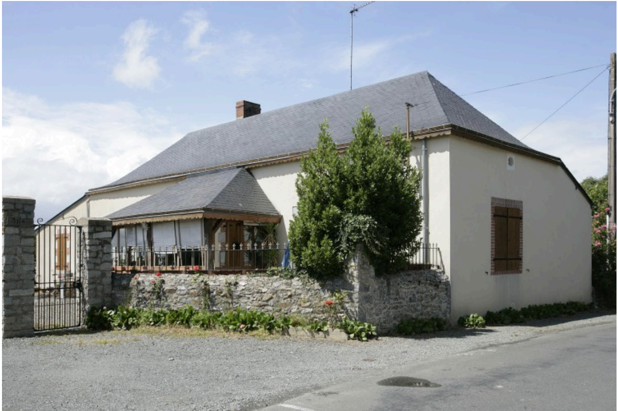
La maison du jardinier vue depuis la route au sud-est.
