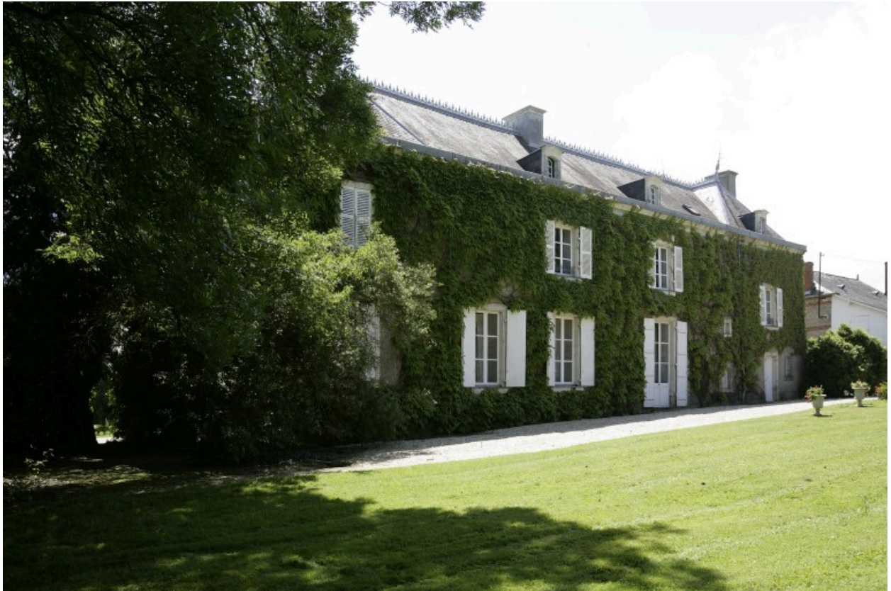
La maison de maître vue depuis le nord-est : la façade postérieure.
