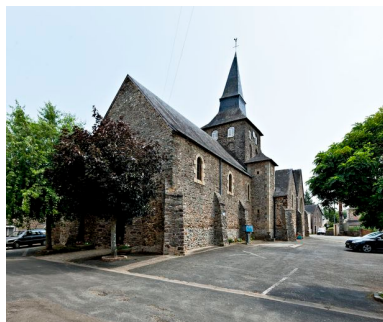
Vue d'ensemble depuis le le sud-ouest. Phot. Yves Guillotin IVR52_20155300210NUCA
