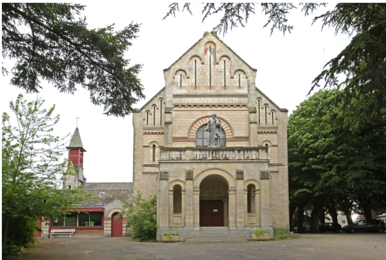
La façade de la chapelle, vue depuis le nord-est.
