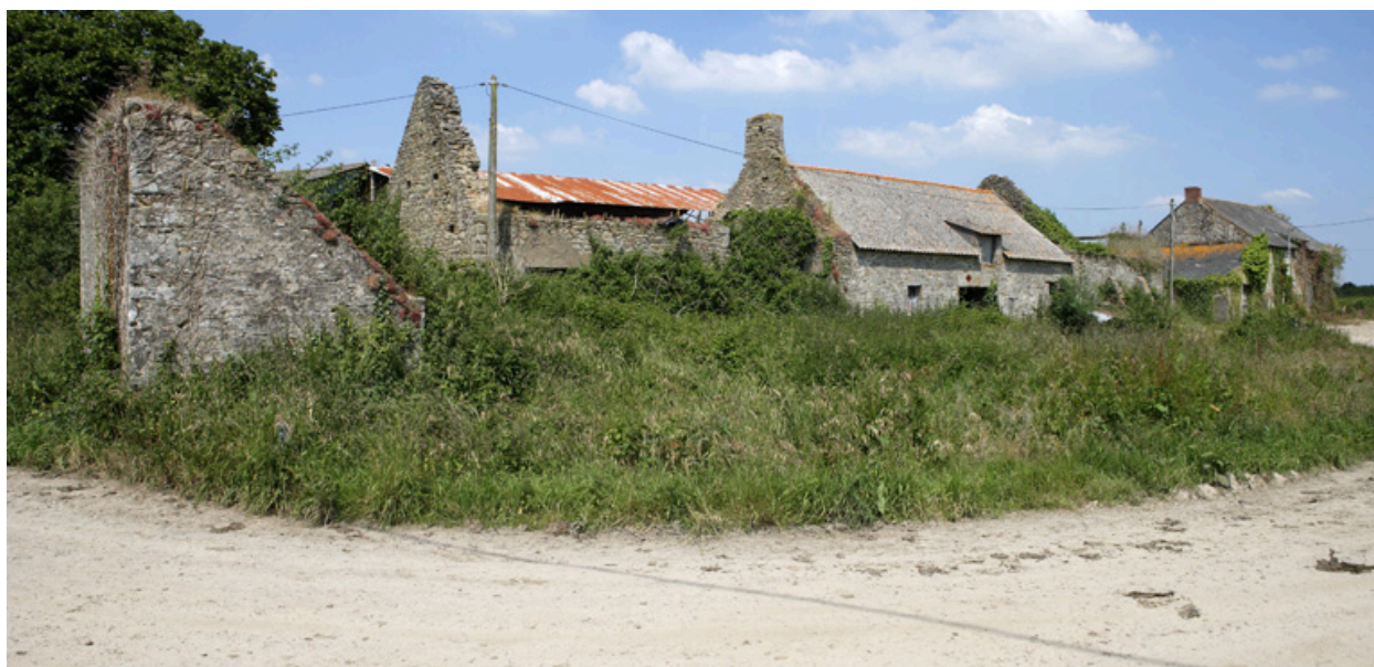
Bâtiment ouest. Métairie (?). Vue d'ensemble depuis le sud-ouest.
