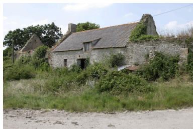
Bâtiment est. Métairie (?). Vue d'ensemble depuis le sud-est. Phot. Denis Pillet IVR52_20084401892NUCA
