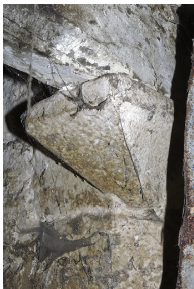
Bâtiment est. Métairie (?). Détail de la console de droite supportant la hotte de la cheminée. Phot. Denis Pillet IVR52_20084401932NUCA
