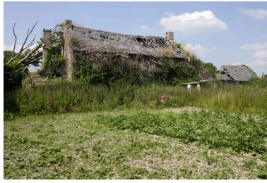
Logis sud. Vue depuis le sud. Phot. Denis Pillet IVR52_20084401905NUCA
