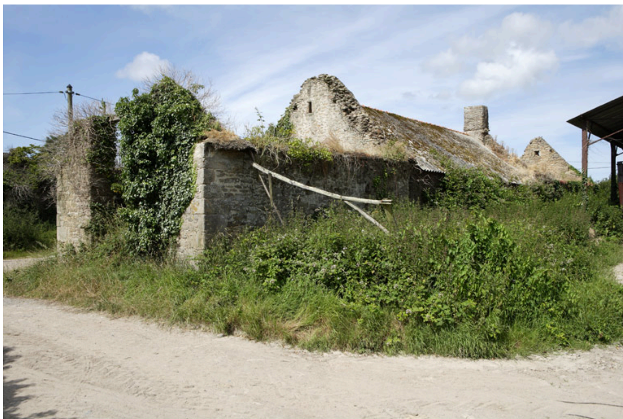
Bâtiment est. Métairie (?). Vue depuis le nord-est.
