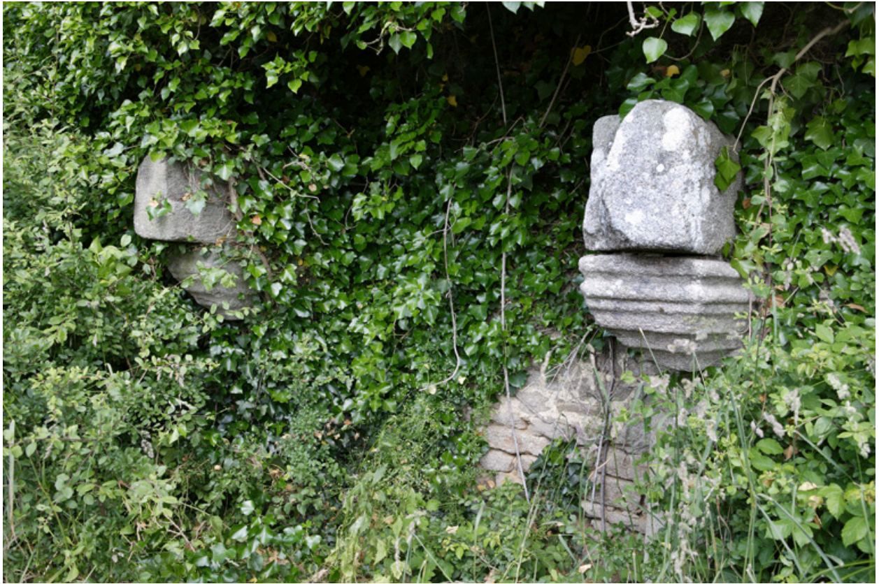
Bâtiment ouest. Logis noble (?). Vue de la cheminée sur le mur pignon ouest.
