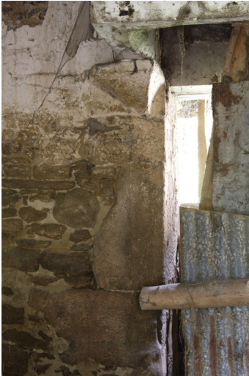
Bâtiment est. Métairie (?). Détail de la console de gauche supportant la hotte de la cheminée.
