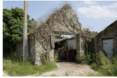
Remise sud-est. Phot. Denis Pillet IVR52_20084401896NUCA
