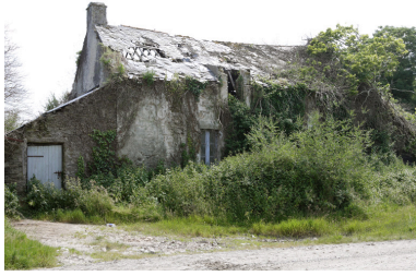
Logis sud. Vue de la façade nord. Phot. Denis Pillet IVR52_20084401890NUCA
