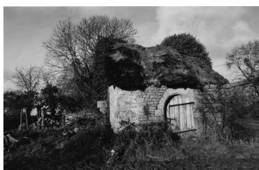
Bâtiment ouest. Logis noble (?). Vue d'ensemble depuis le sud. 1990. Phot. Denis (reproduction) Pillet IVR52_20094401430NUC
