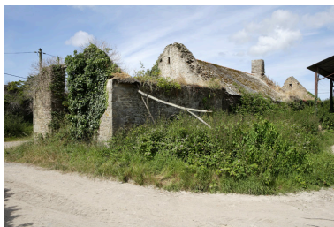
Bâtiment est. Métairie (?). Vue depuis le nord-est. Phot. Denis Pillet IVR52_20084402014NUCA
