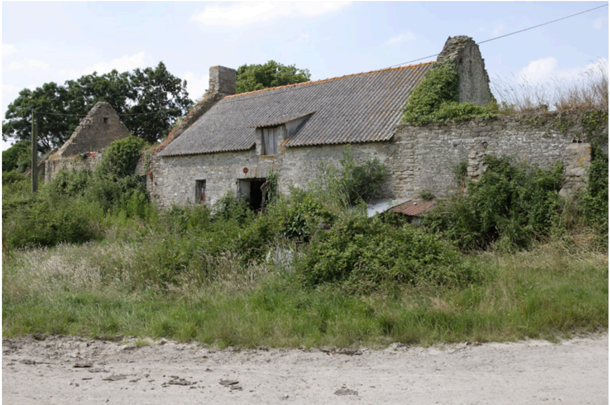
Bâtiment est. Métairie (?). Vue d'ensemble depuis le sud-est.
