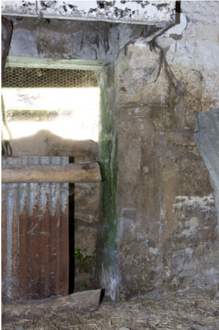
Bâtiment est. Métairie (?). Détail de la console de droite supportant la hotte de la cheminée.
