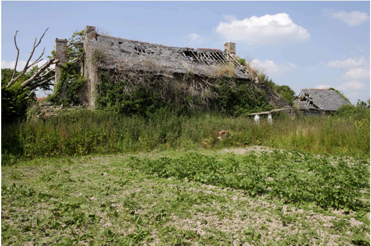
Logis sud. Vue depuis le sud.
