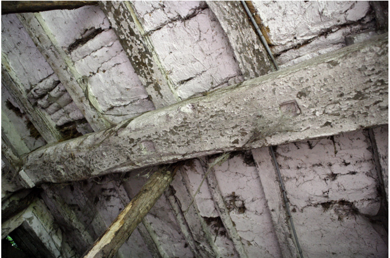
Bâtiment est. Métairie (?). Détail du plancher.
