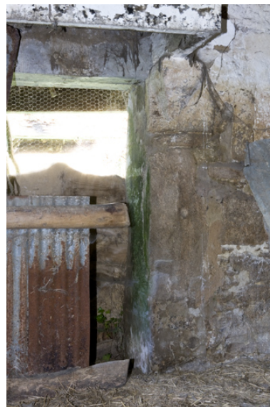
Bâtiment est. Métairie (?). Détail de la console de droite supportant la hotte de la cheminée. Phot. Denis Pillet IVR52_20084402017NUCA
