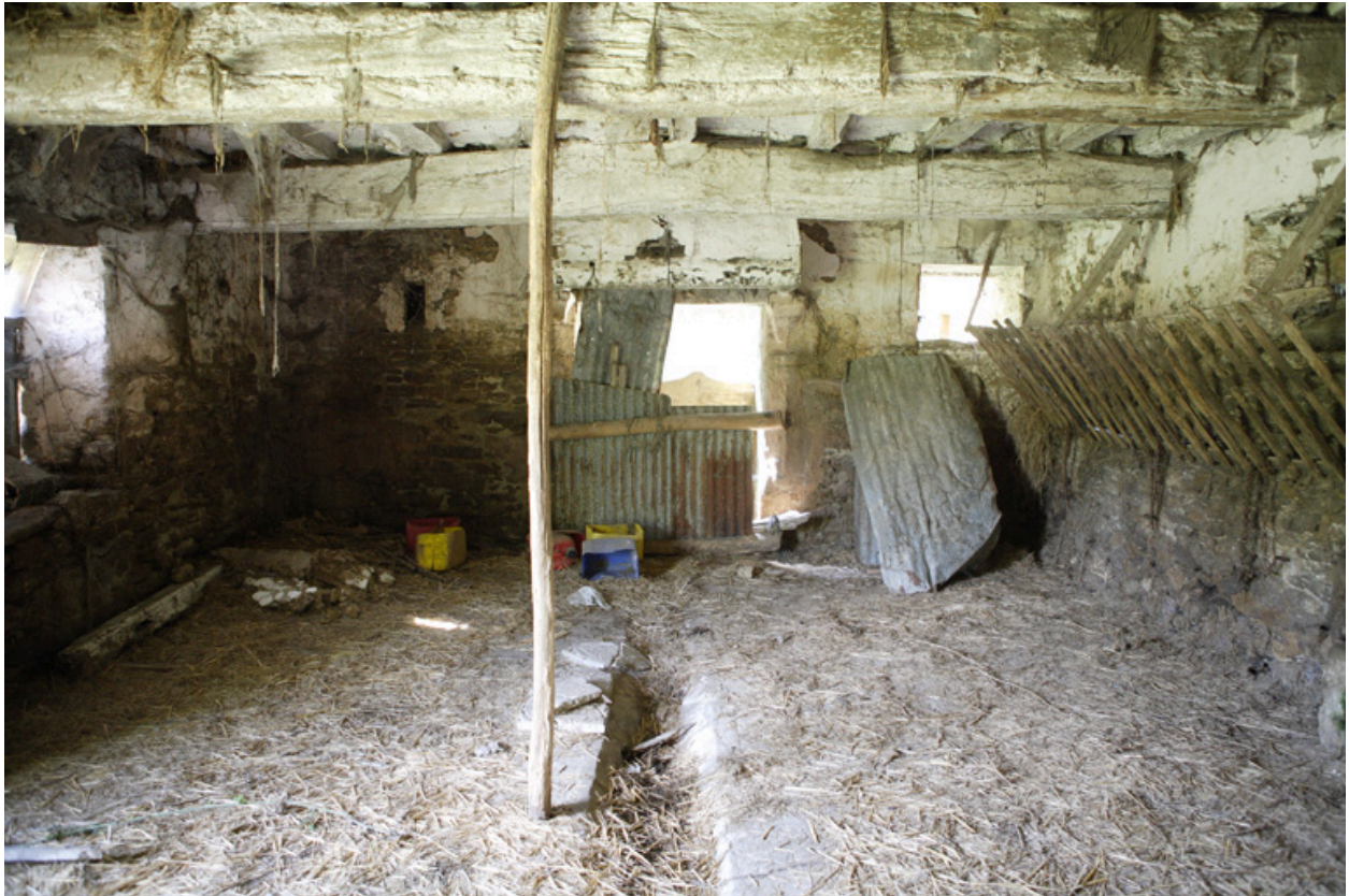
Bâtiment ouest. Métairie (?). Intérieur. Vue d'ensemble depuis l'est.
