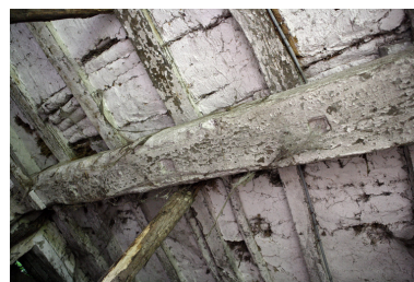
Bâtiment est. Métairie (?). Détail du plancher. Phot. Denis Pillet IVR52_20084401902NUCA
