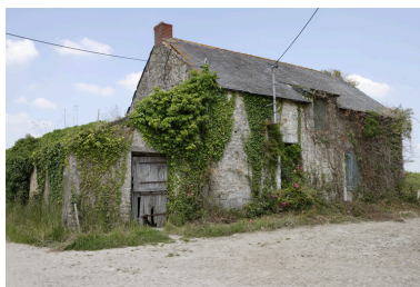
Logis est. Vue de la façade sud. Phot. Denis Pillet IVR52_20084401891NUCA
