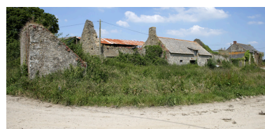
Bâtiment ouest. Métairie (?). Vue d'ensemble depuis le sud-ouest. Phot. Denis Pillet IVR52_20084401894NUCA
