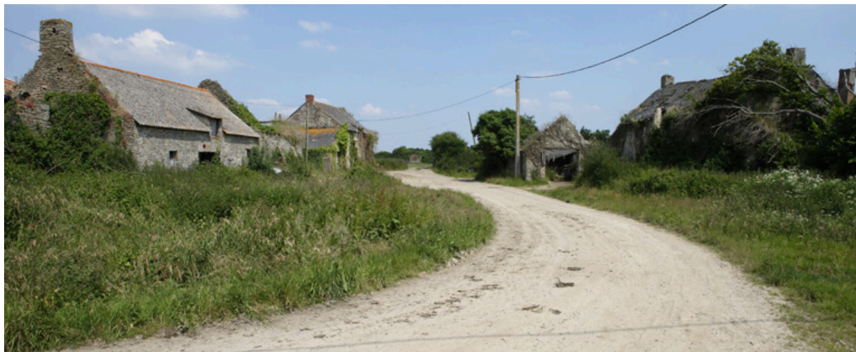
Troffigué. Vue d'ensemble des bâtiments depuis l'ouest.
