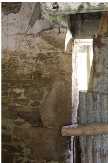
Bâtiment est. Métairie (?). Détail de la console de gauche supportant la hotte de la cheminée. Phot. Denis Pillet IVR52_20084402018NUCA
