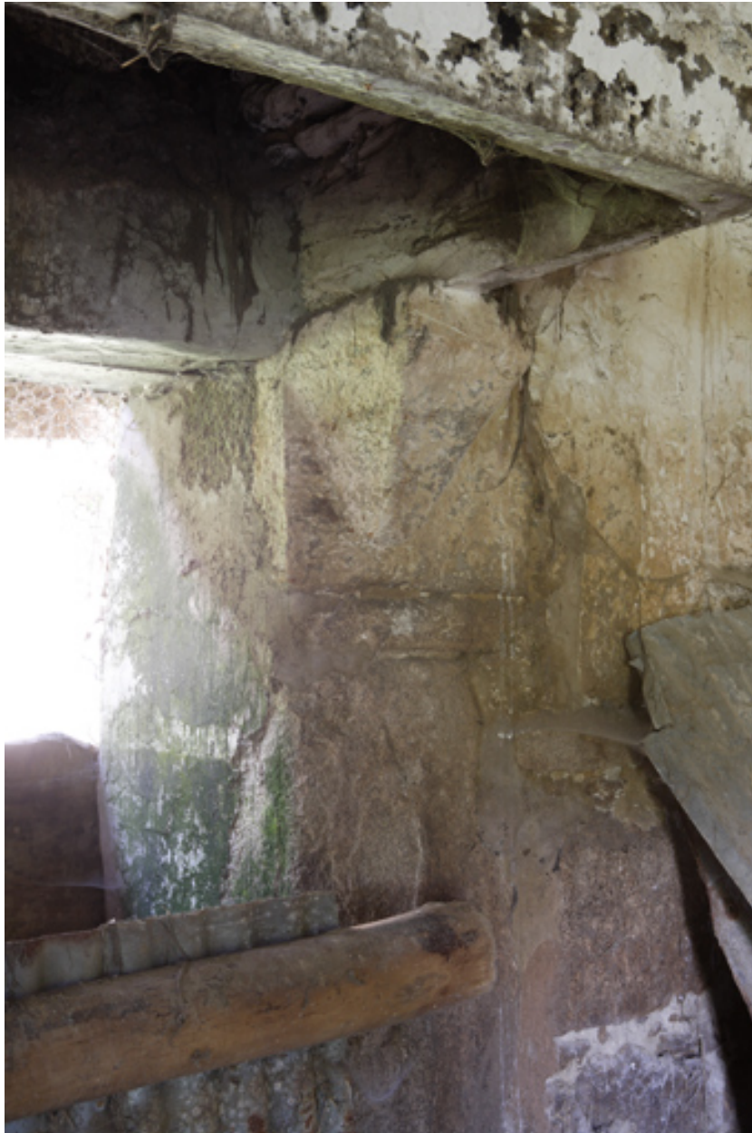
Bâtiment est. Métairie (?). Détail de la hotte de la cheminée.
