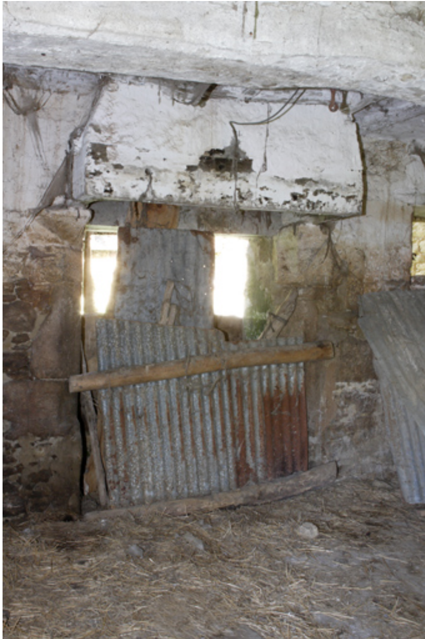
Bâtiment est. Métairie (?). Vue de la cheminée.
