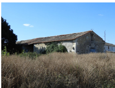
La grange-étable vue depuis le nord-est.
