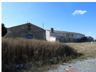
La grange-étable, à gauche, et le logis, à droite, vus depuis le nord-est.
