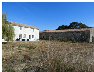
Le logis et la grange-étable vus depuis le sud-ouest.
