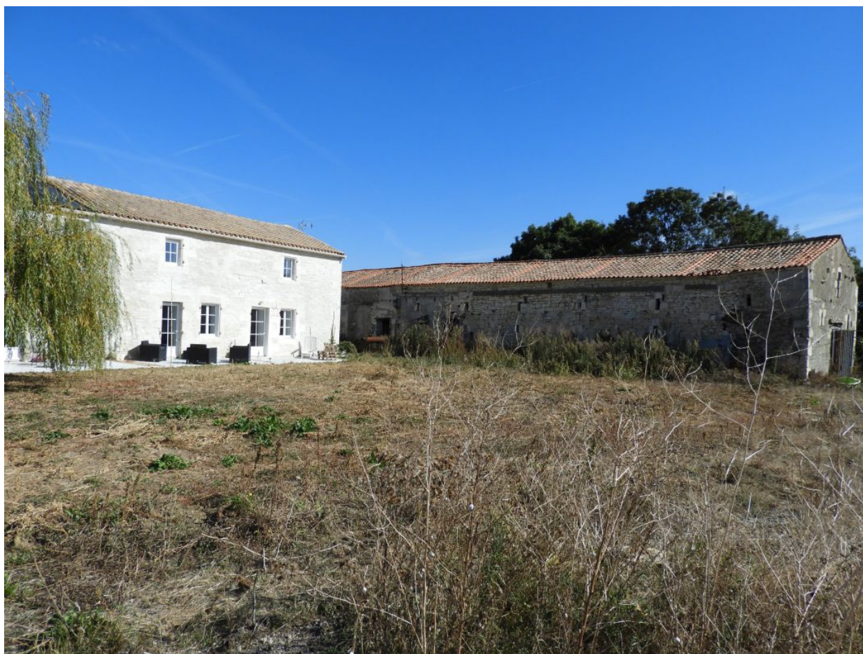
Le logis et la grange-étable vus depuis le sud-ouest.
