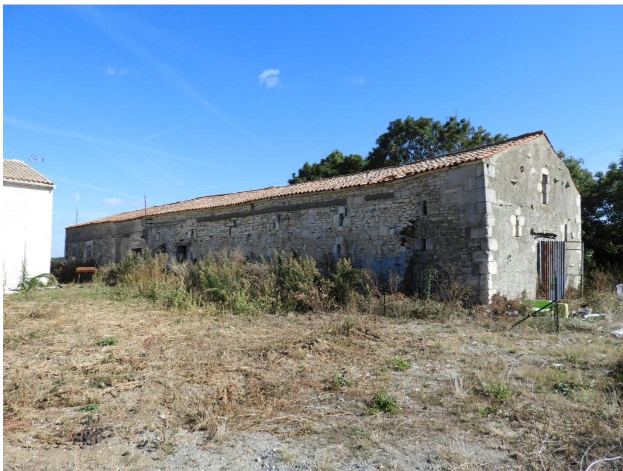
La grange-étable vue depuis le sud-ouest.
