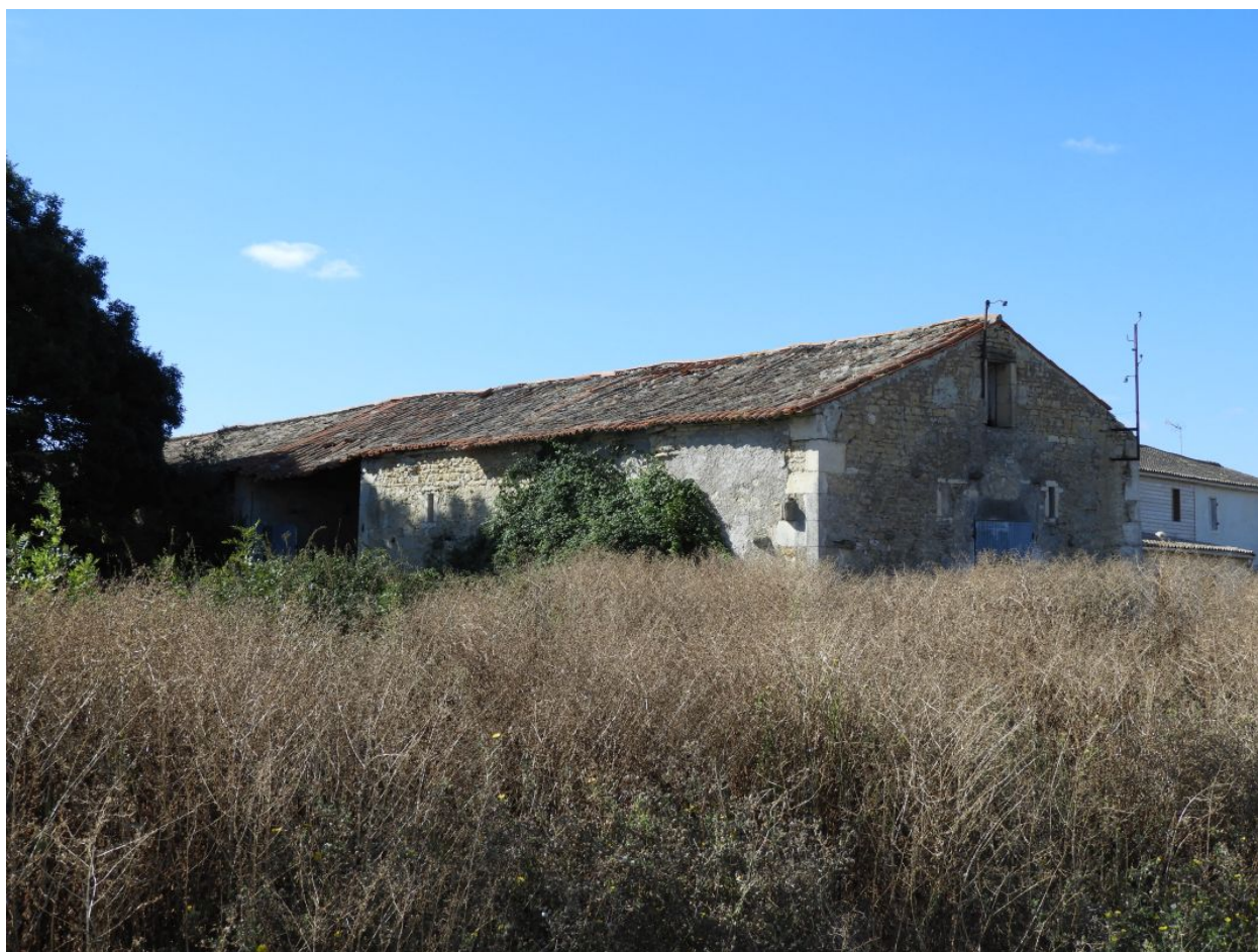
La grange-étable vue depuis le nord-est.
