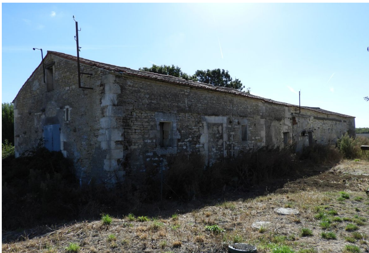
La grange-étable, à l'est de l'ensemble, vue depuis le nord-ouest.
