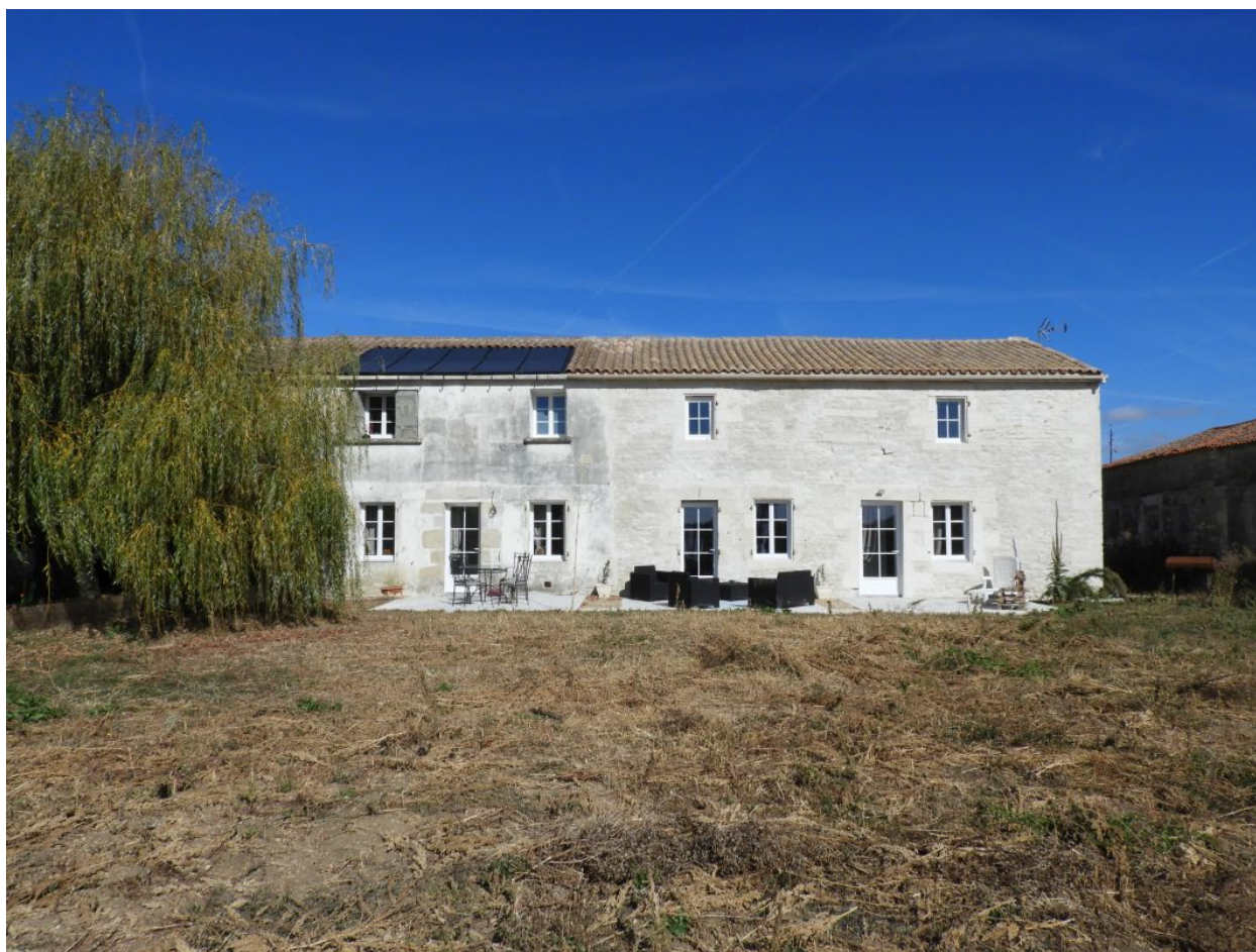
Le logis vu depuis le sud.
