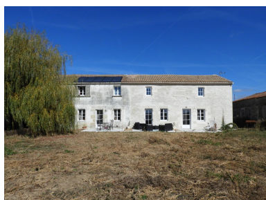
Le logis vu depuis le sud.
