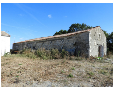
La grange-étable vue depuis le sud-ouest.
